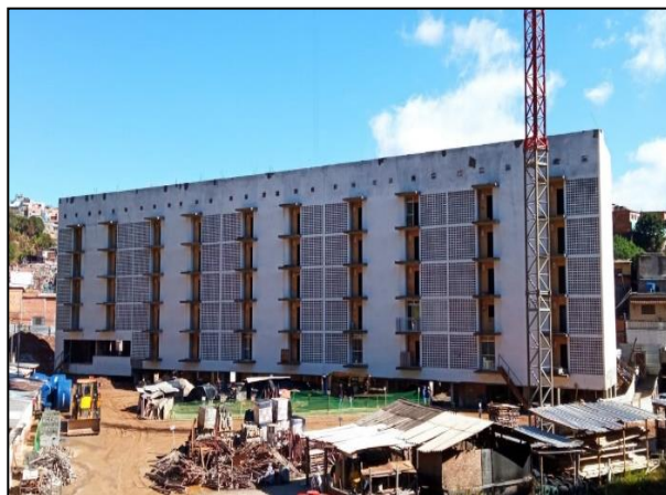
Fachada do bloco D – 48 UHs
