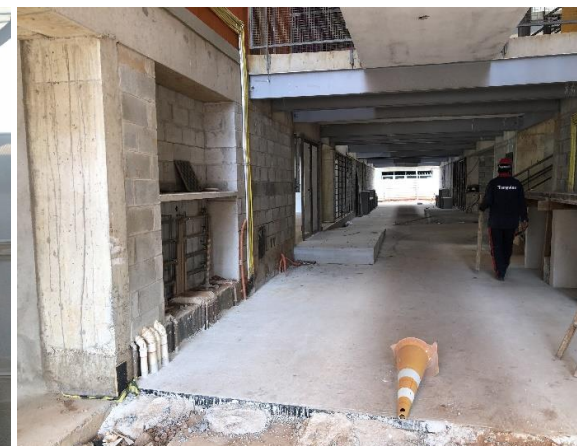
Término da concretagem de laje no térreo - C
