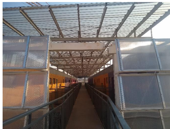
Execução e montagem de brise – bloco D
