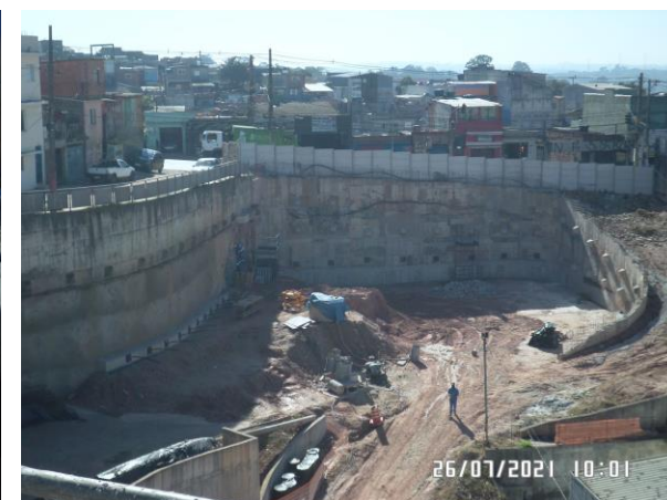
Montagem de formas - Cond. 7
