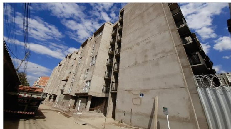
Alvenaria Estrutural Blocos D e E
