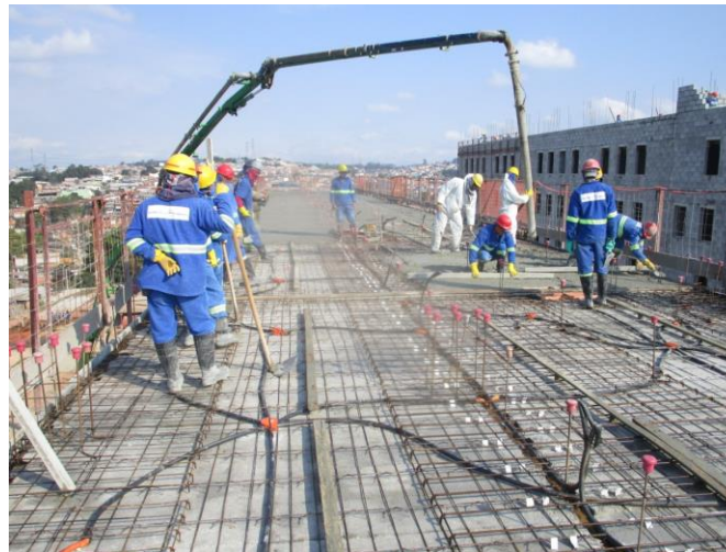
Concretagem laje da cobertura – bloco G2
