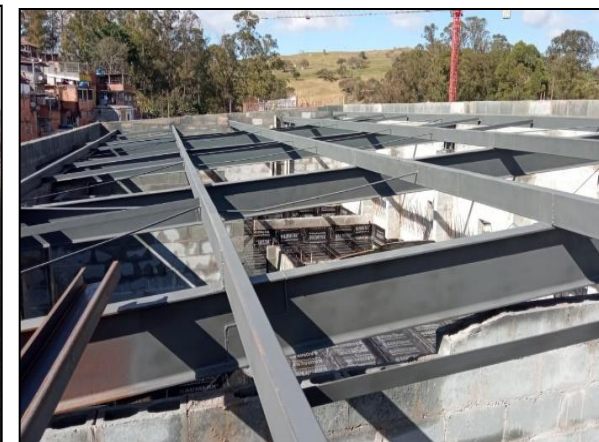
Montagem de estrutura metálica cobertura do bloco A
