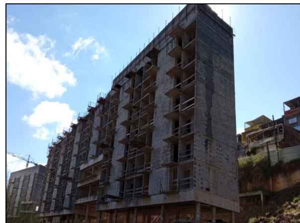
Fachada do bloco E – 78 UHs
