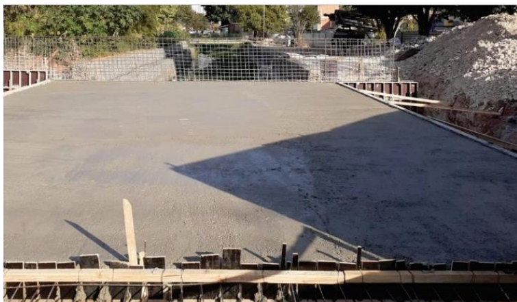
Concretagem da estrutura das galerias
