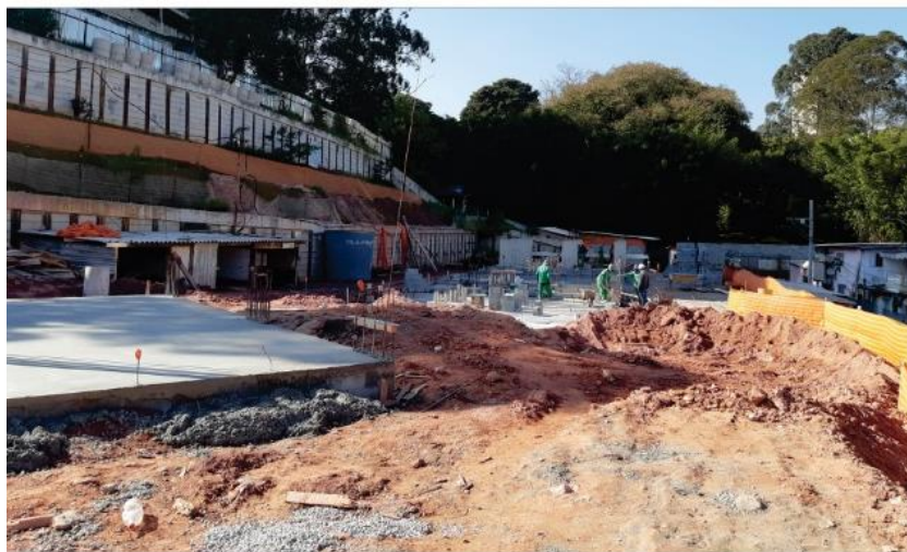
Condomínio D – Área do Bloco A
