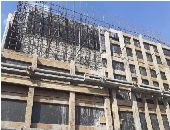
Execução de armações e formas dos pilares – Torre B
