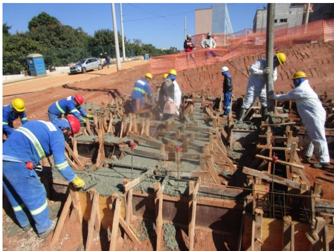
Concretagem dos blocos e vigas baldrame – bloco I3
