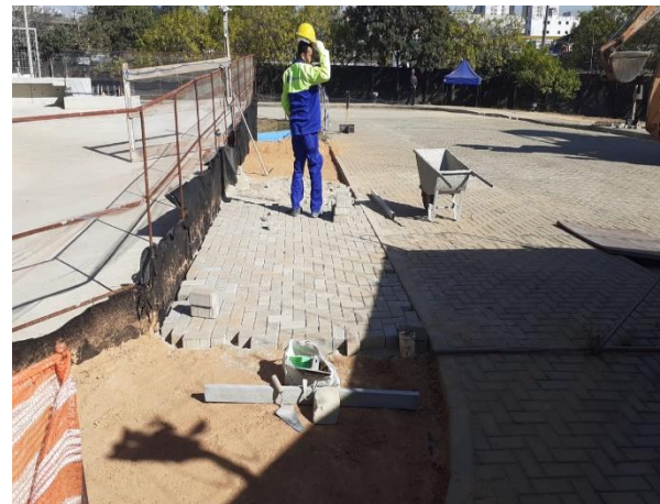
Colocação do piso intertravado sobre o reaterro do muro de contenção
