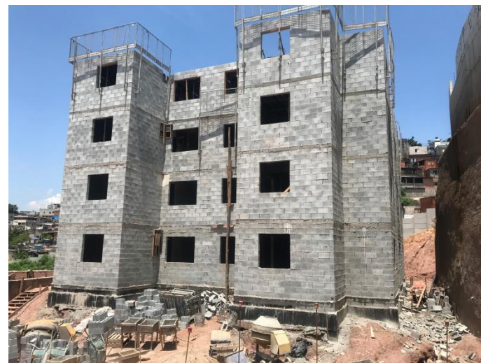
Cond. 6ª - Alvenaria do 4º pavimento
