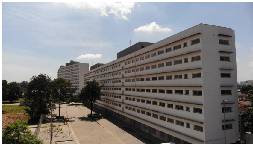
Vista Panorâmica – Torre F1 e Torre F2
