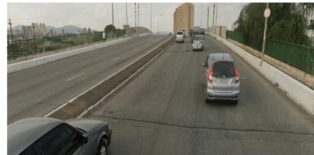
6 – Viaduto da Lapa
