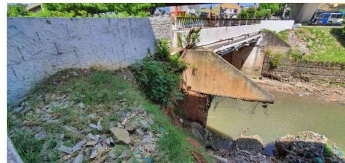
Ponte sobre o Rio Verde - Avenida Imperador x Avenida Jacu
