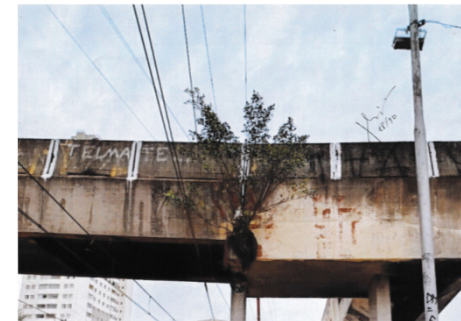
Passarela de pedestres sobre trilhos da CPTM
