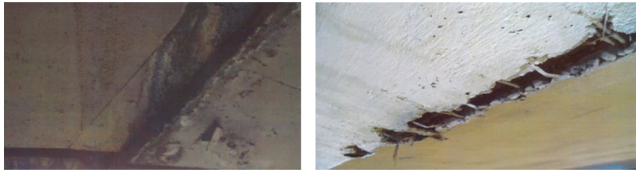
Viaduto de Interligação Av. Paulista X Av. Dr. Arnaldo-Consolação
