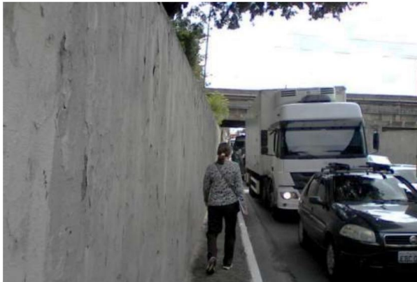
Foto 61- Trecho entre R. Paula Souza 2854 e Viaduto da CPTM - calçada estreita e insegura para a circulação de pedestres.
