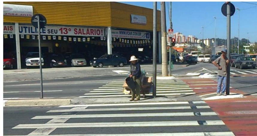
Canteiro Central muito estreito para acomodar pedestres
