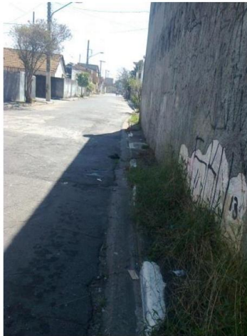
Calçada da R. Antenor Batista
