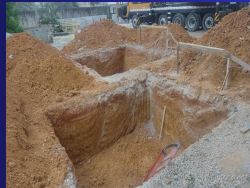
Quadra 4 - execução de infraestrutura de água e esgoto. Foto: mar/22
