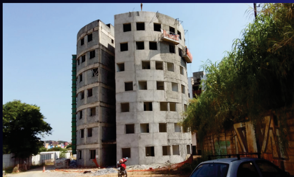
Blocos 1, 2 e 3 - Cond. 4. Foto: mar/22
