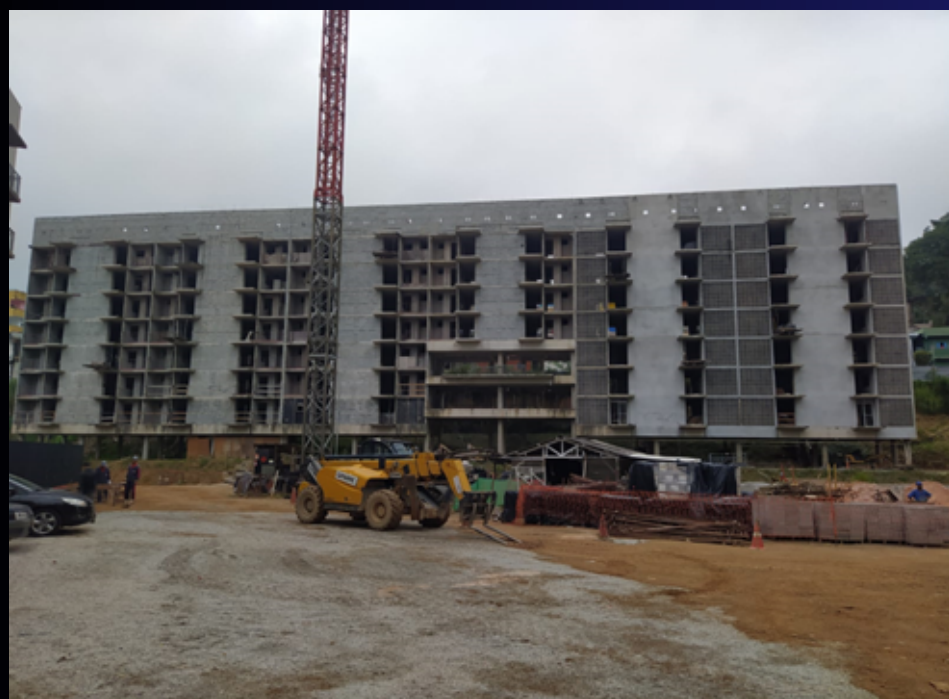
Bloco E (em execução) Fachada 78 UH's. Foto: mar/22
