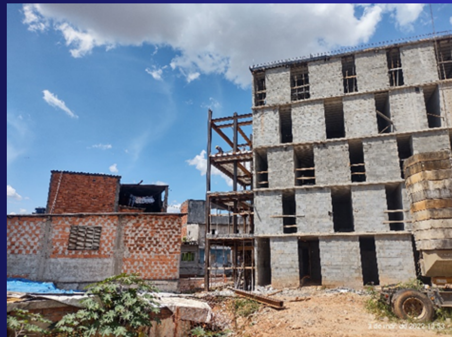
Bloco D – fachada interna para as quadras. Foto: mar/22
