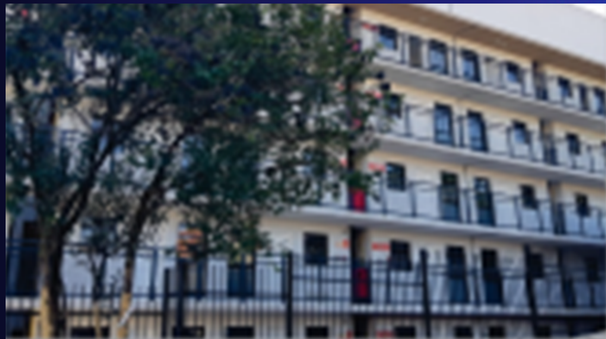
Condomínio A1 – bloco A – 108 UH´s . Foto: set/21
