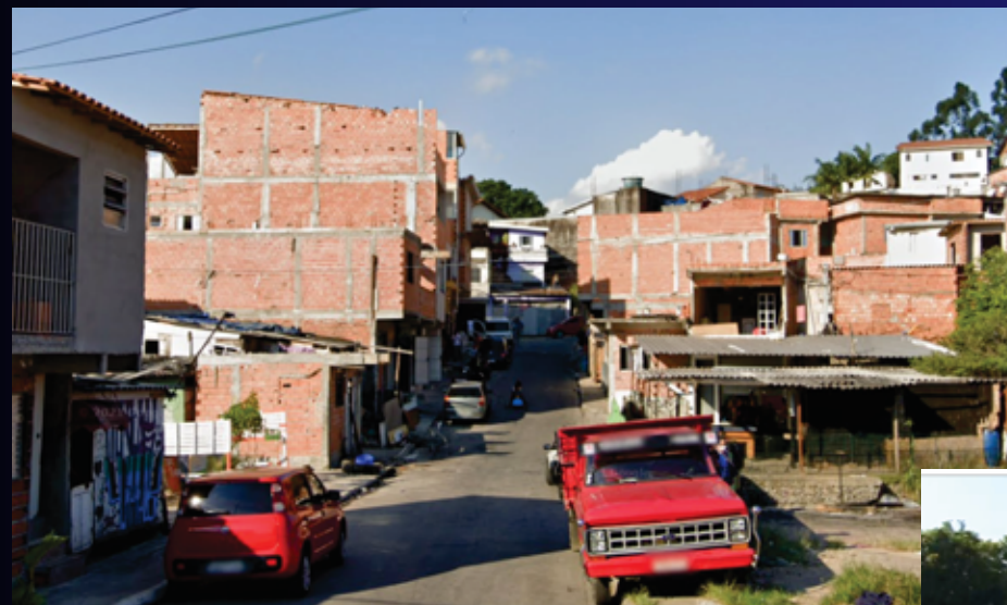
Execução de rede de esgoto. Foto: dez/21
