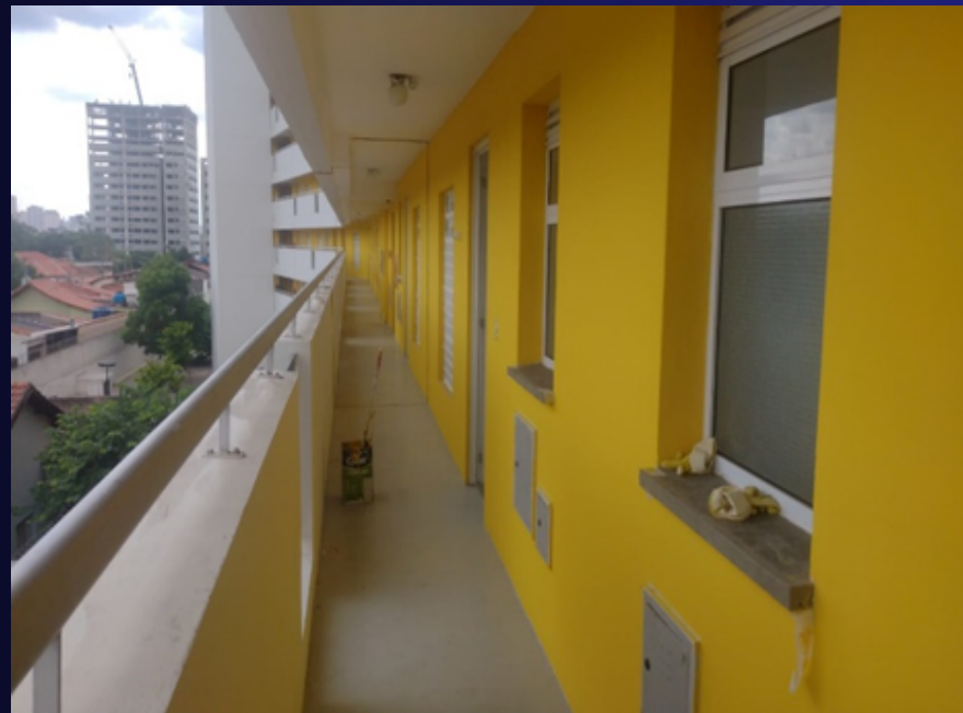
Torres F1 - pintura externa na área de circulação. Foto: mar/22
