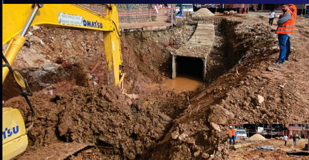
Escavação. Foto: mar/22
