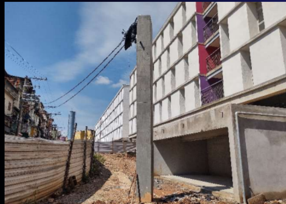
Bloco C – Fachada . Foto: mar/22
