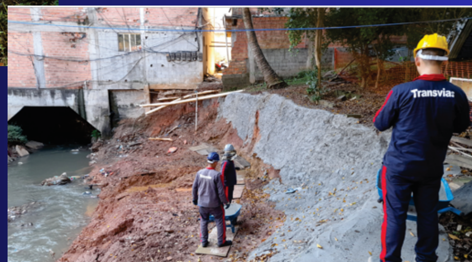
Contenção paliativa de talude em trecho da 2ª Fase. Foto: mar/22
