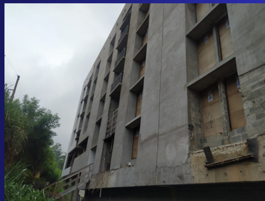
Bloco A - finalização de revestimento externo. Foto: mar/22
