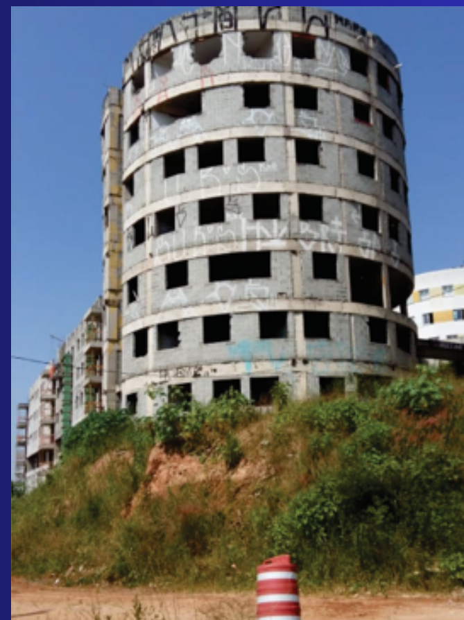
Blocos 1 e 10 - Cond. 3. Foto: mar/22
