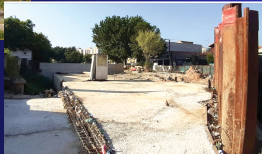
Trecho 1 do canal de águas pluviais do córrego. Foto: mar/22
