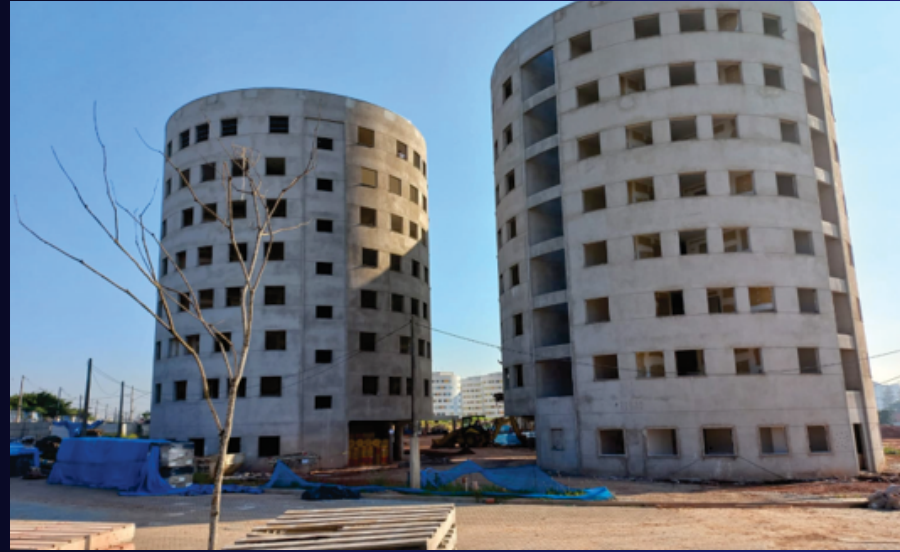
Cond. 4 - Estruturas. Foto: mar/22
