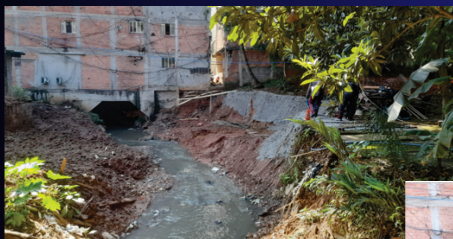
Contenção paliativa de talude em trecho da 2ª Fase. Foto: mar/22
