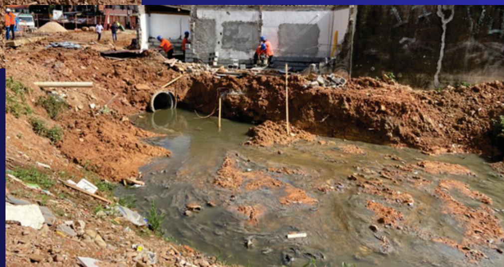
Limpeza do Córrego. Foto: mar/22
