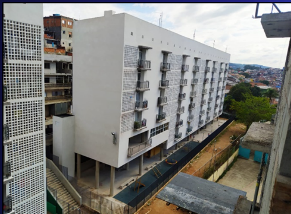
Bloco D - 48 UH's entregues em março/22. - Foto: mar/22
