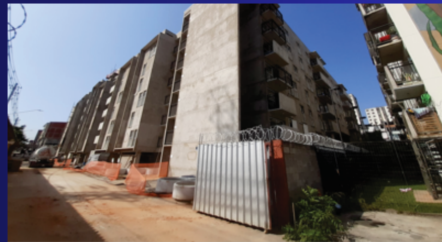
Blocos D e E - alvenaria estrutural Foto: mar/22
