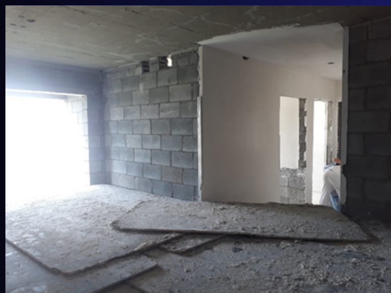
Execução de revestimento interno com gesso liso. Foto: mar/22
