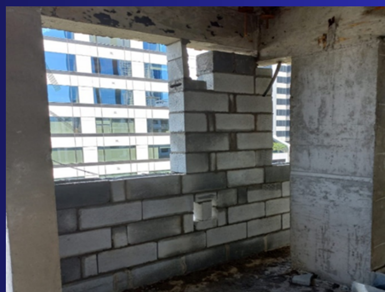
Execução de alvenaria de fechamento. Foto: mar/22
