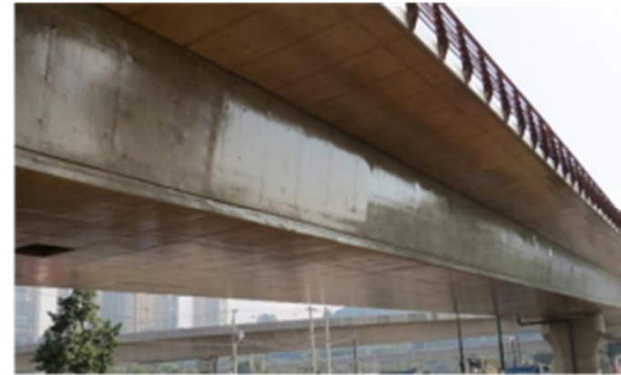
Com o tratamento superficial do concreto.
