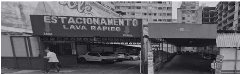
Edificações com baixo índice construtivo
