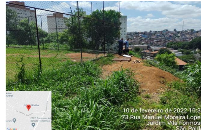
Rua Floriza, altura do nº 376 – SUB AF
