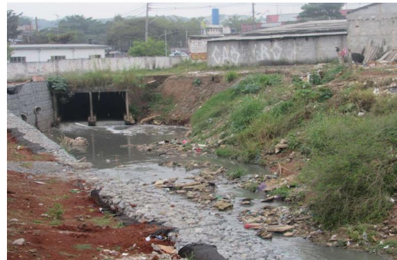
Rua Milagre dos Peixes – SUB CT
