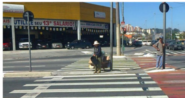
Canteiro Central muito estreito para acomodar pedestres
