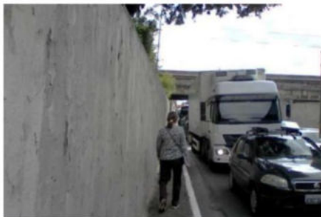
Foto 61 - Trecho entre R. Paula Souza 2854 e Viaduto do CPTM: calçada estreita e insegura para a circulação de pedestres.
