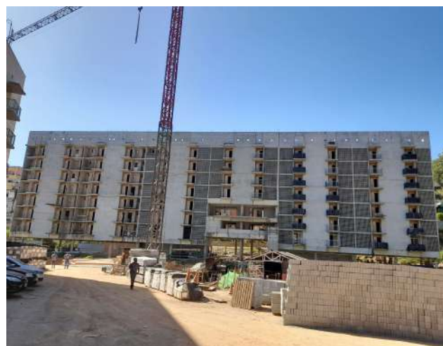
Bloco E – 78 Uhs. Foto: jun/22
