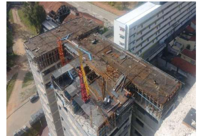
Quadra 4 - Torre 1 – 10º pav. – execução de armações e formas da laje. Foto: jun/22
