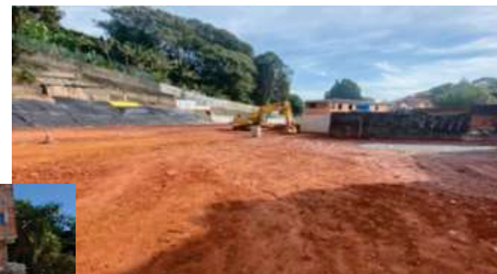
Terraplanagem – Foto: jun/22
