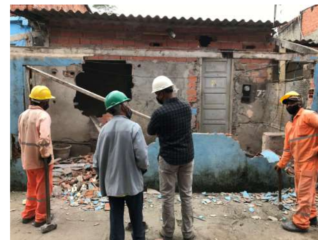
Demolições – Jardim Angela - Foto: jun/22
