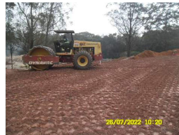
Compactação de camada de aterro – Cavalo Branco – Foto: jul/22
