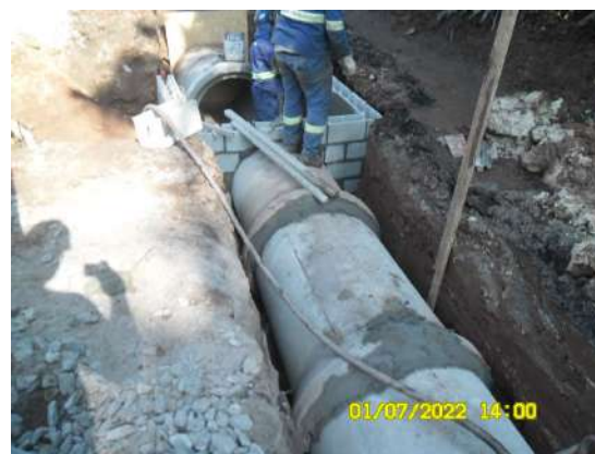
Execução de rede de drenagem – Chácara Flórida - Foto: jul/22
