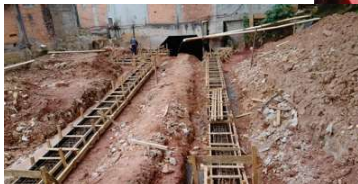
Forma e armação da viga de coroamento - Foto: jun/22
