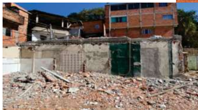
Demolição do Trecho 1ª - Foto: jun/22
