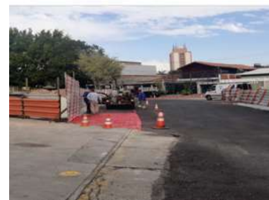
Reforço do pavimento – Foto: jun/22
