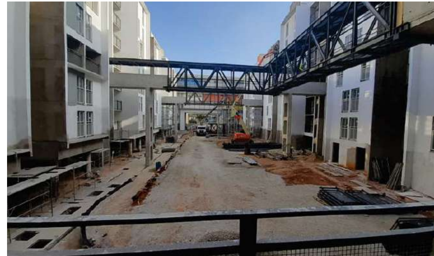
Vista Geral. Foto: jun/22
