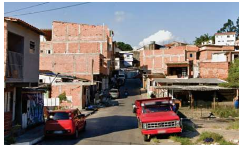
Vista da área do cond. D – Foto: jun/22
