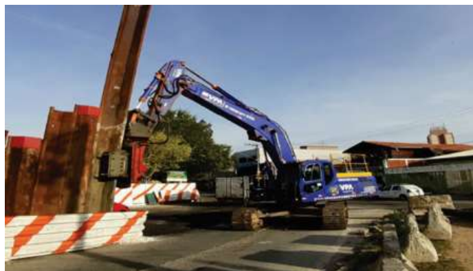
Remoção de escoramento em estaca prancha Foto: jun/22
