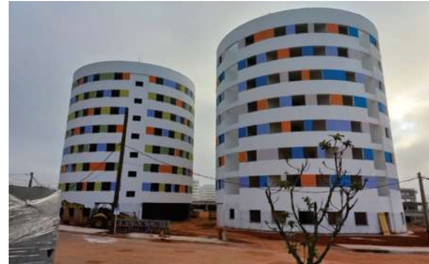
Condomínio 4 – Estruturas. Foto: jun/22
