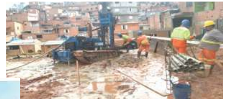
Cravação de estacas do bloco L – Foto: jun/22
