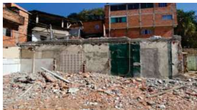
Demolição do Trecho 1ª - Foto: jun/22
