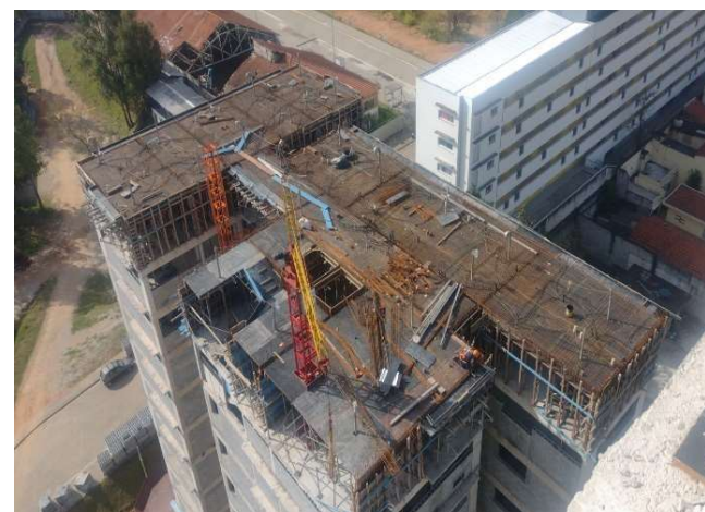
Quadra 4 - Torre 1 – 10º pav. – execução de armações e formas da laje. Foto: jun/22
