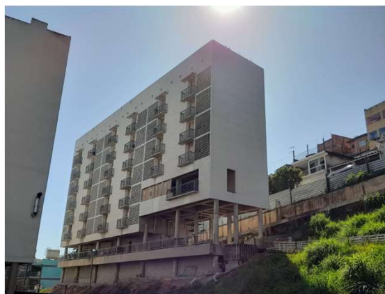
Bloco A – fachada – Foto: jun/22
