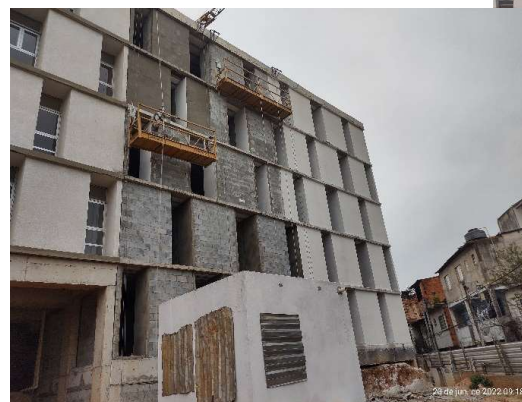
Bloco C – Vista do anexo. Foto: jun/22
