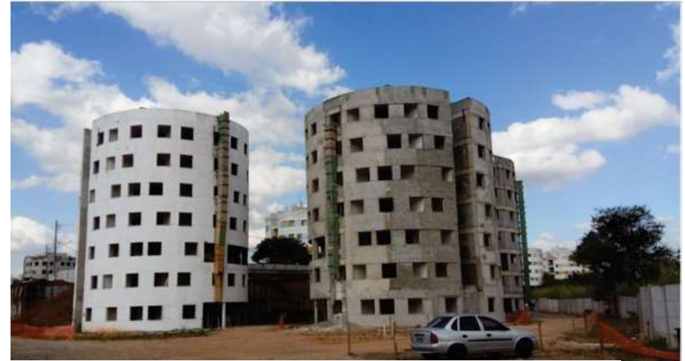
Cond. 4 – Vista da área dos blocos 1, 2 e 3. Foto: jun/22
