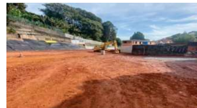
Terraplanagem – Foto: jun/22
