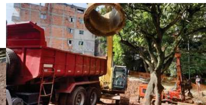
Ampliação do corta-rio – Foto: jun/22
