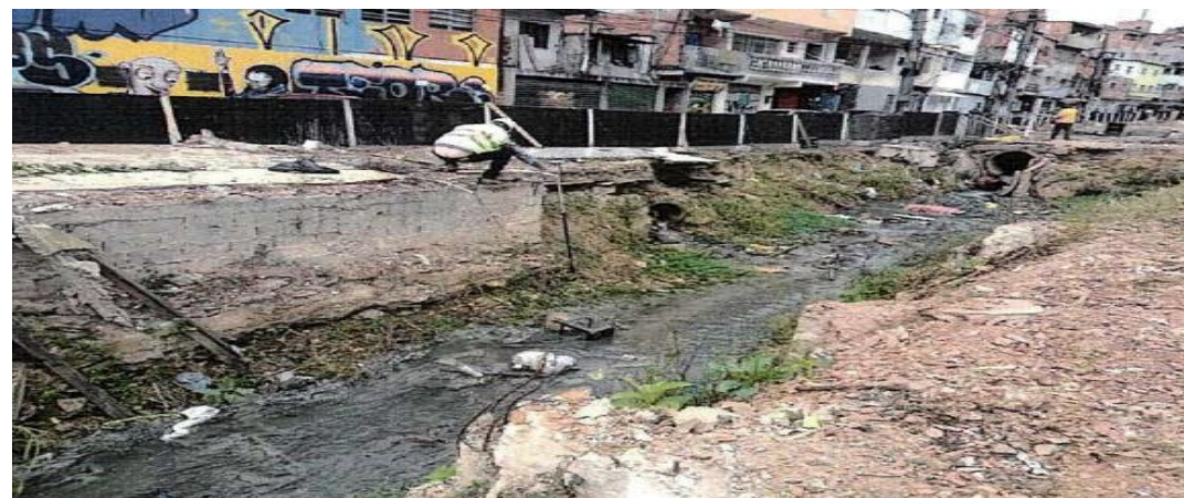
Realização do levantamento planialtimétrico no trecho 1 - Foto: jul./23
