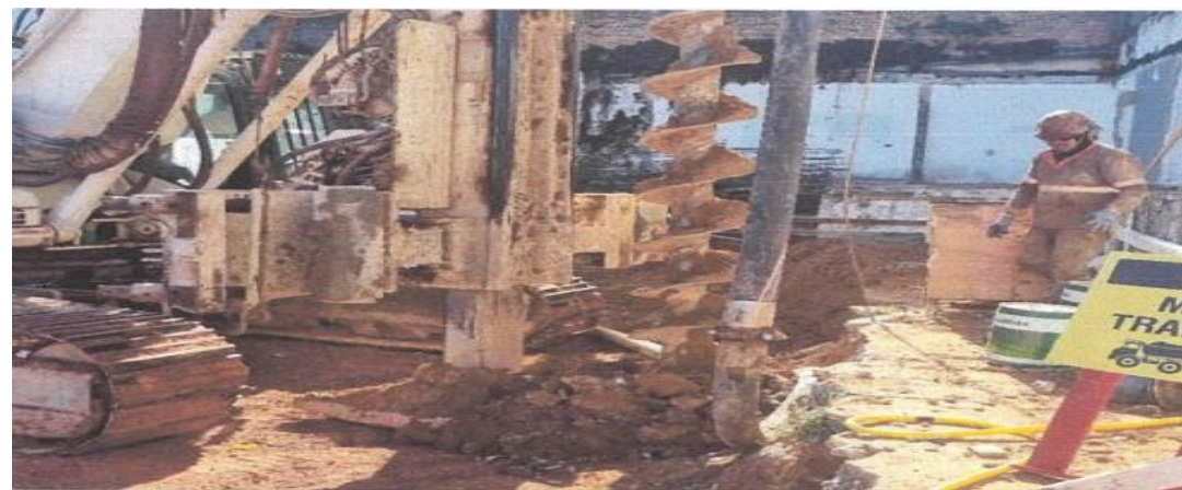
Cond. A – Estaca escavada- Foto: jun./23.
