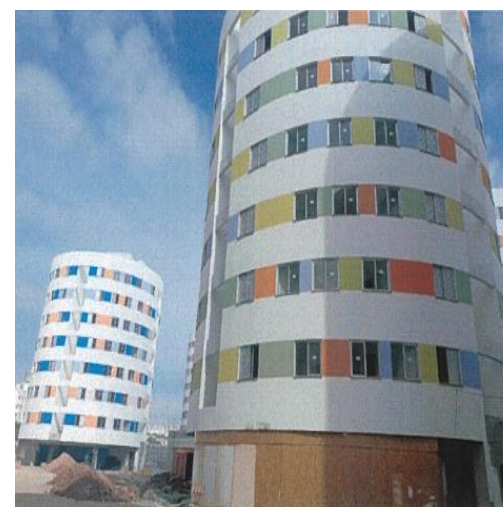
Instalação dos caixilhos e vidros Condomínio 5 – Foto: jul./23
