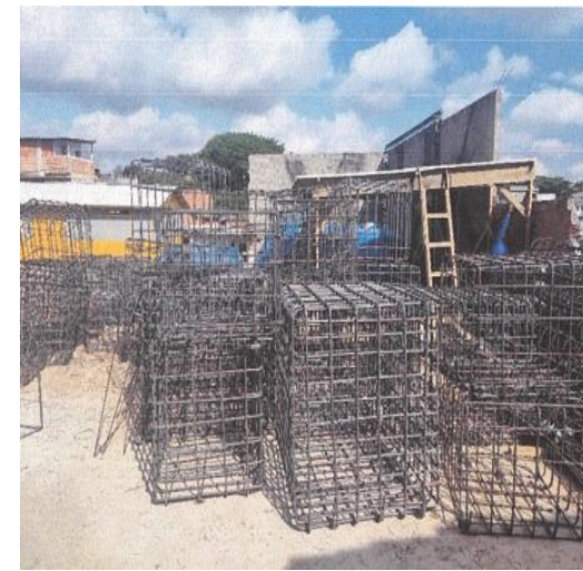
Cond. A - Armadura em aço CA-50 Foto: jun./23.
