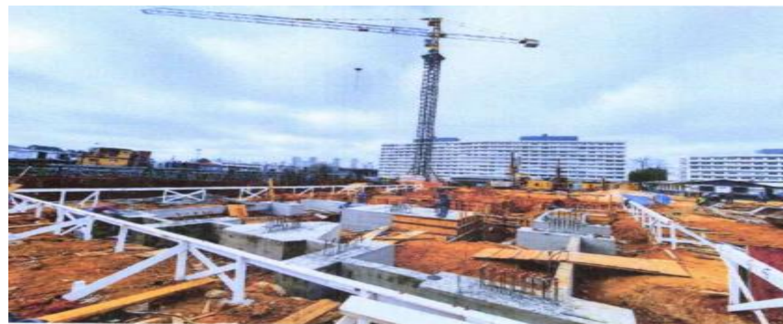
Blocos e Baldrames concretados da torre 3 – Foto: jul./23.
