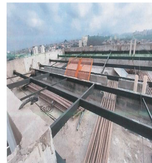
Torre A – Estrutura metálica da cobertura – Foto: jun./23.
