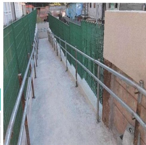
Gradil e Corrimão - Fotos: jun/23
