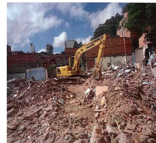
Movimentação de terra – Foto: jul./23
