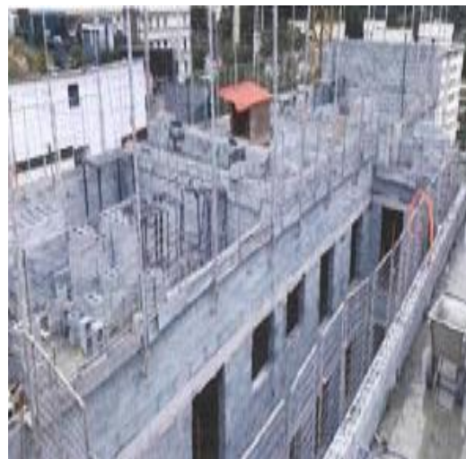
Alvenaria Estrutural- Fotos: jul./23
