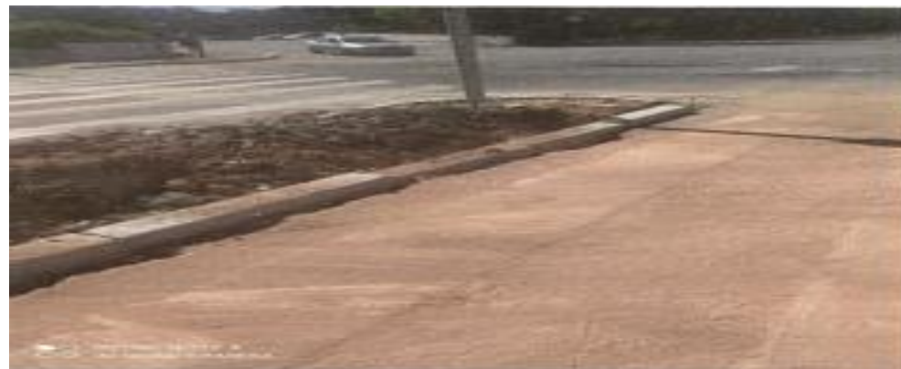
Colocação de Guias retas e aplicação de terra – Fotos: jun./23.
