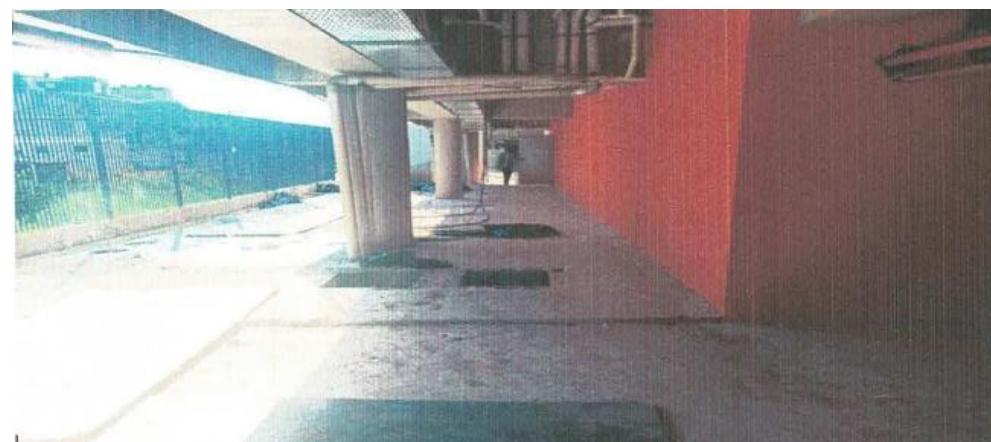
Bloco E – Piso de concreto - Fotos: jun./23.
