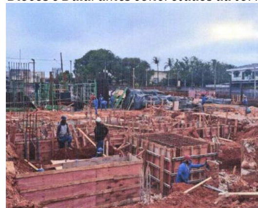
Execução de forma dos blocos e baldrames da torre 2 - Foto: jul./23
