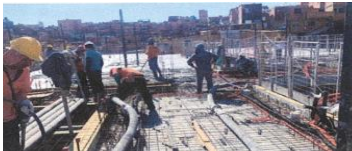
Laje – Forma, Armação e Conduítes – Fotos: jul./23.
