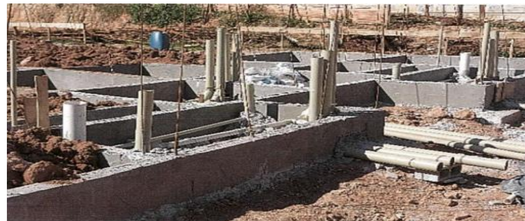
Instalações hidráulica – Fotos: jun/23.
