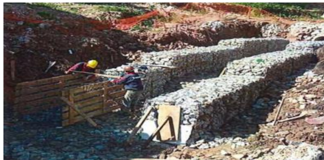
Erundina - Canalização do córrego – Fotos: jul/23
