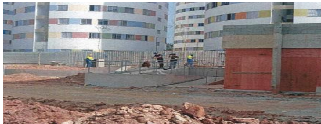
Instalação de corrimão da rampa - Condomínio 5 - Foto: jul./23
