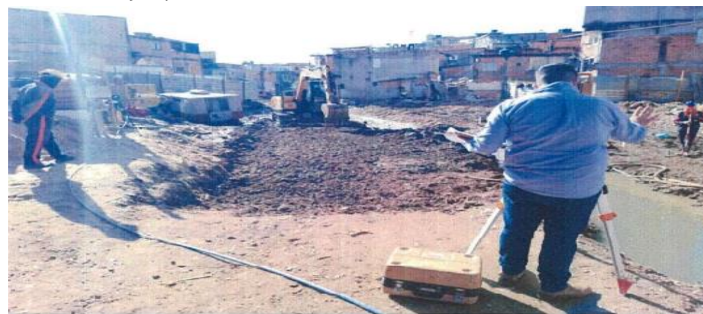
Fase 4 – Levantamento Topográfico (Locação das estacas)– Fotos: jun./23.
