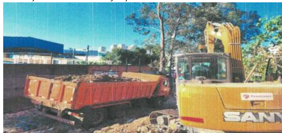
Remoção de terra terreno próximo ao Carrefour - Foto: jun./23.
