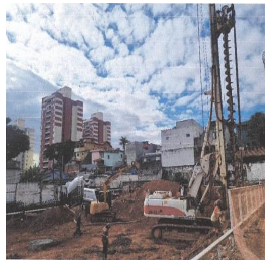
Cond. A – Estaca escavada- Foto: jun./23.
