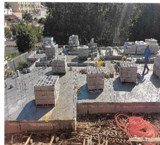
Laje e Marcação de alvenaria - Fotos: jun/23
