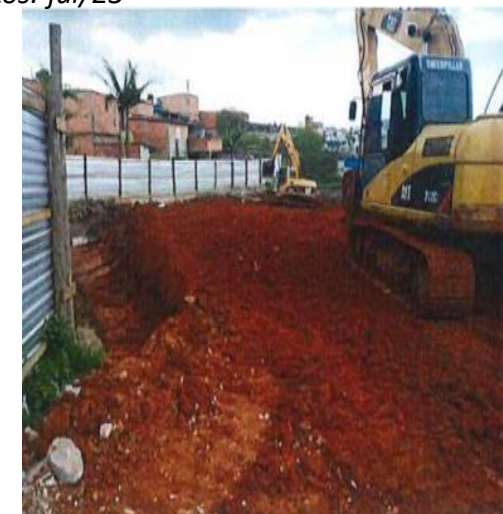
Nova Grajaú- Fornecimento, aterro e compactação de terra. - Fotos: jul./23.
