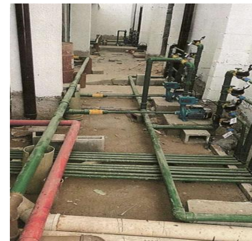
Pintura de tubos cond. D - Foto: jun./23.
