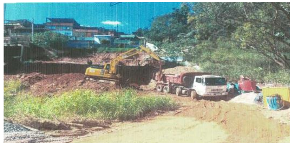
Bloco E – Remoção de terra - Fotos: jun/23.
