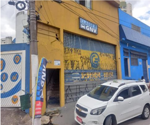
Figura 04a: Fotos tiradas em visita técnica (10/03/2023)
