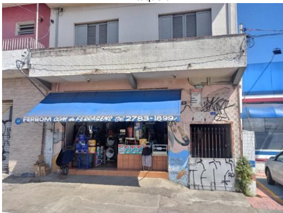
Figura 05c: Imóveis a serem desapropriados no Cruzamento com a Av. Itaquera
