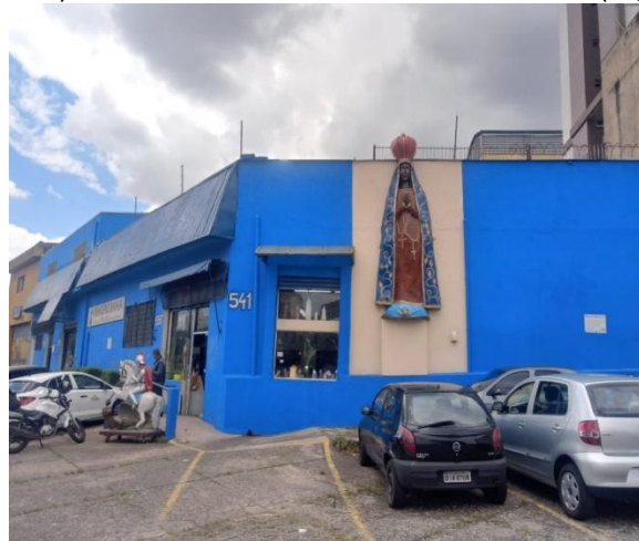
Figura 04c: Fotos tiradas em visita técnica (10/03/2023)
