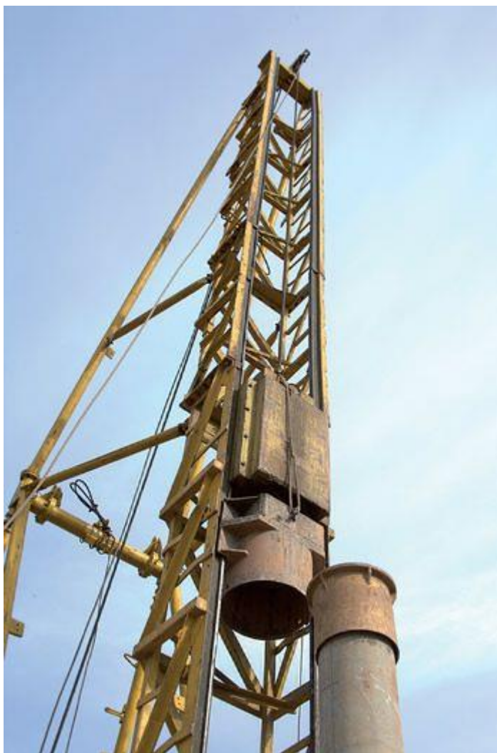
A cravação das estacas pré-fabricadas de concreto normalmente ocorre pelo processo de percussão com martelos de queda livre. Durante o processo, deve ser realizado o controle de nega e repique
