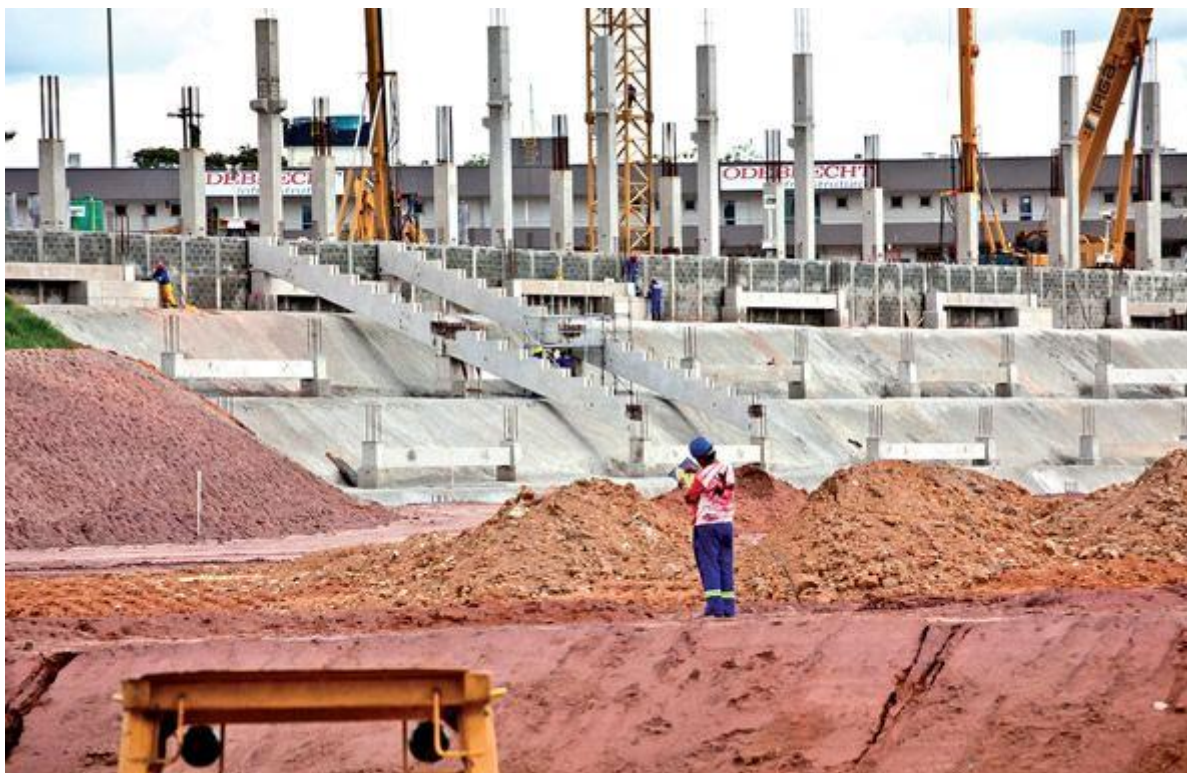
Na Arena Corinthians, em São Paulo, foram utilizadas 3.100 estacas pré-moldadas de concreto, além de 594 pilares igualmente pré-moldados, 3.174 vigas e 11.682 lajes. Parte das peças foi produzida no próprio terreno da Arena e parte em uma fábrica localizada em Santana de Parnaíba, na Grande São Paulo
