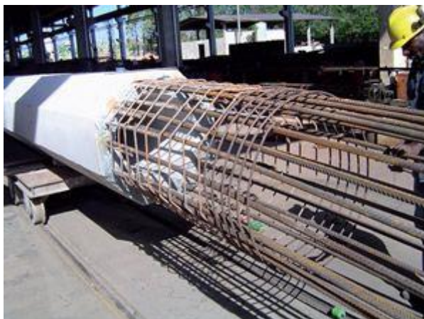
Executada pela Camargo Corrêa, a construção do Terminal de Barcaças Oceânicas da ArcelorMittal, em Vitória, empregou estacas pré-fabricadas de 90 cm de diâmetro com comprimentos de 20 m a 23 m. As peças, de seção octogonal, foram fabricadas em concreto protendido com resistência de 40 MPa e submetidas a processo de cura a vapor por 12 horas
