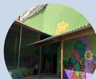
Reta Final da Reforma - SIAT III Penha
