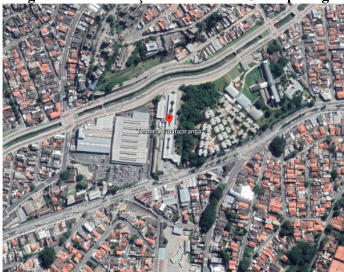
Figura 28. Localização do Terminal Guarapiranga
