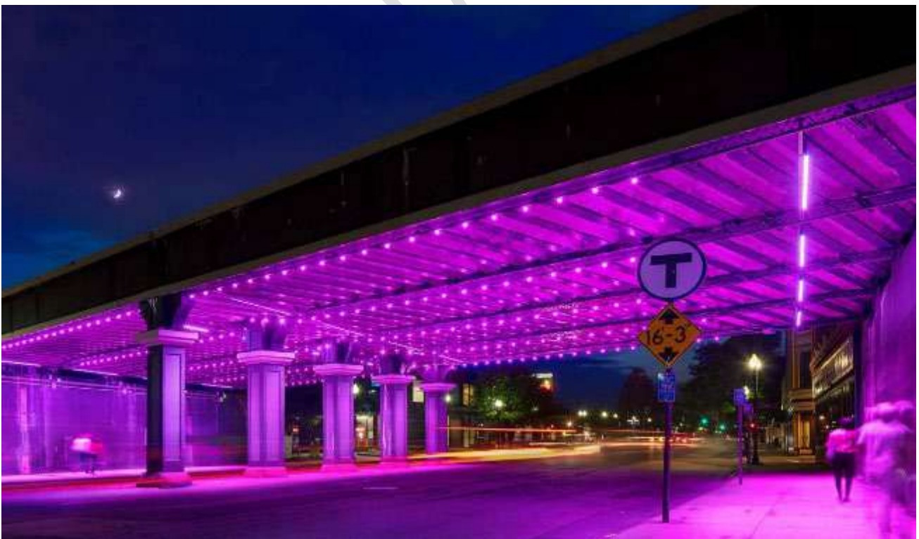
Figura 60 - Imagem de referência - Iluminação artística de viaduto
