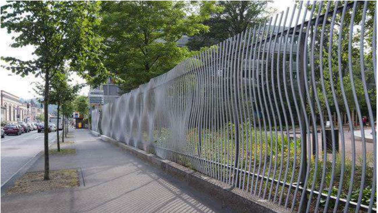
Figura 37 - Imagem de referência - gradil de fechamento
