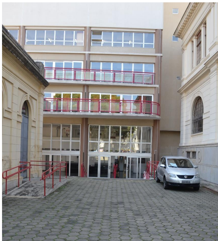
Figura 5 – Acesso ao ESPAÇO GASTRONÔMICO
