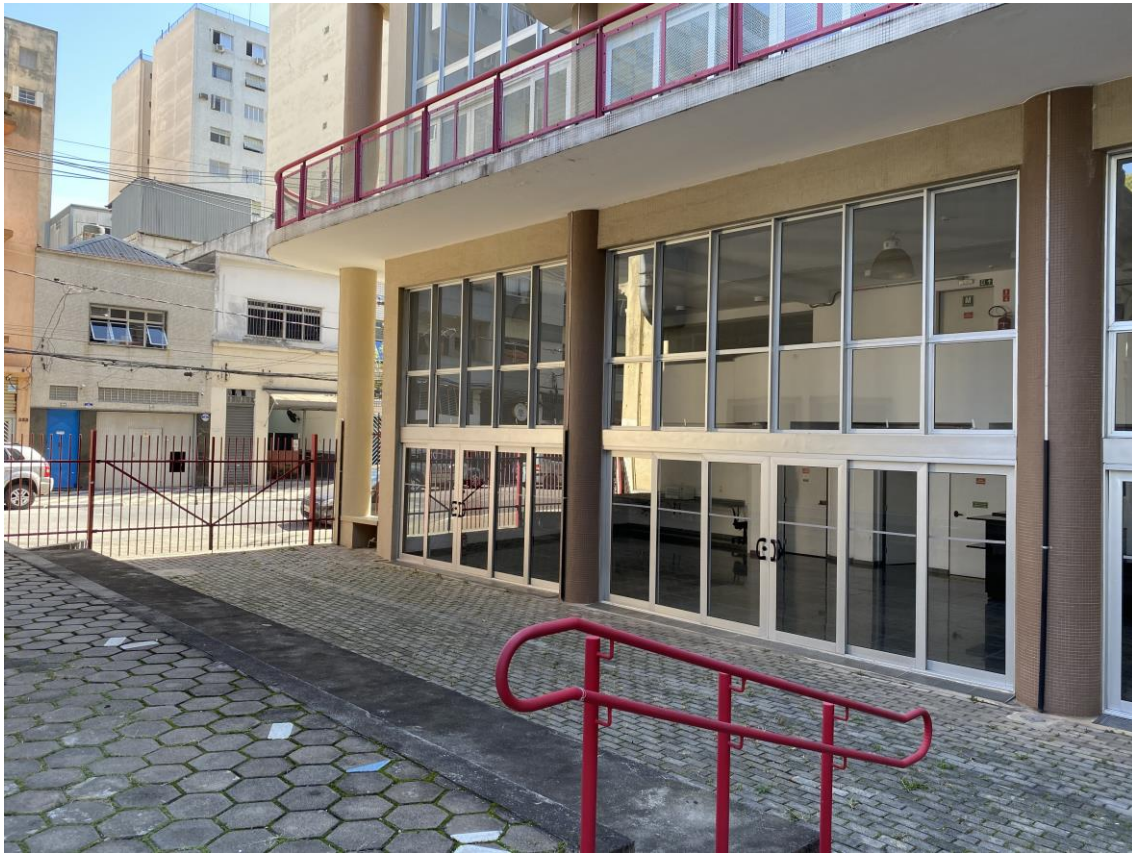
Figura 4 – Acesso ao ESPAÇO GASTRONÔMICO
