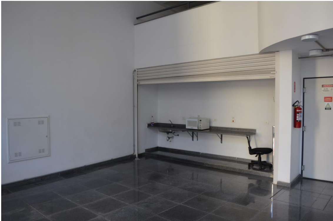
Figura 3 – Estrutura existente no local de implantação do ESPAÇO GASTRONÔMICO
