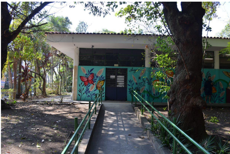
Figura 6 – Lateral direita do edifício da Biblioteca Raul Bopp
