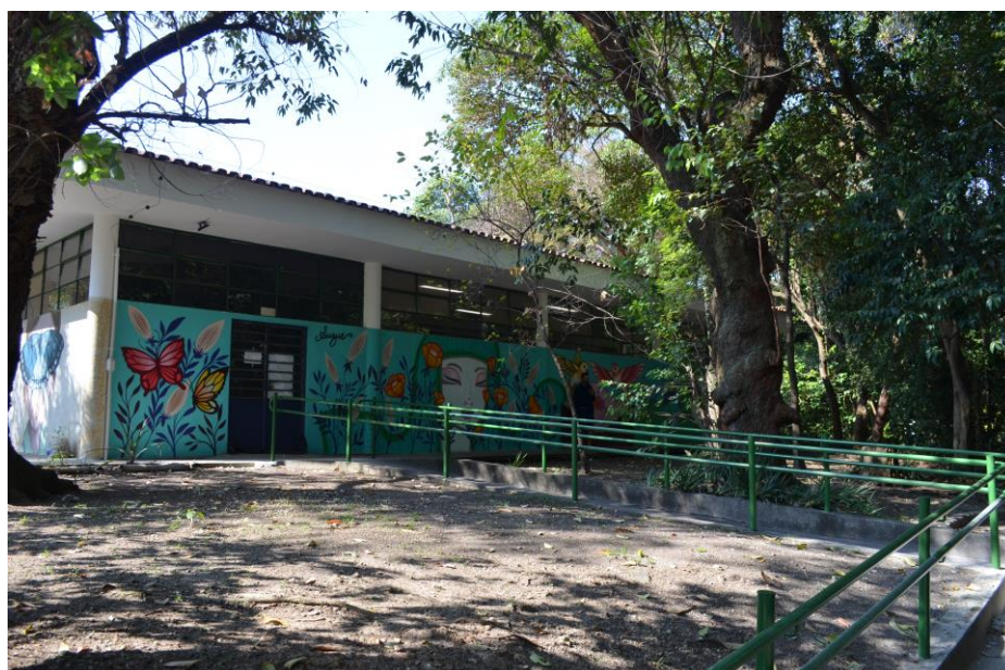
Figura 5 – Lateral direita do edifício da Biblioteca Raul Bopp
