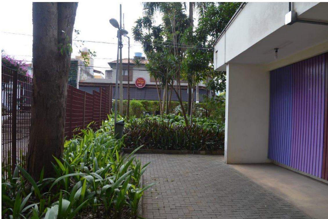
Figura 3 – Piso tetrapavimento existente
