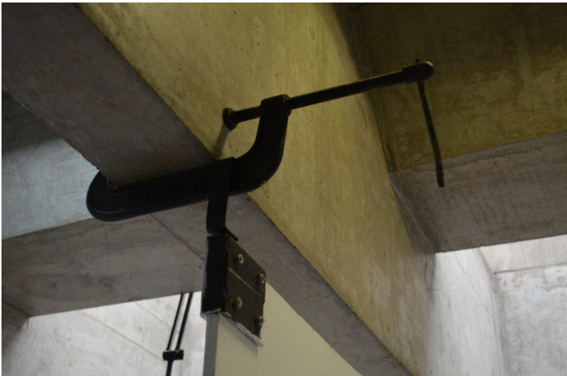
Figura 6 – Detalhe fixação de painel MDF
