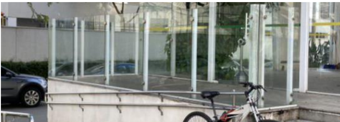
Figura 5 – Guarda-corpo existente (Fachada)
