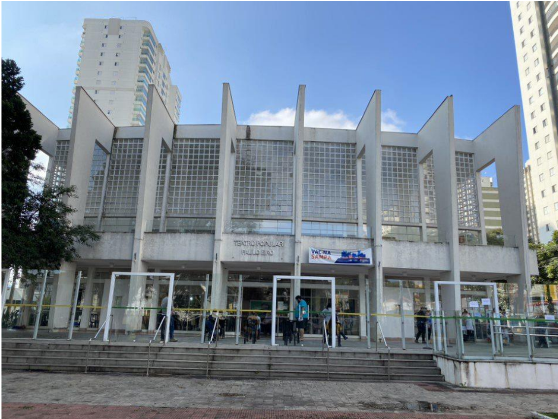
Figura 4 – Proteção de vidro existente (Fachada)
