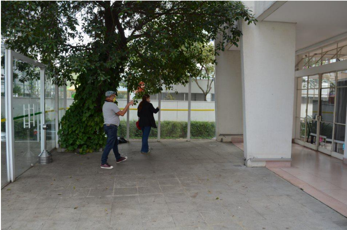
Figura 3 – Piso de pedra e proteção de vidro existente (Fachada)
