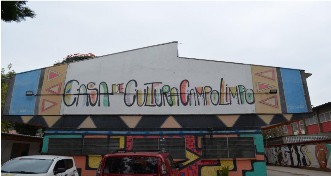
Figura 3 – Fachada da Casa de Cultura Municipal do Campo Limpo
