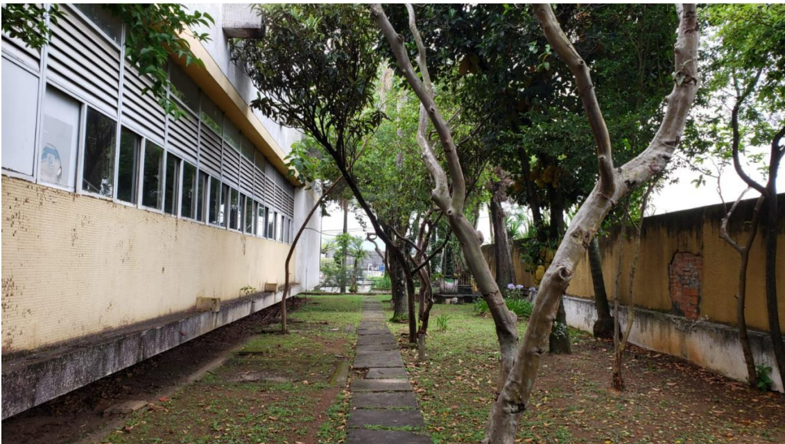
Figura 8 - Área externa da Bblioteca Brito Broca
