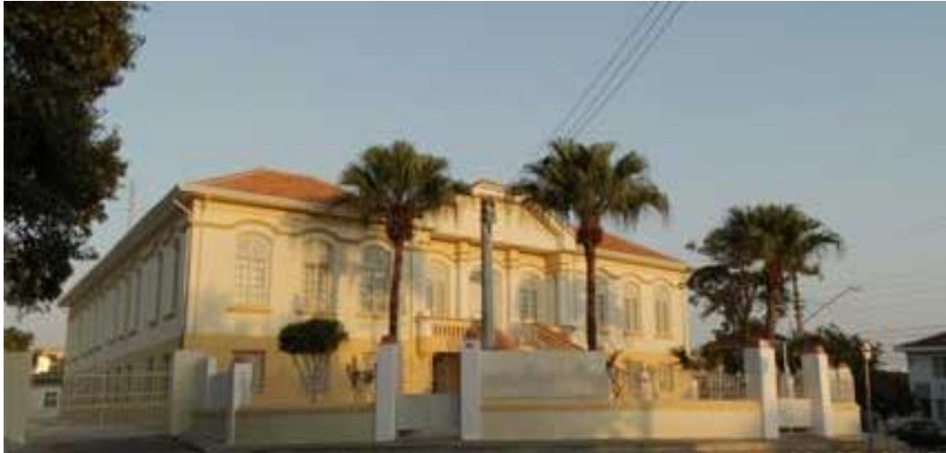
Figura 3 – Fachada da Casa de Cultura da Vila Guilherme
