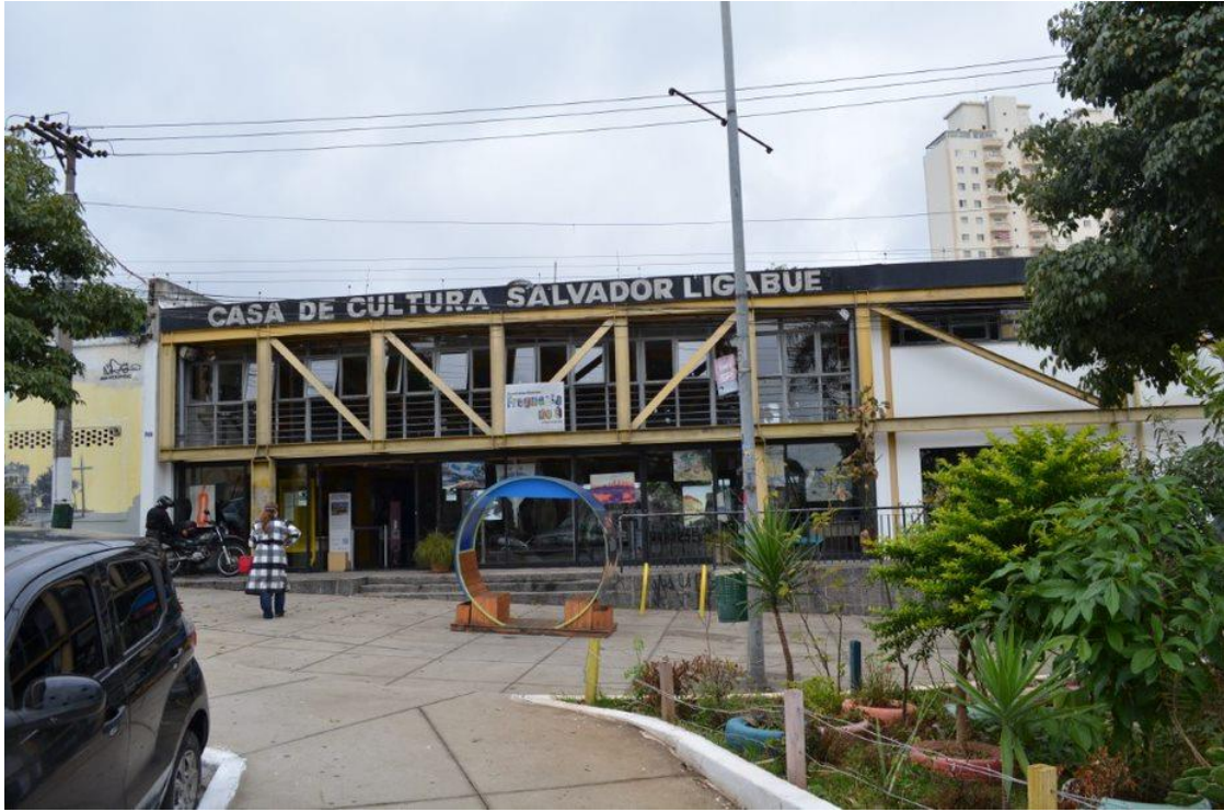
Figura 3 – Fachada da Casa de Cultura da Freguesia do Ó
