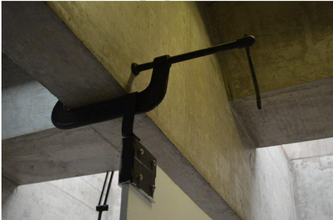
Figura 6 – Detalhe fixação de painel MDF
