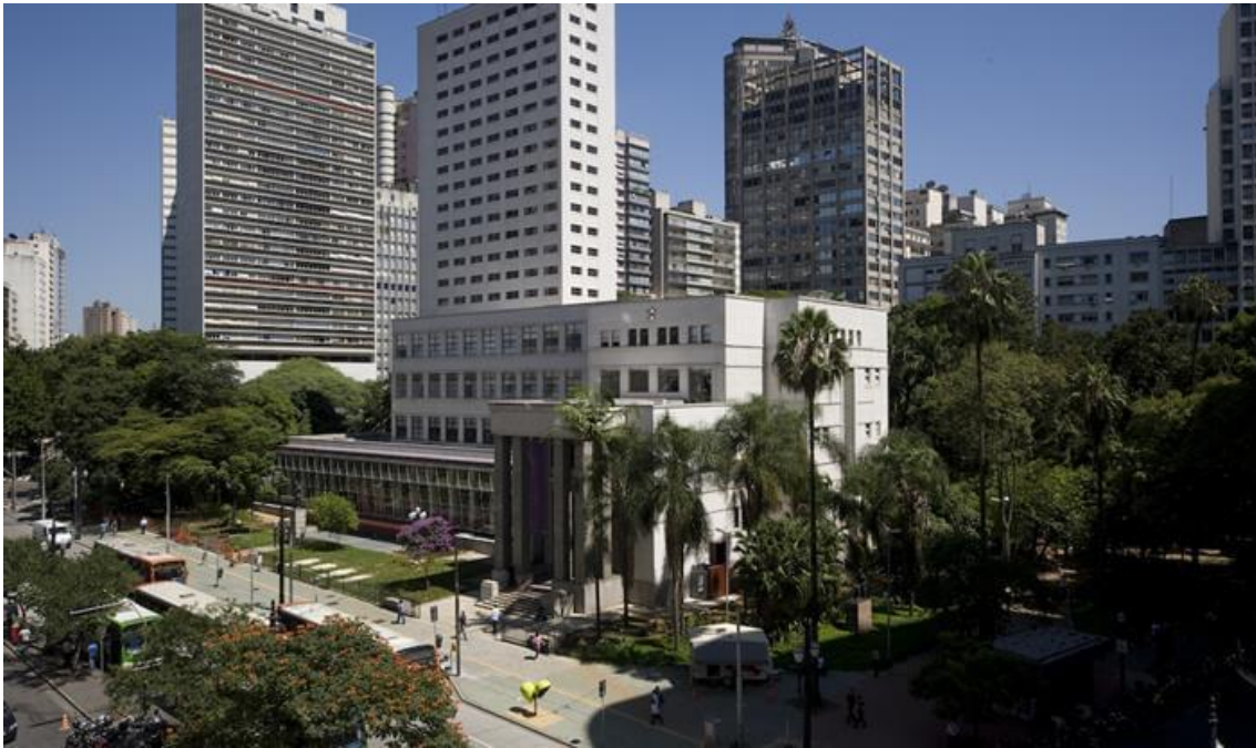
Figura 3 – Fachada da Biblioteca Mário de Andrade
