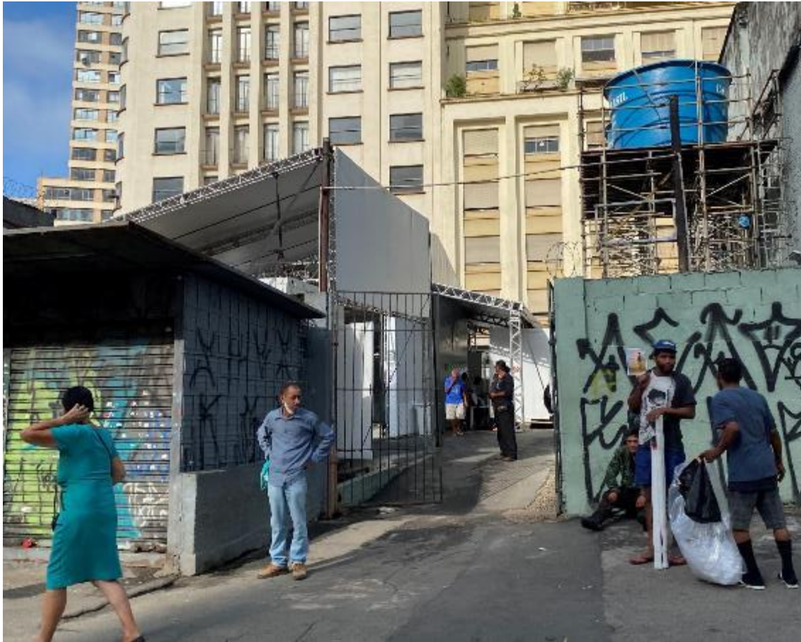
Figura 13 - Rua do Boticário nº 16/32, fachada voltada para Avenida Rio Branco
