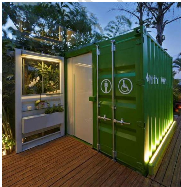
Figura 6. Banheiros Ecotransportáveis em Belo Horizonte
