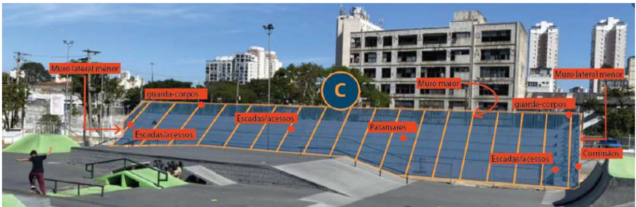
Figura 7. Área de intervenção da arquibancada Street Park
