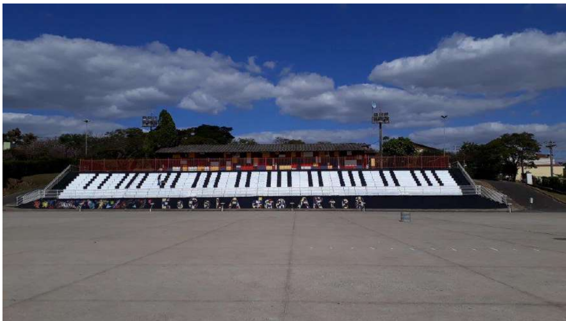
Figura 6. Intervenção em arquibancada – Santa Maria
