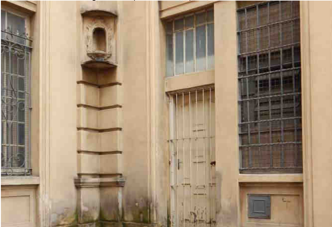
Figura 63 - Esquadrias e vidros que diferem entre si
