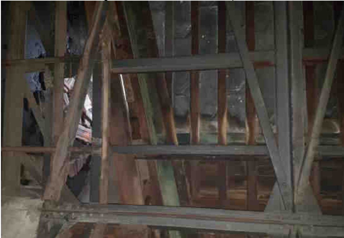
Figura 11 - Estrutura da cobertura das cúpulas
