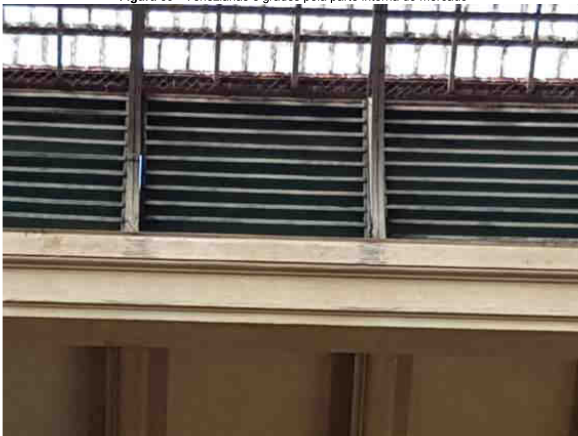
Figura 89 - Venezianas e grades pela parte interna do mercado
