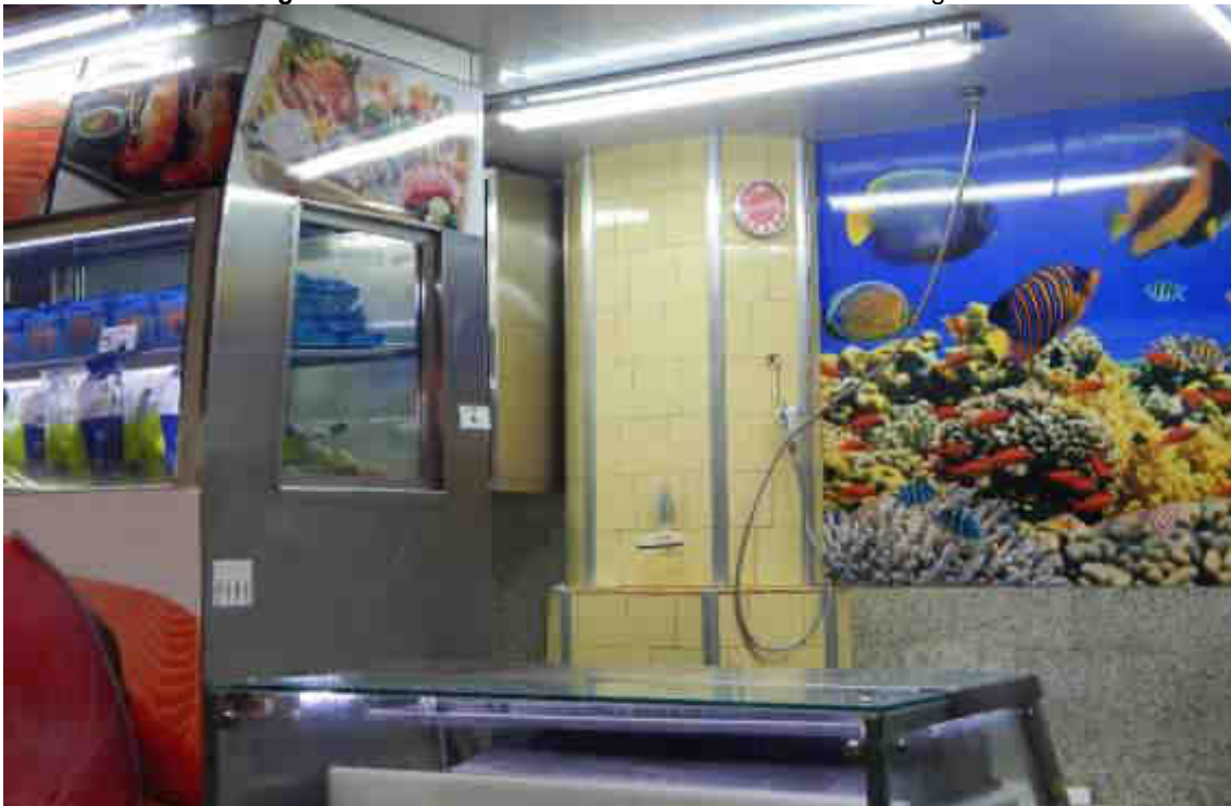
Figura 44 - Pilar com o revestimento cerâmico amarelo original
