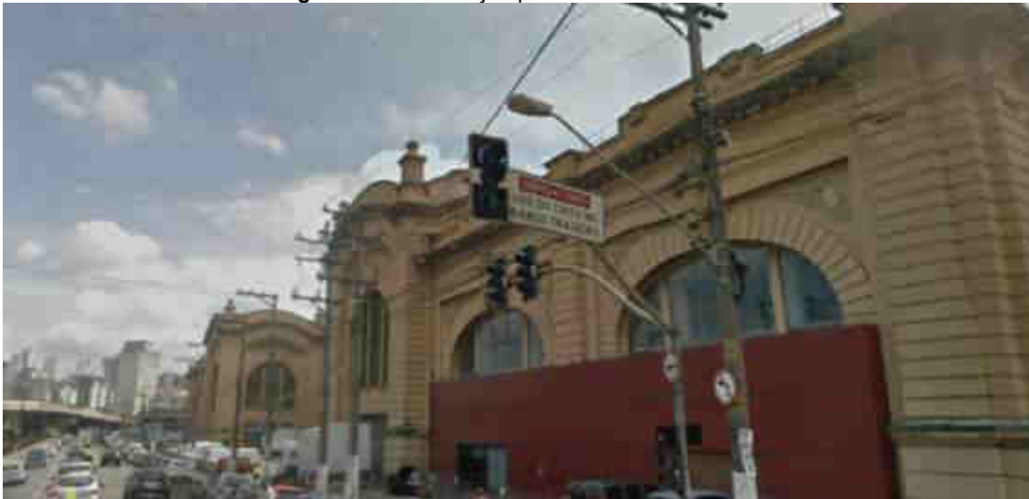
Figura 120 - Iluminação pública na Av. do Estado
