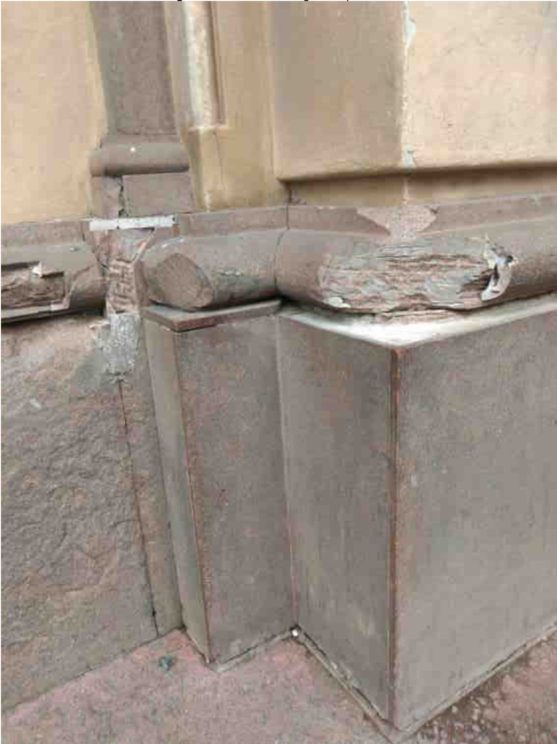
Figura 26 - Fachada com granito quebrado
