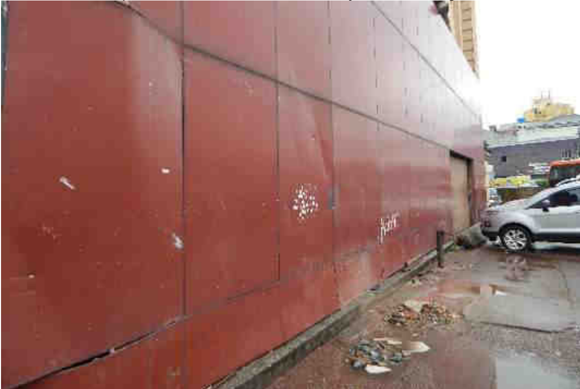
Figura 27 - Fachada com placas de material de alumínio composto (ACM) com danos na superfície do revestimento e descaracterização da fachada original
