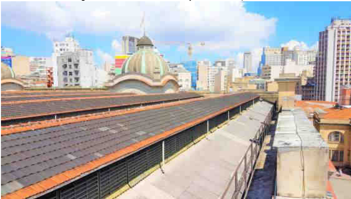
Figura 32 - Passarela de manutenção e rufos das platibandas
