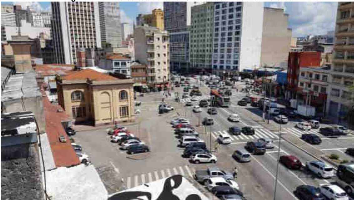
Figura 116 - Área de estacionamento dentro dos limites do mercado
