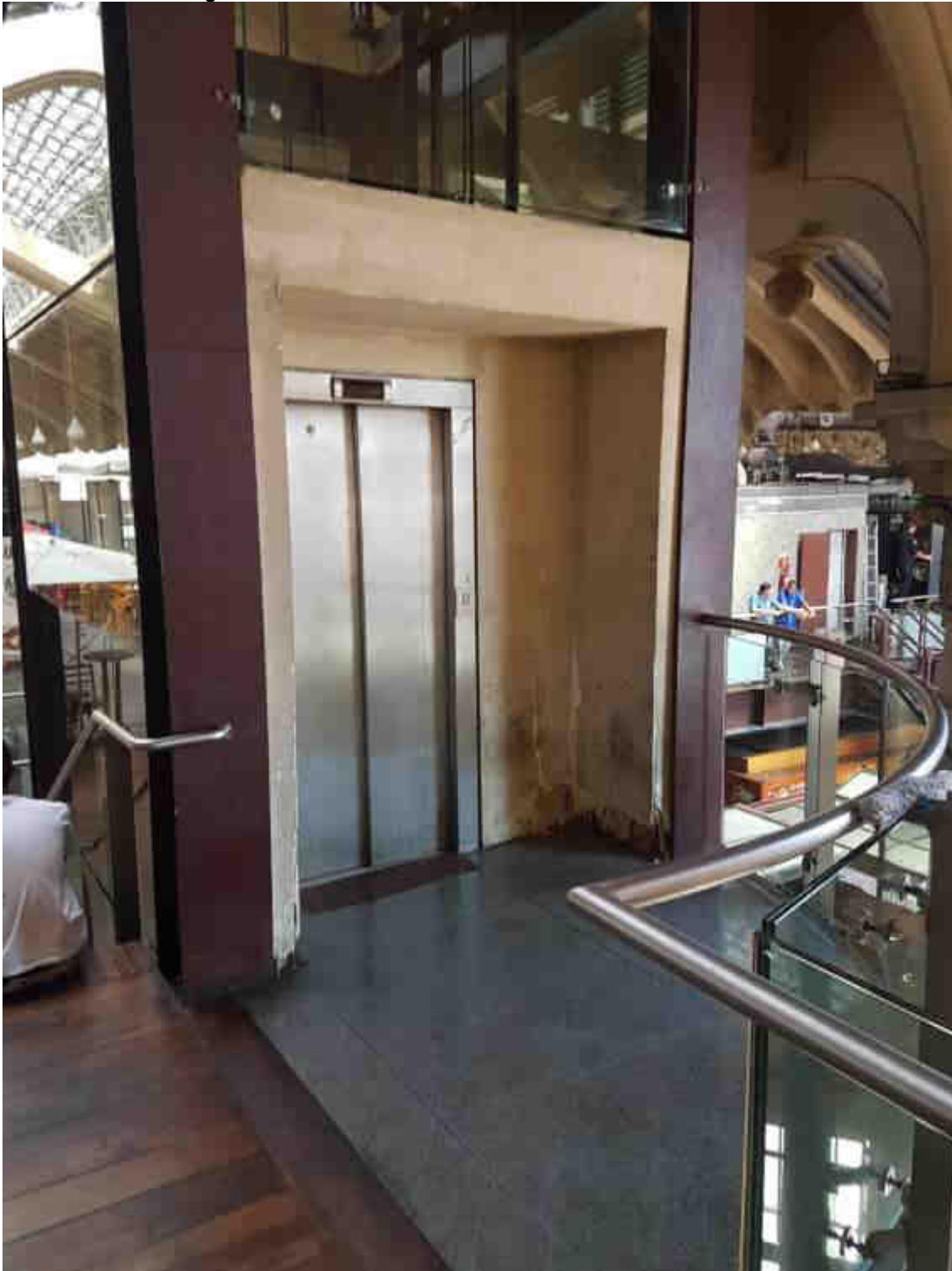
Figura 84 - Porta do elevador da torre B, de acesso ao mezanino
