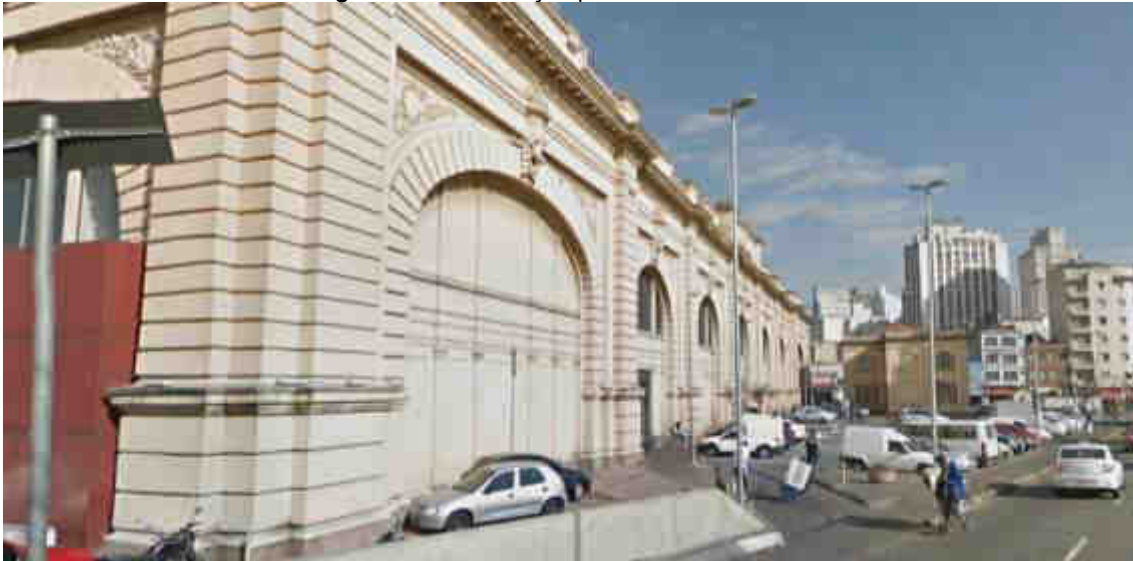
Figura 119 - Iluminação pública na Av. Mercúrio
