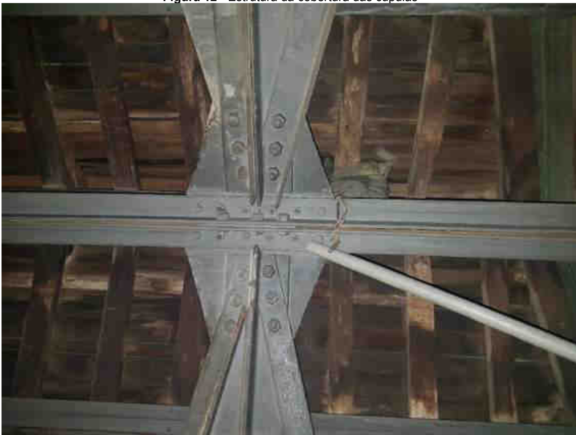
Figura 12 - Estrutura da cobertura das cúpulas
