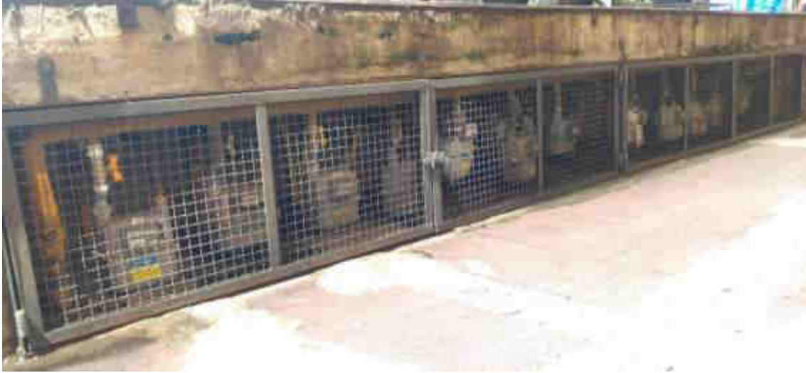
Figura 82 - Área de medição de gás canalizado
