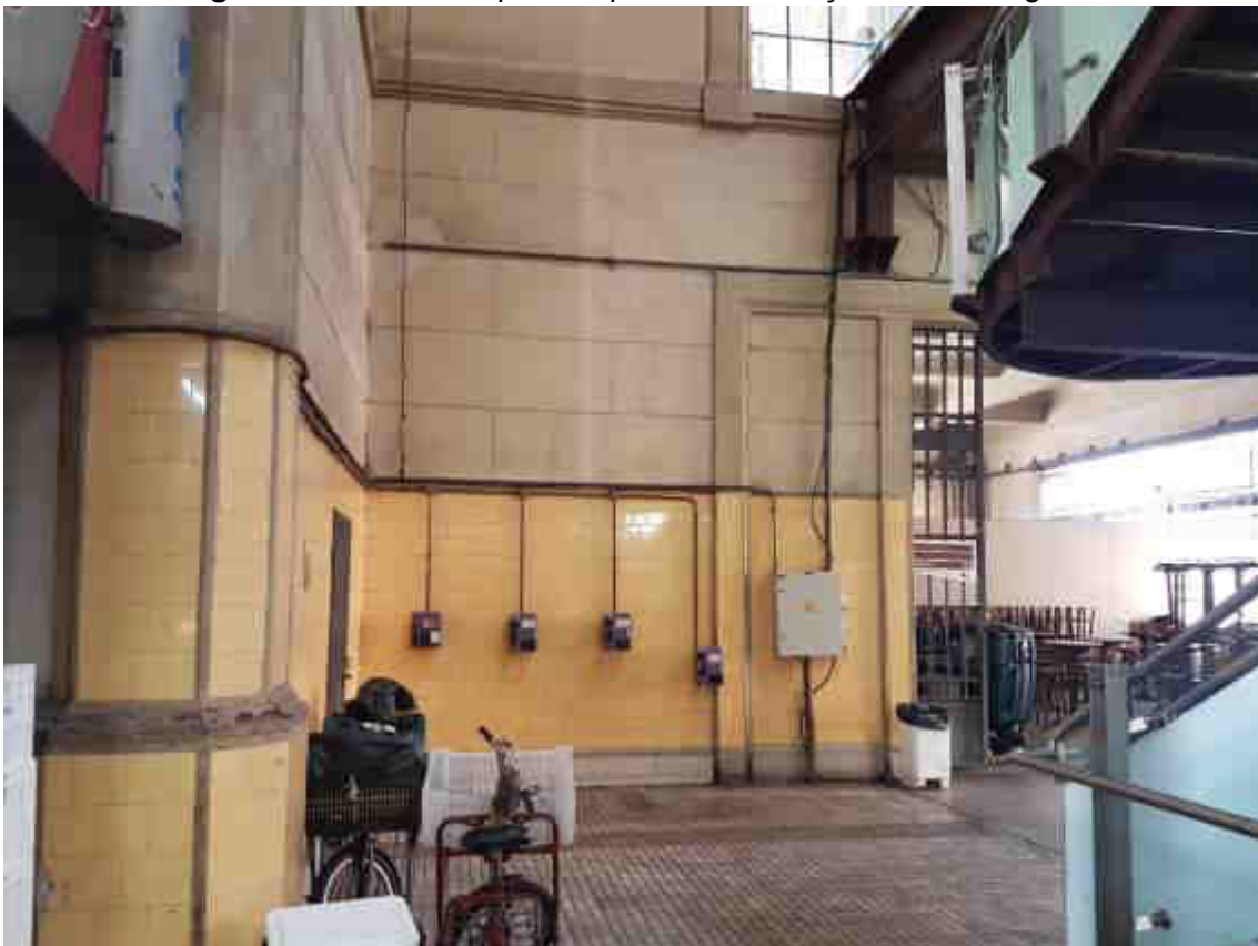
Figura 79 - Telefonia pública próximo à estação de reciclagem
