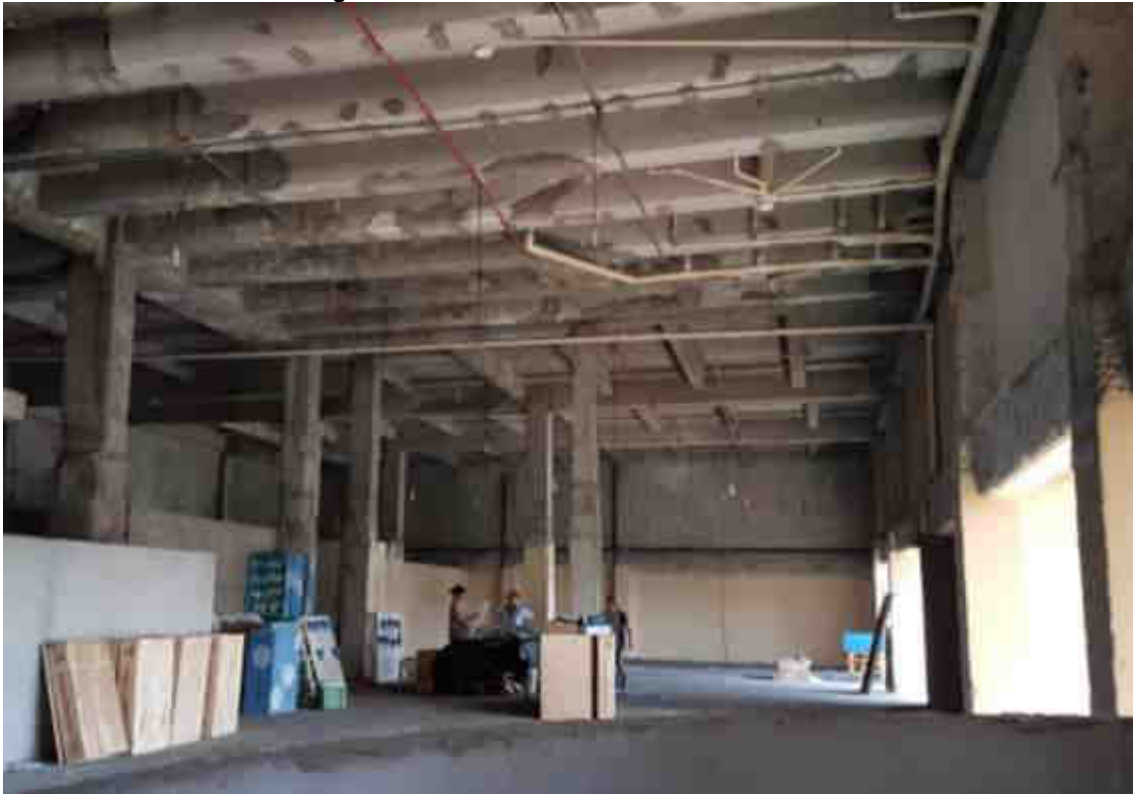
Figura 42 - Área subutilizada sem revestimentos
