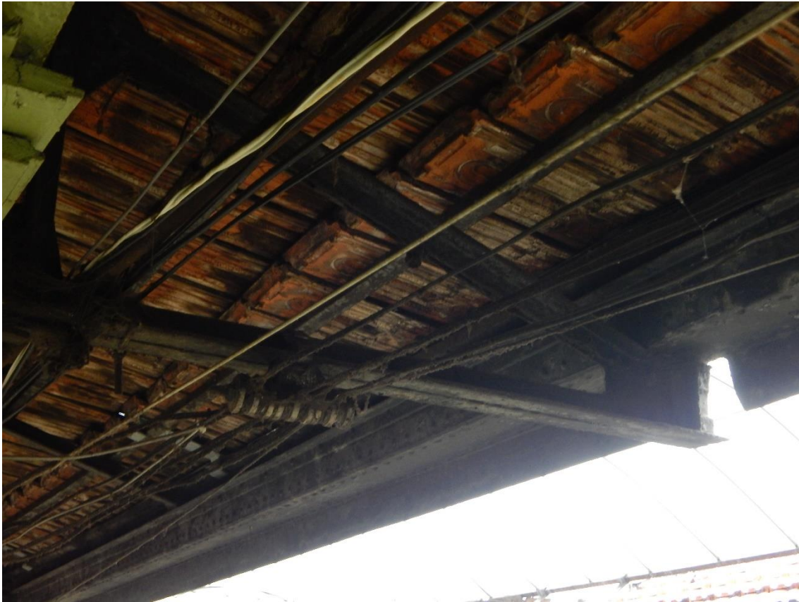
Figura 37 - Cabos expostos
