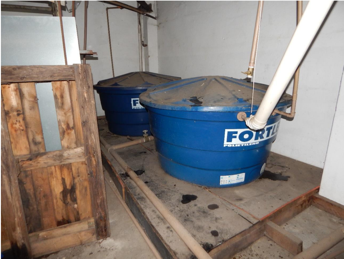
Figura 35 - Caixas d'água dos sanitários
