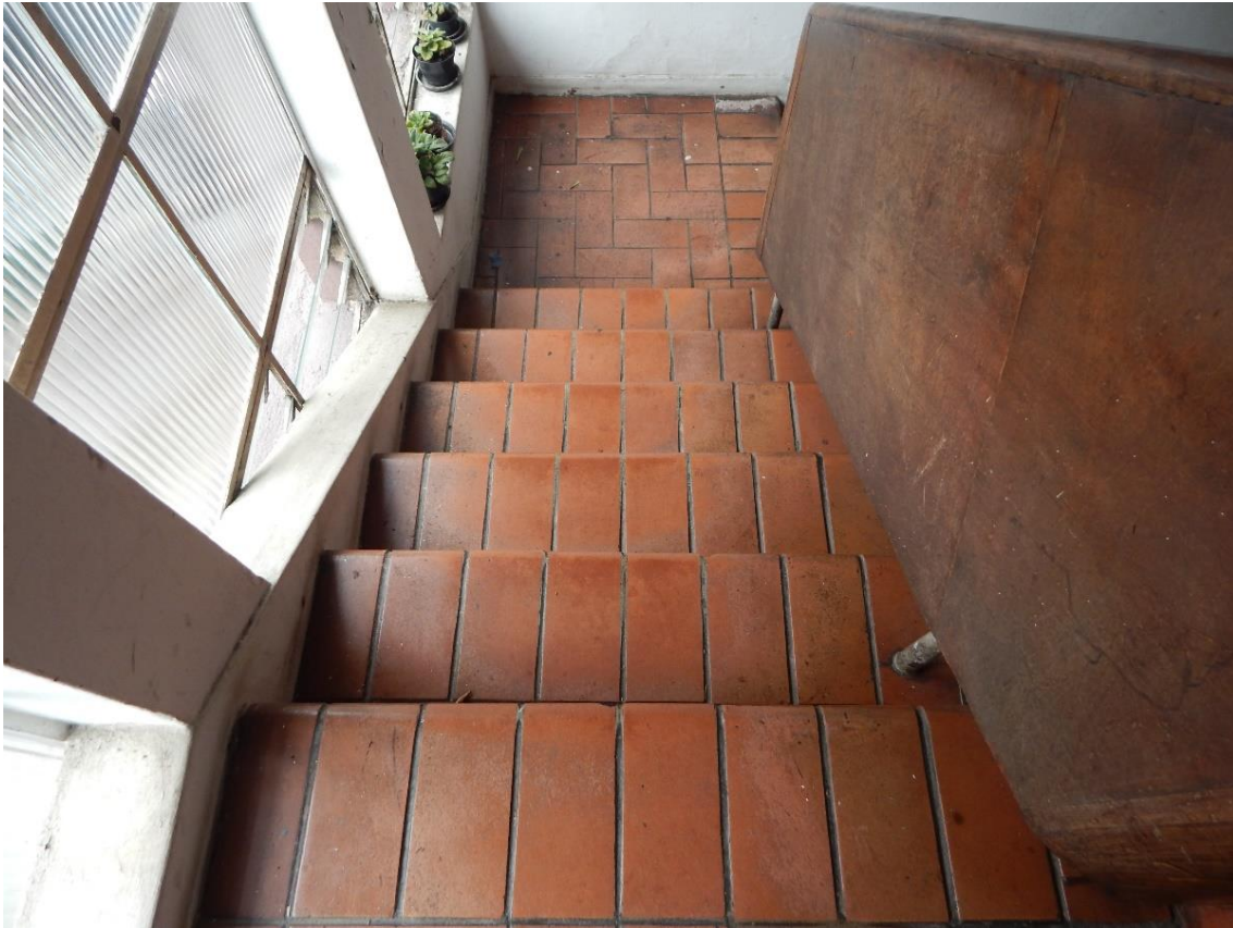
Figura 68 - Escada de acesso ao segundo pavimento do edifício anexo
