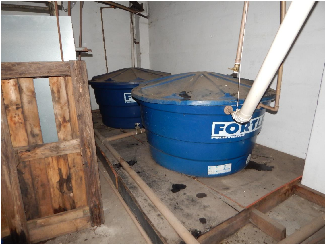
Figura 56 - Caixas d'água dos sanitários
