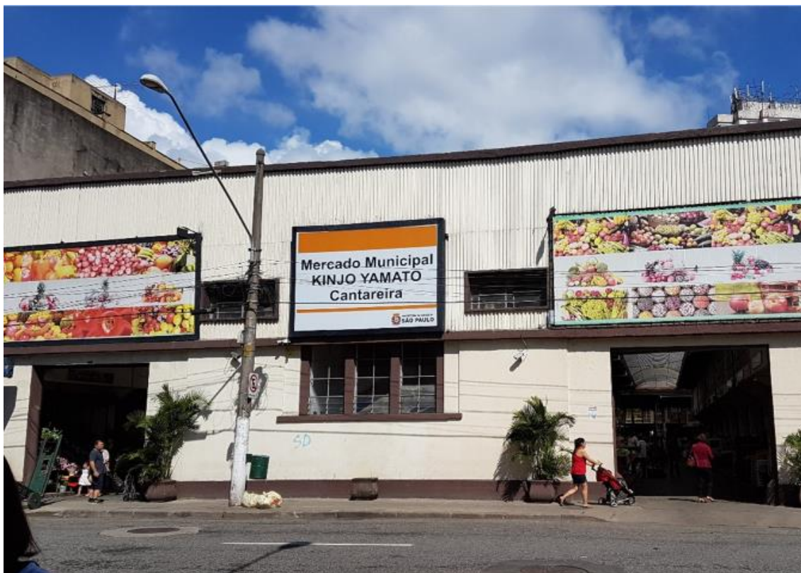
Figura 13 - Rever revestimento externo e tratamento da fachada
