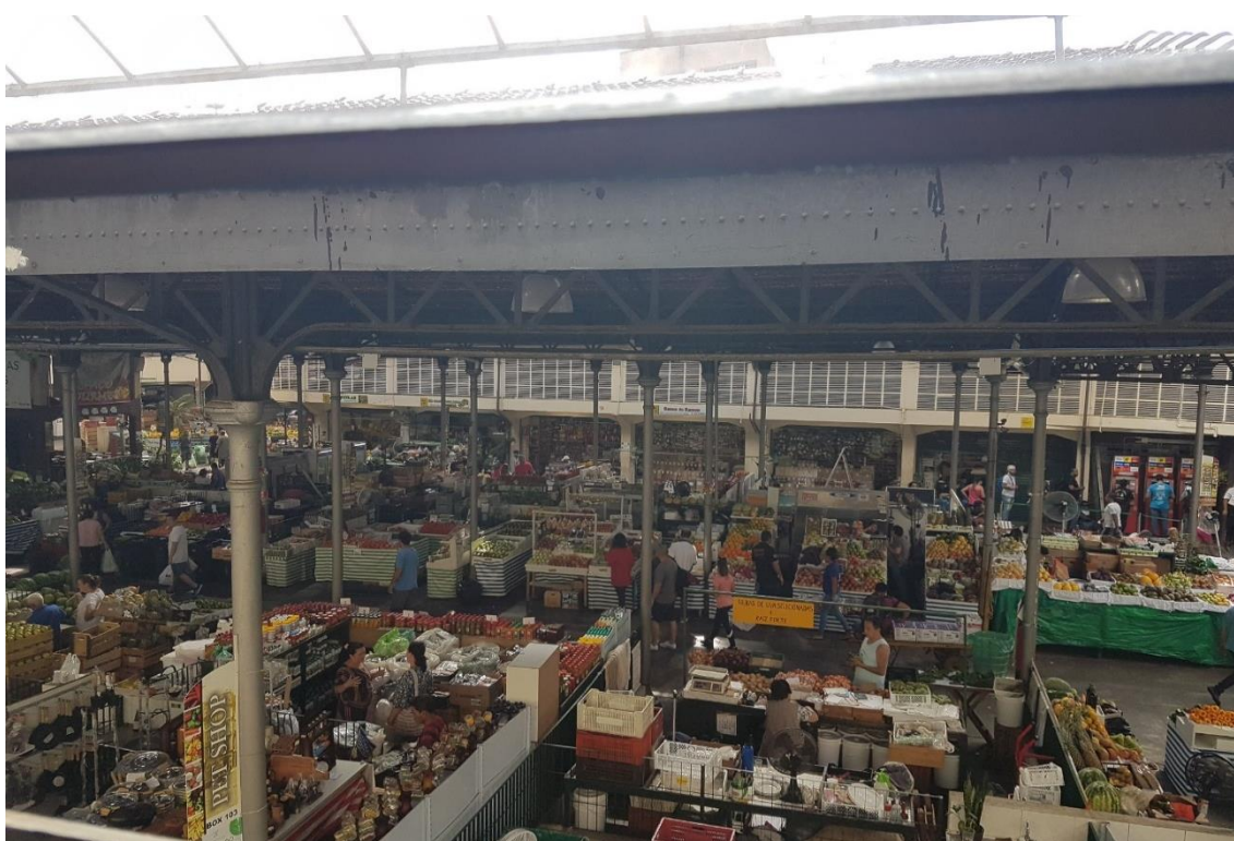
Figura 3 - Vista geral da estrutura da cobertura da área interna do mercado
