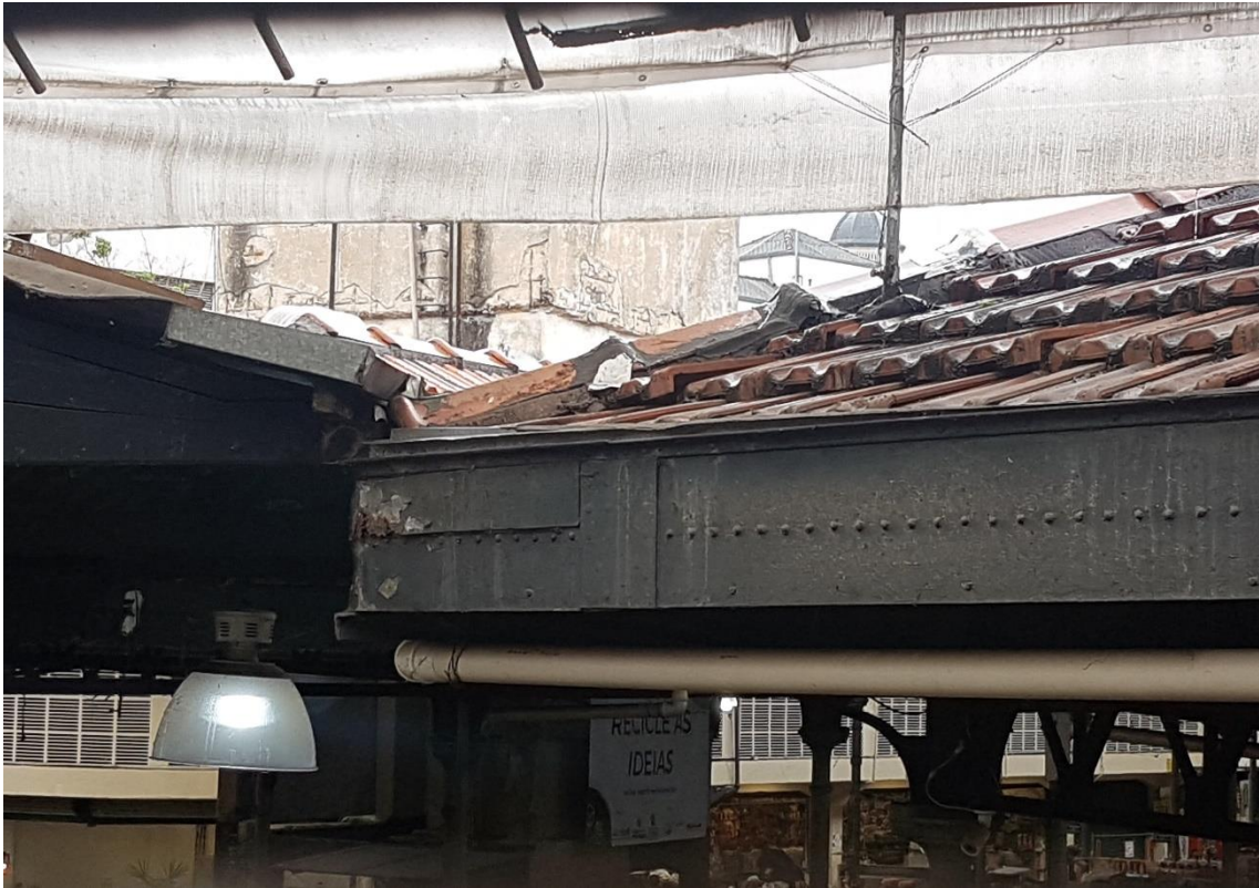
Figura 34 - Reservatório principal de concreto ao fundo
