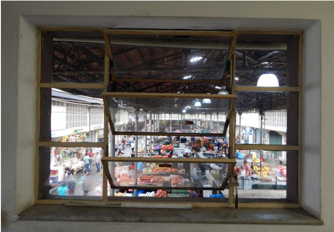
Figura 27 - Caixilho da edificação da antiga administração
