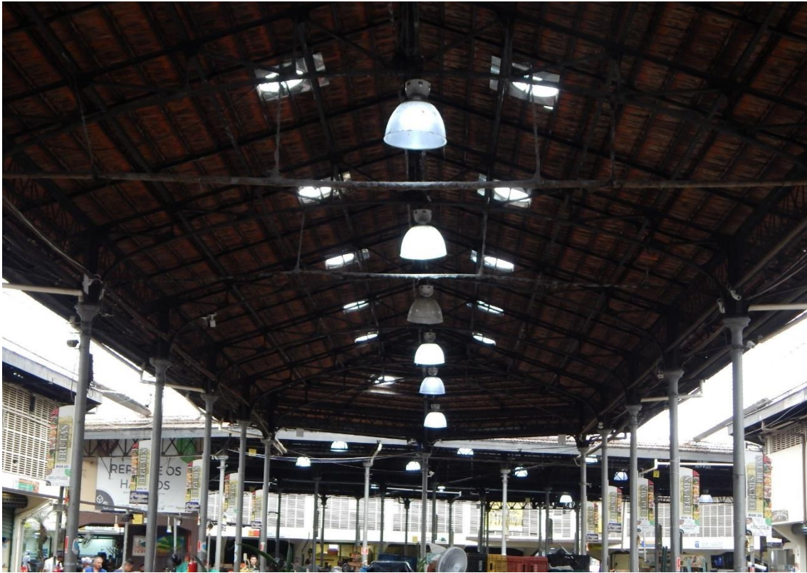
Figura 50 - Disposição e quantidade das luminárias do mercado
