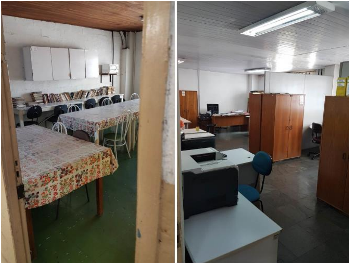
Figura 25 A e 25 B - Manutenção geral (instalações, piso, forro e parede)
