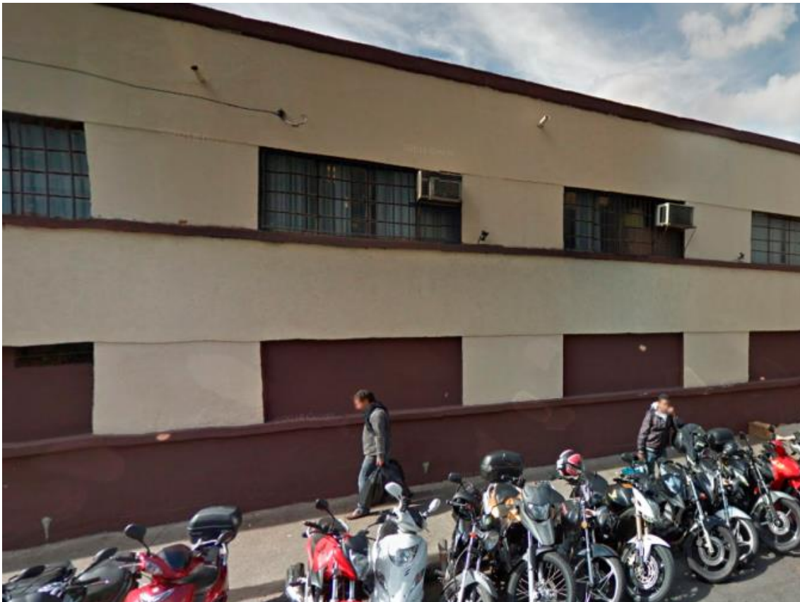
Figura 42 - Caixas de ar condicionado aparente na fachada
