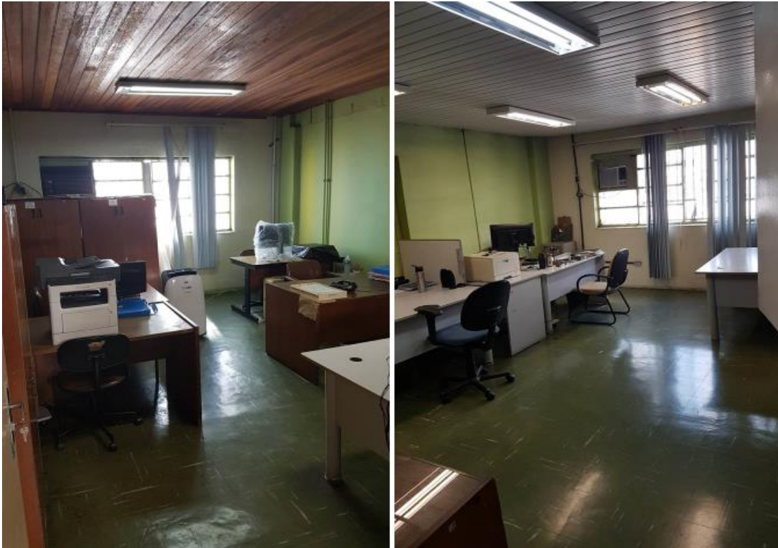
Figura 20 A e 20 B- Ocupação atual da área administrativa do mezanino (instalações, piso, forro e parede)
