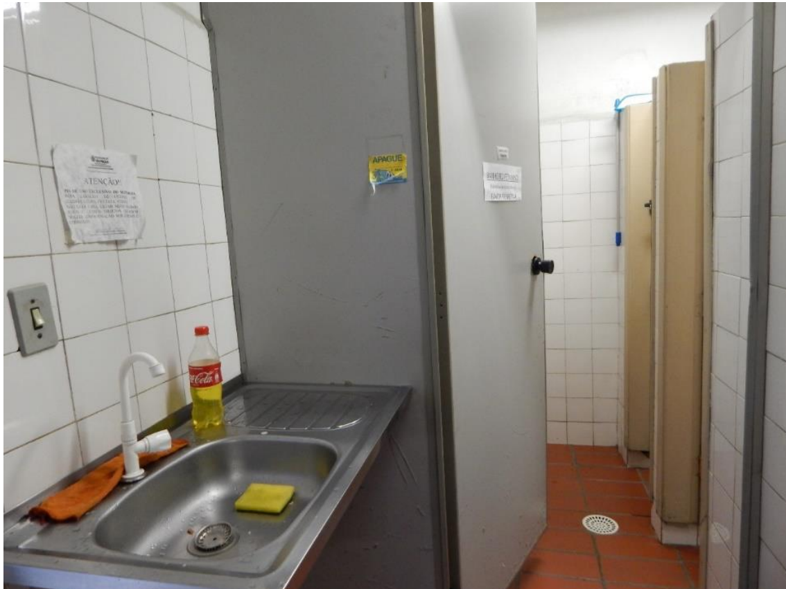
Figura 49 - Disposição da copa e sanitário do prédio administrativo
