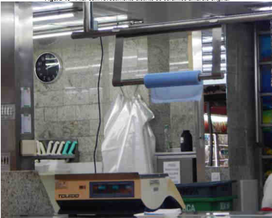
Figura 45 - Pilar com revestimento distinto do cerâmico amarelo original
