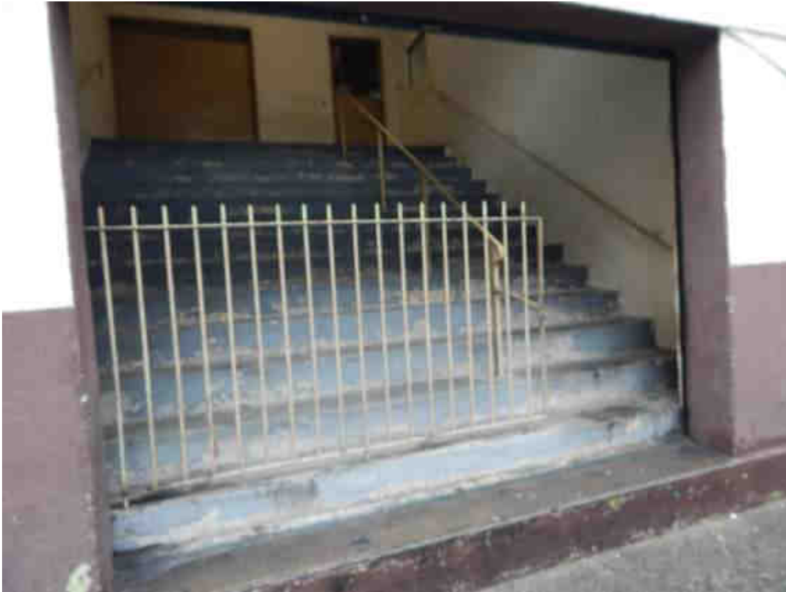
Figura 67 - Escada de acesso a área administrativa do mezanino
