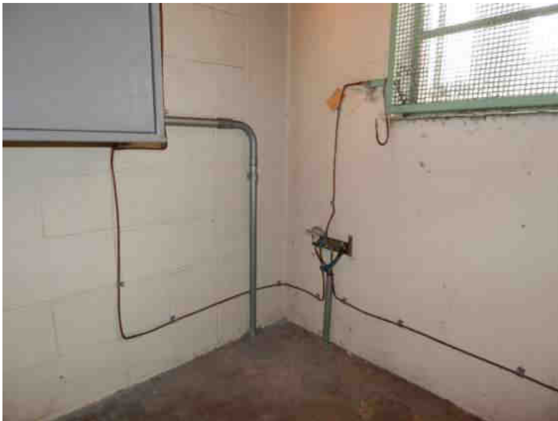
Figura 48 - Aterramento do quadro realizado na grade do caixilho
