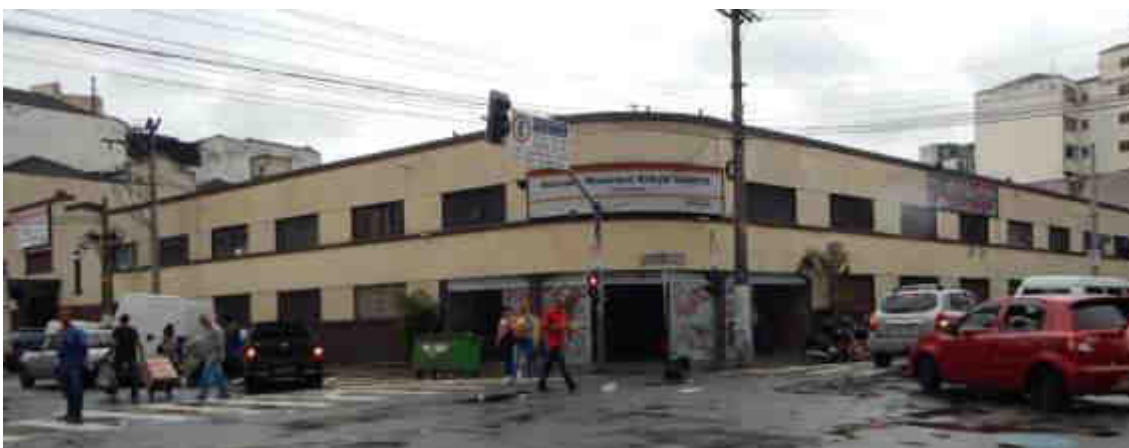
Figura 15 - Portões de acesso e esquadrias da entrada da esquina das ruas Barão de Duprat e Carlos de Souza Nazaré
