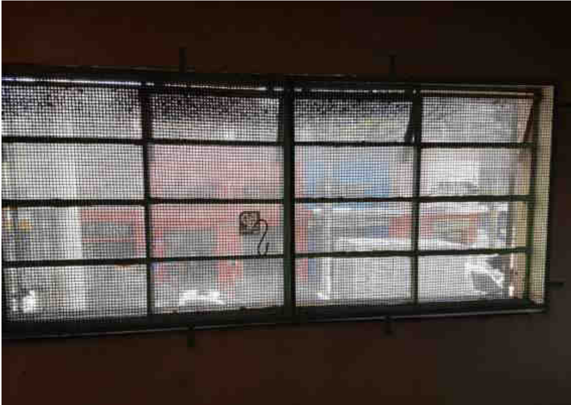
Figura 26 - Grade interna e caixilho do mezanino
