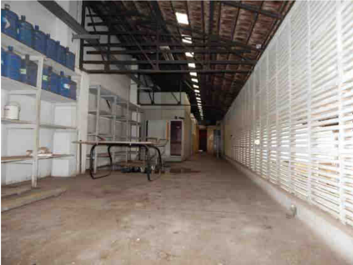
Figura 23 - Mezanino no contrapiso
