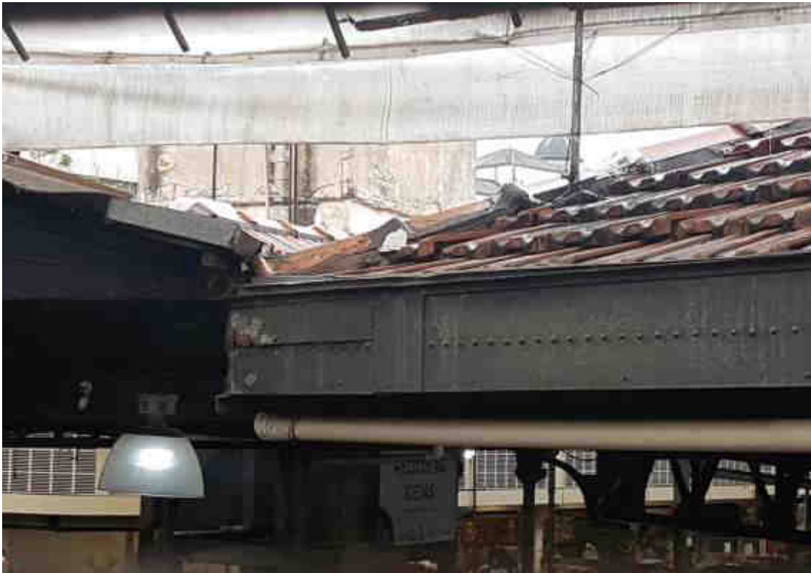
Figura 34 - Reservatório principal de concreto ao fundo
