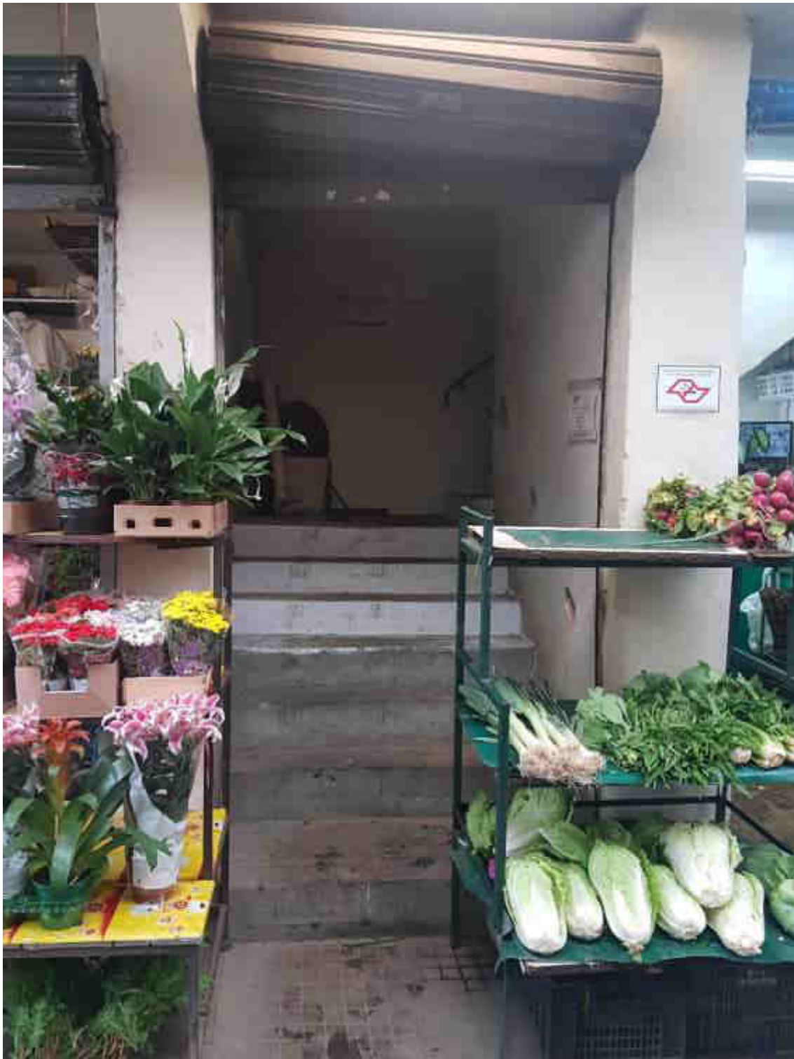
Figura 66 - Escada de acesso a área administrativa
