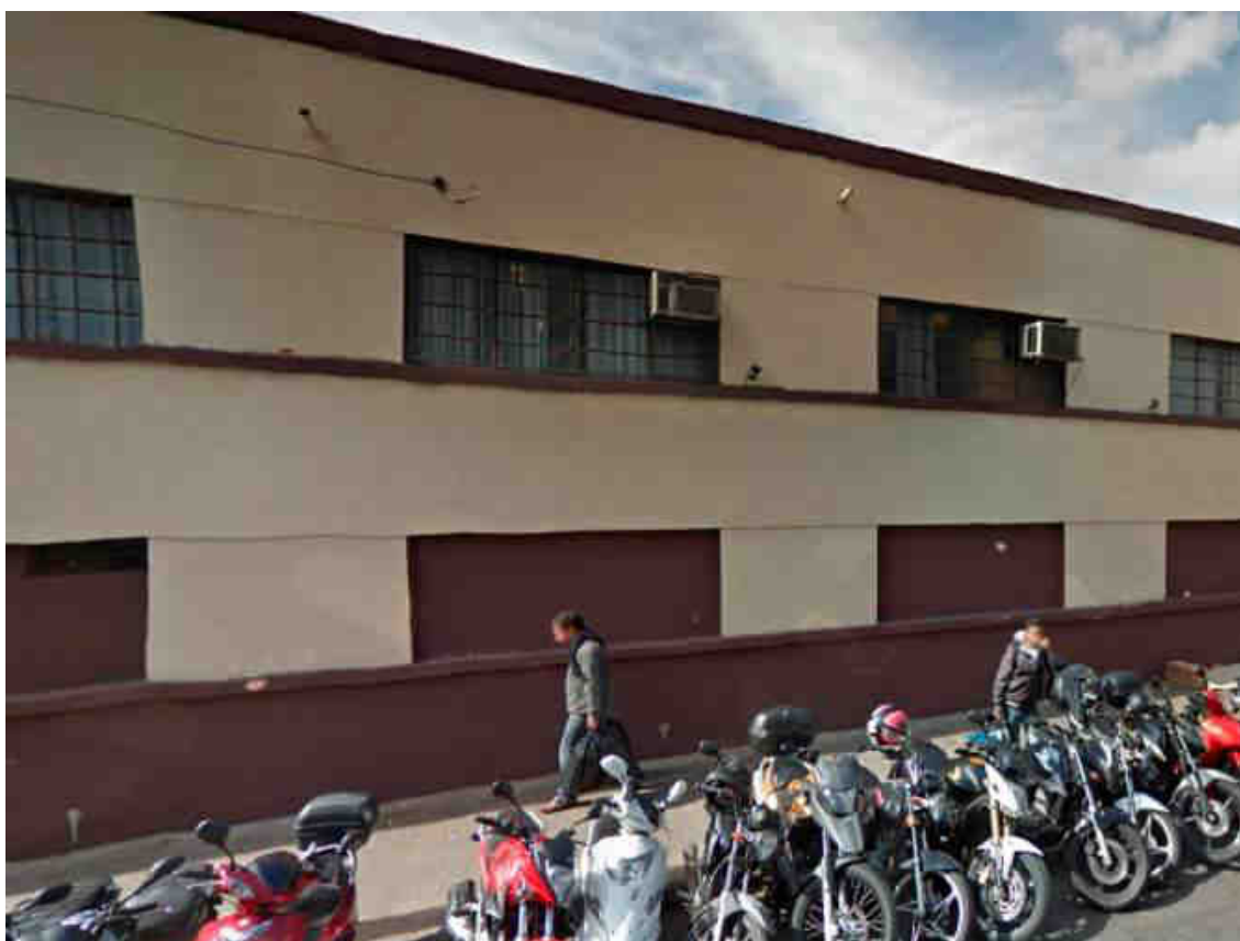
Figura 42 - Caixas de ar condicionado aparente na fachada
