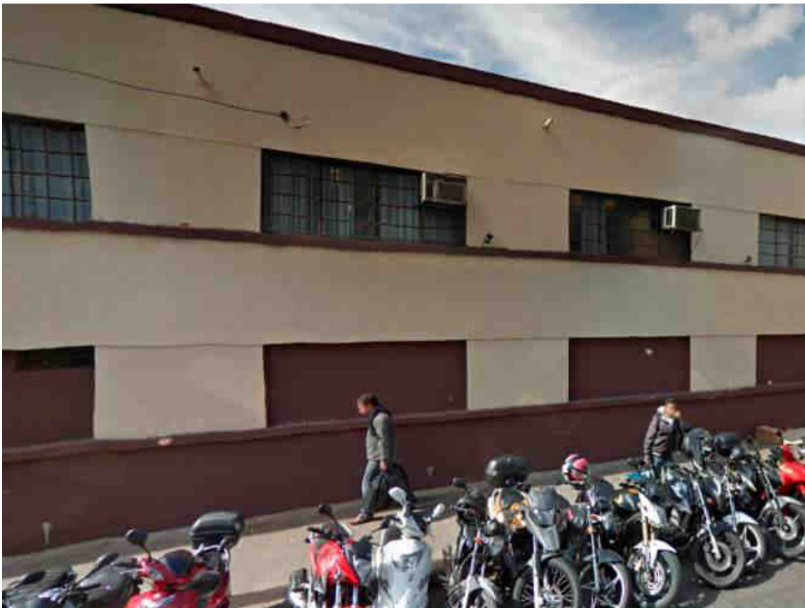
Figura 14 - Caixas de ar condicionado aparente na fachada
