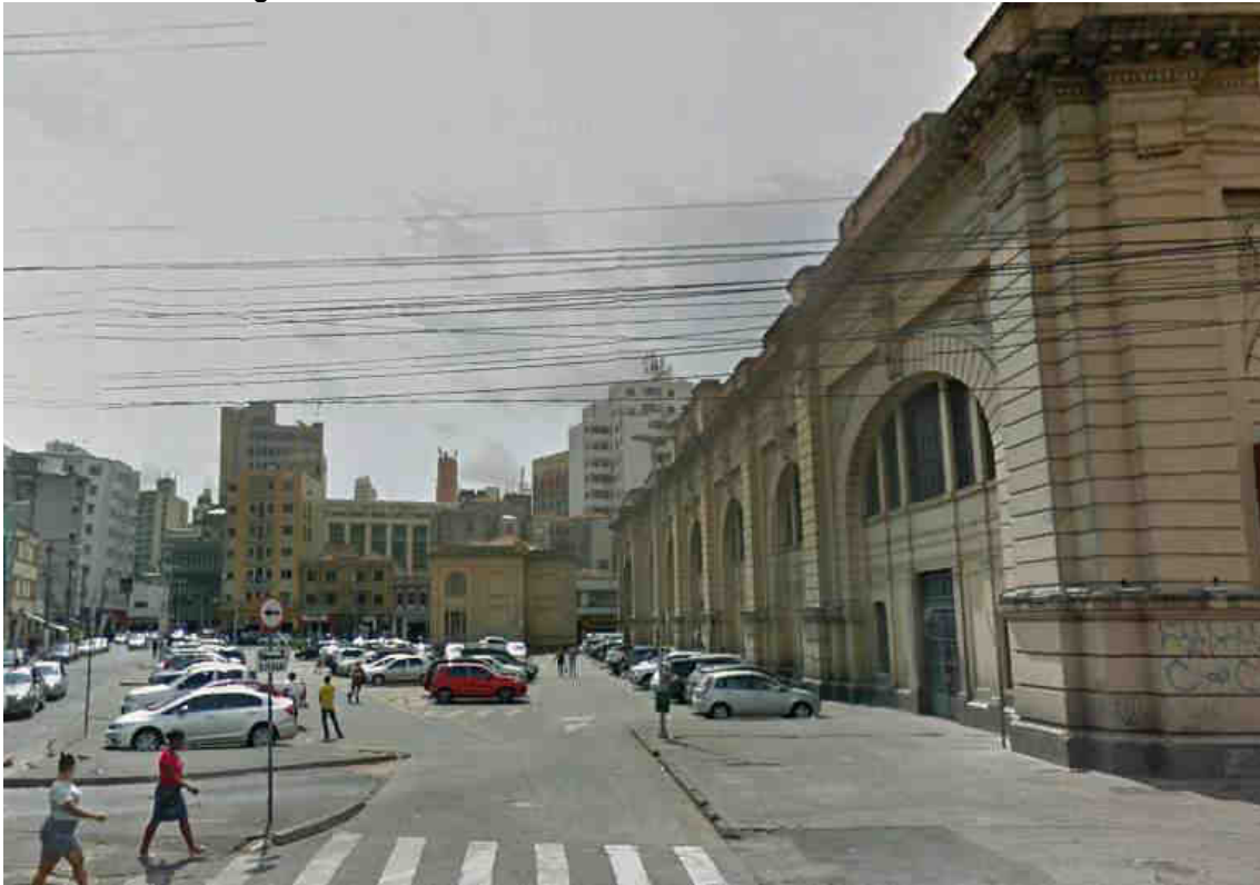
Figura 117 - Área de estacionamento dentro dos limites do mercado
