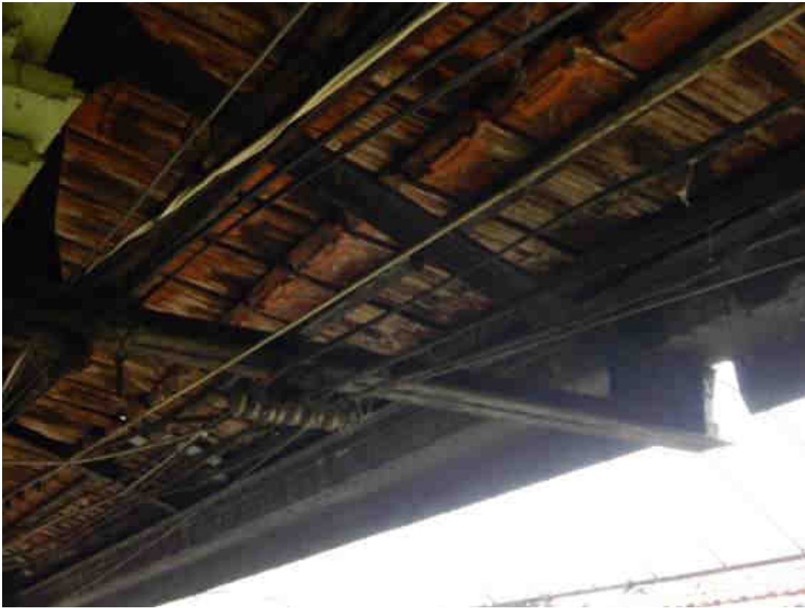
Figura 37 - Cabos expostos
