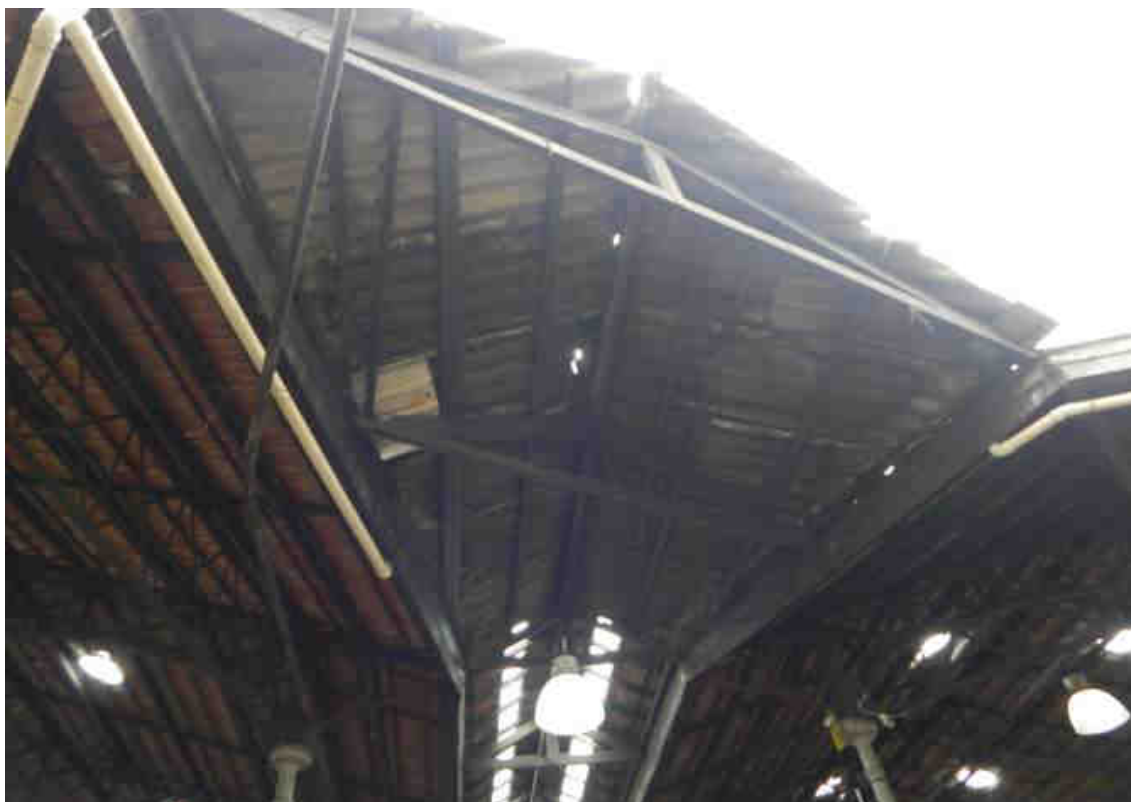
Figura 16 - Tesoura de madeira e telha de fibrocimento (desacordo com o projeto do telhado original)
