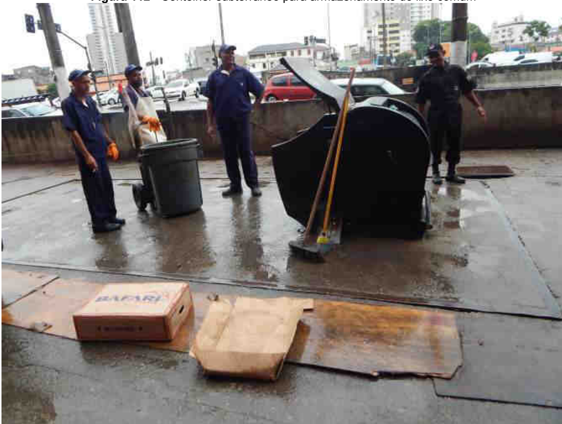
Figura 112 - Contêiner subterrâneo para armazenamento do lixo comum
