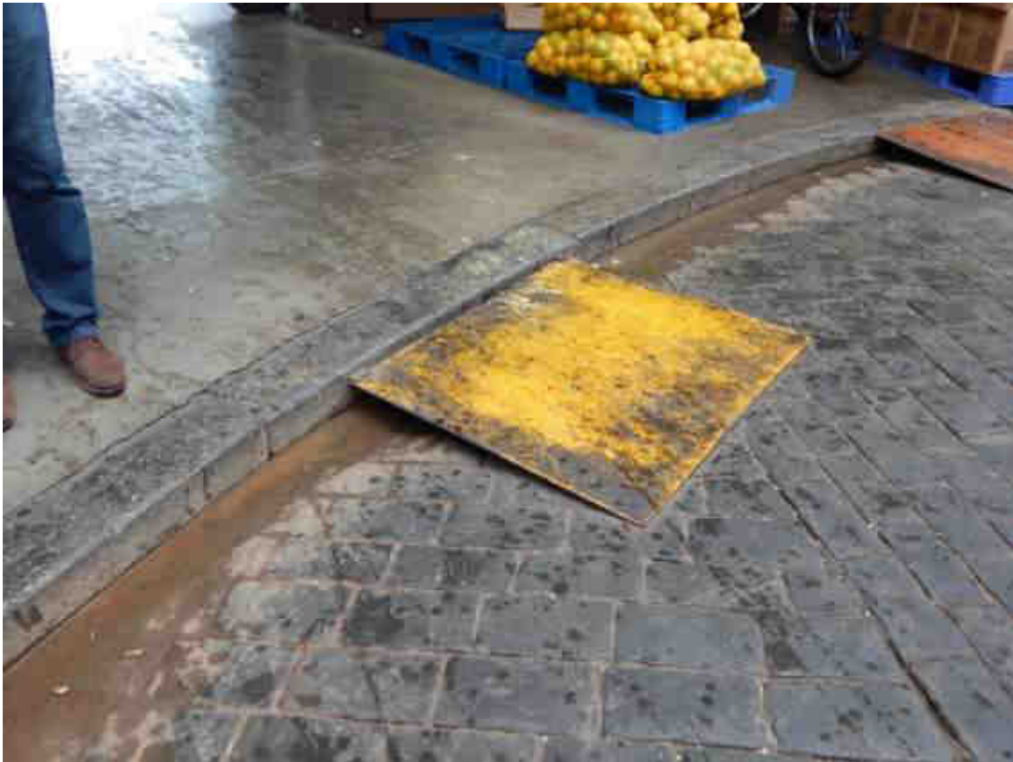
Figura 69 - Rampa de chapa metálica entre área de circulação e rua interna
