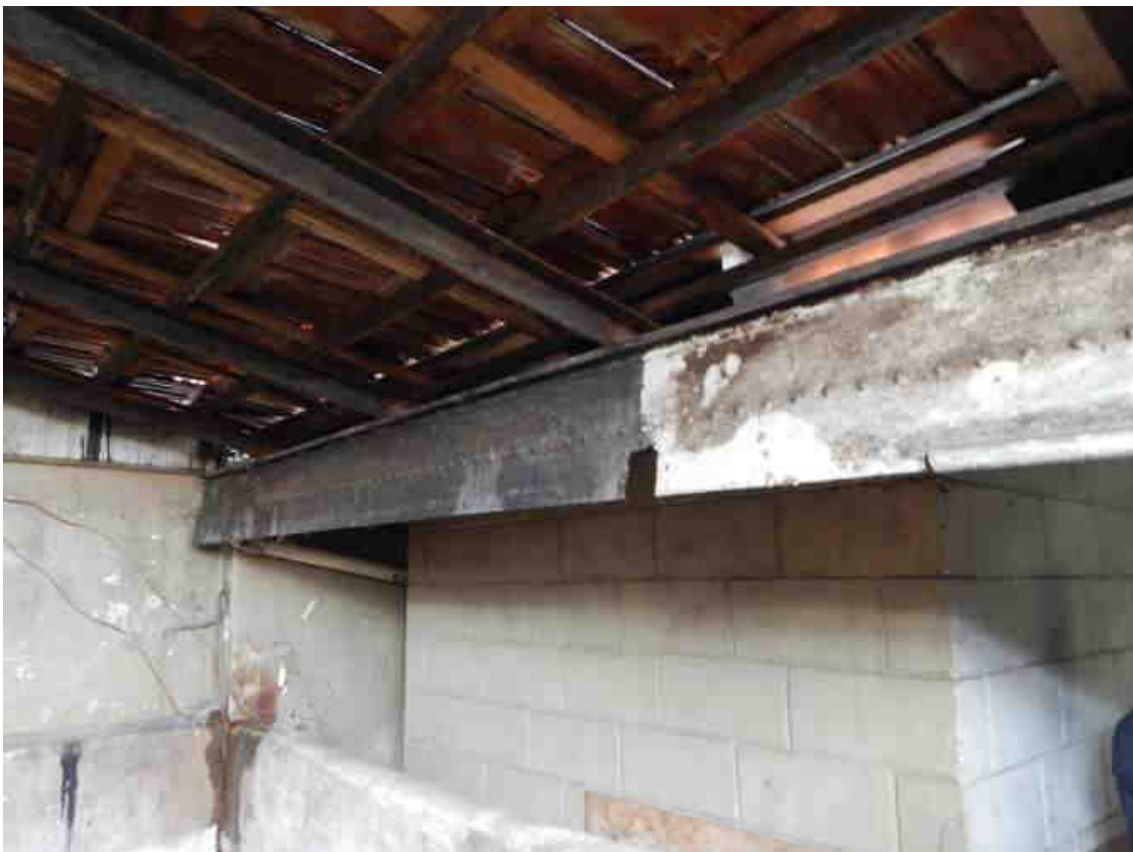
Figura 18 - Estrutura de madeira improvisada para apoio das telhas
