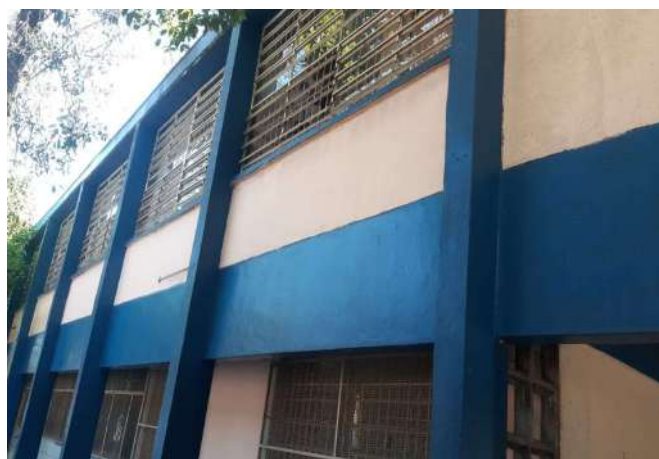
FOTO 10 REPARO OU SUBSTITUIÇÃO DAS JANELAS DO PISO SUPERIOR
