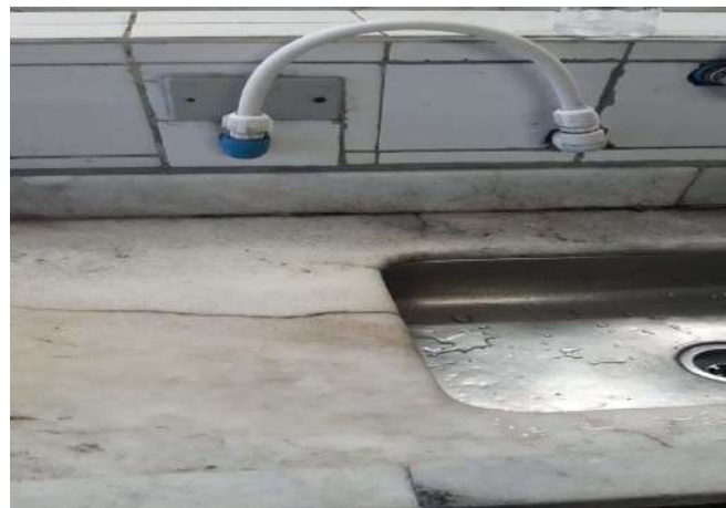
FOTO 32 SUBSTITUIÇÃO DA PEDRA DA BANCADA DA PIA
