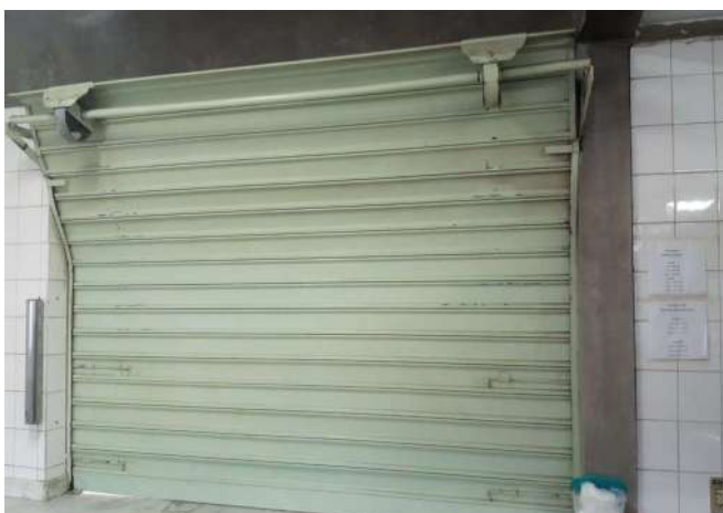
FOTO 33 SUBSTITUIÇÃO DE PORTA VASCULHANTE POR VIDRO
