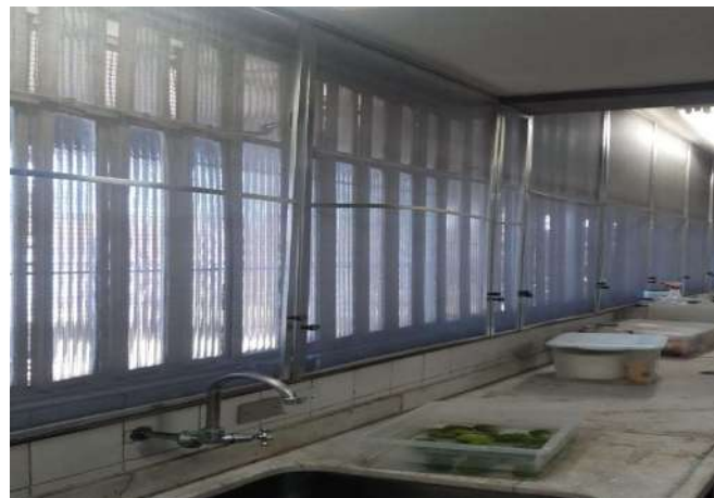
FOTO 14 SUBSTITUIÇÃO DAS JANELAS DA COZINHA, BAIXA VENTILAÇÃO
