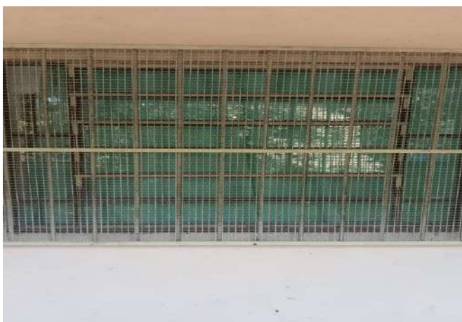
FOTO 9 SUBSTITUIÇÃO DE JANELA DA SECRETARIA
