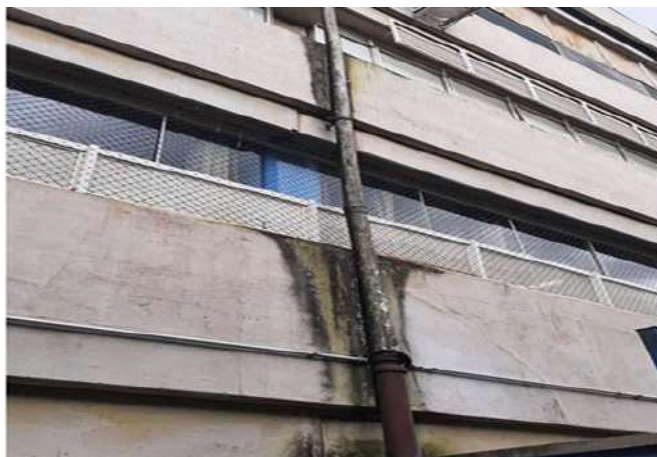
FOTO 1 FACHADA DO PRÉDIO
