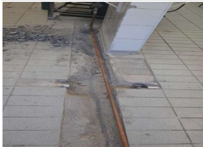
FOTO 5 MODELO DO PISO, REFORMA SUBSTITUIÇÃO DA TUBULAÇÃO DO GÁS
