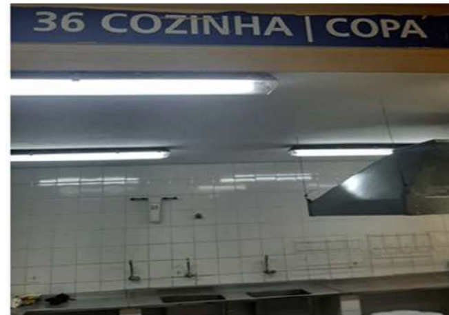
FOTO 4 REVESTIMENTO PAREDE COZINHA
