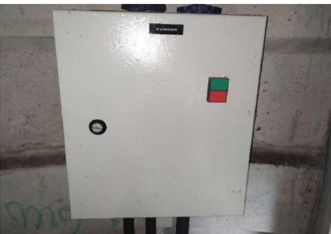
FOTO 11 Quadro elétrico da bomba de incêndio.
