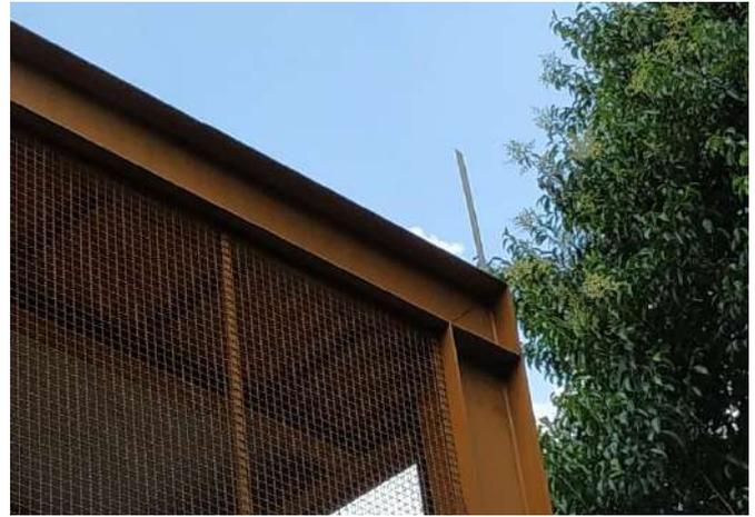
FOTO 2 Captor tipo Franklin, do sistema de SPDA. Falta luz de sinalização.
