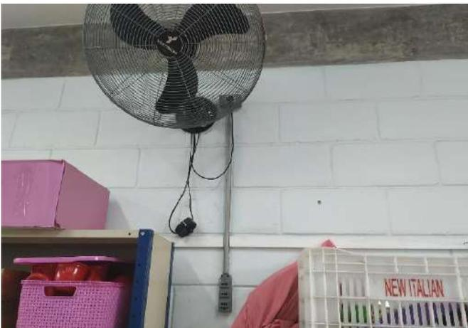
FOTO 93 Ventilador de parede, comando solto da parede, sala de aula 5.
