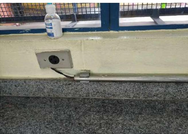
FOTO 65 Tomada padrão americano antigo, substituir por padrão brasileiro. Sem acabamento na instalação. Sala de aula 2.
