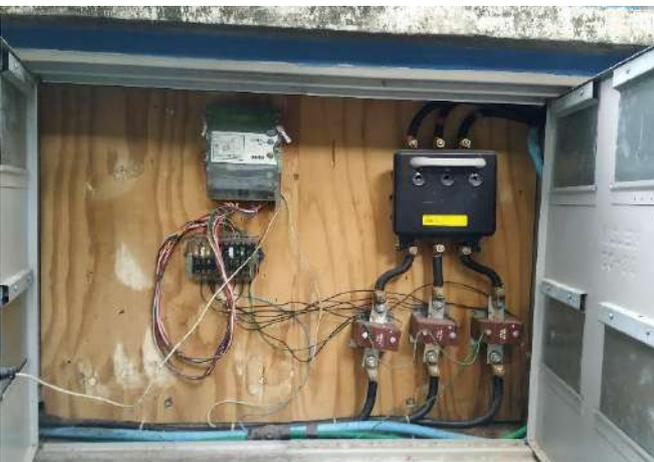
FOTO 5 Medidor de energia elétrica e dispositivos de proteção.
