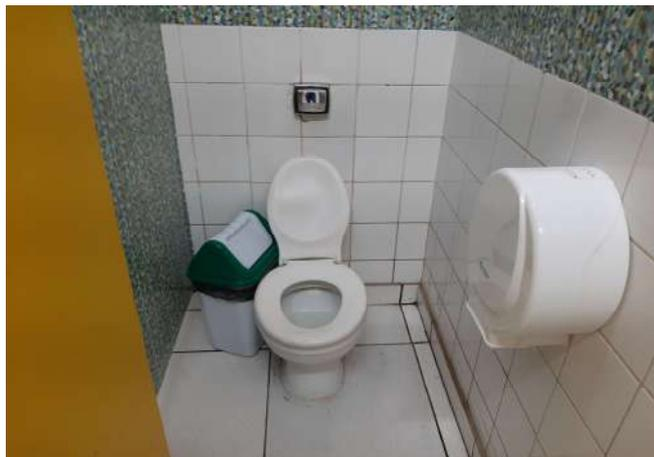
FOTO 63 Bacia com válvula de descarga
