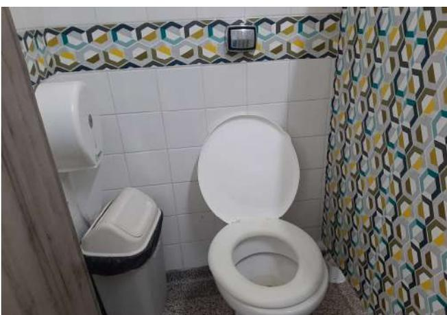
FOTO 53 Bacia com válvula de descarga
