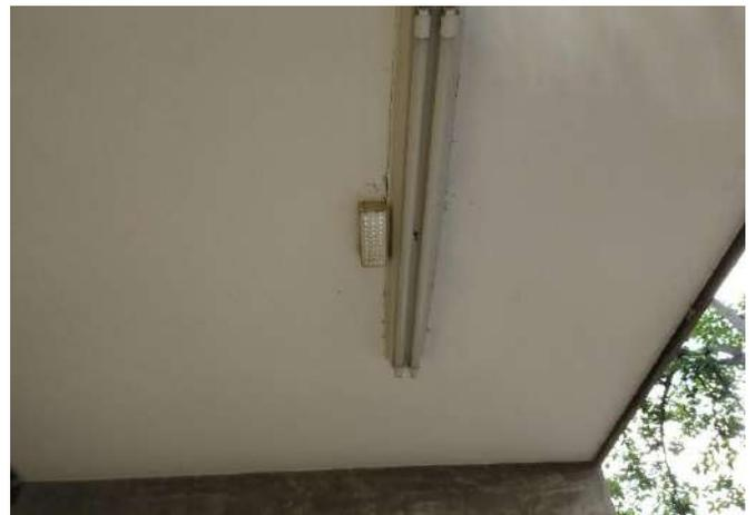
FOTO 34 Iluminação de emergência.
