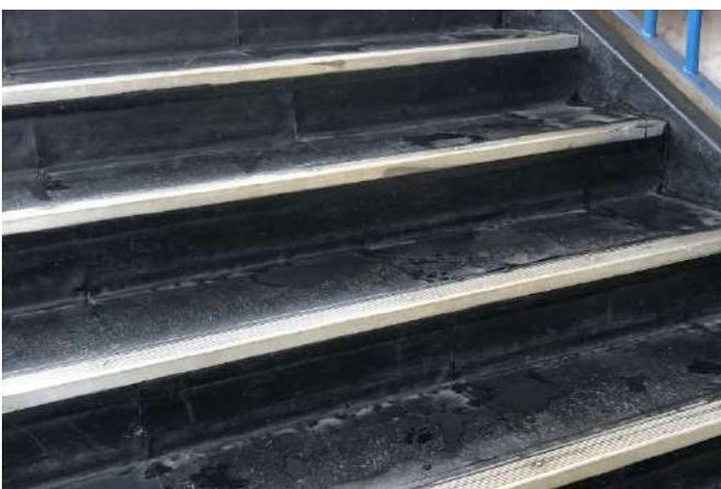
FOTO 41 ESCADA COM ELEMENTO ANTIDERRAPANTE.
