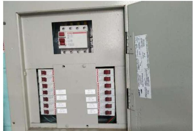
FOTO 22 Interior do quadro. Refazer a identificação dos circuitos. Realizar revisão nos cabos de distribuição e conectores.
