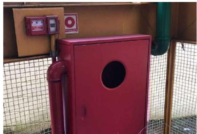
FOTO 36 HIDRANTE SEM COMPONENTES DE MANGUEIRA E VIDRO DE IDENTIFICAÇÃO.
