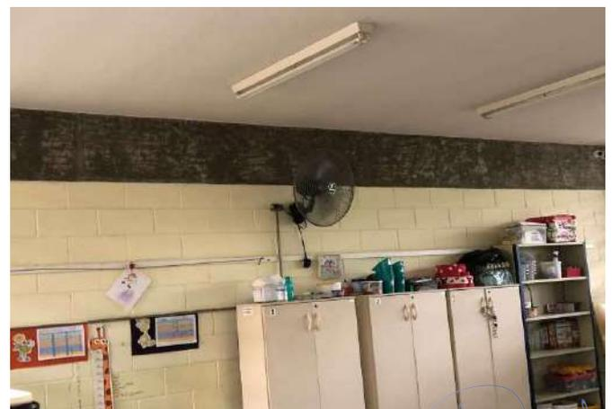
FOTO 54 SALA DE AULA 02, IMPROVISO NA REDE ELÉTRICA DE VENTILAÇÃO.
