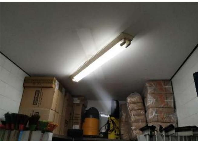
FOTO 29 Luminárias sobrepor com lâmpadas tubular de LED, sala da limpeza.
