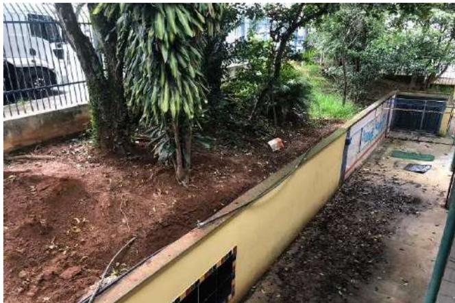
FOTO 171 PÁTIO EXTERNO EM DESAPRUMO (EM MANUTENÇÃO).
