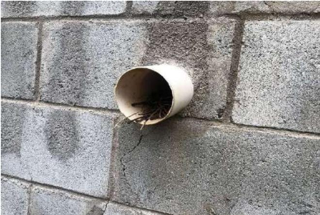
FOTO 115 DRENAGEM DO MURO COMPROMETIDA.
