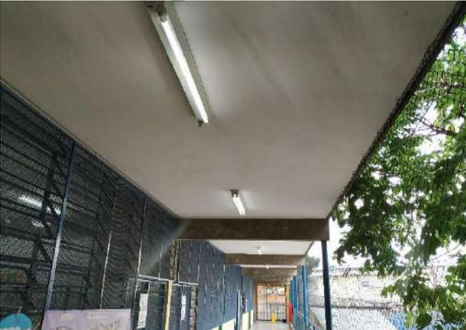
FOTO 25 Luminárias sobrepor com lâmpadas tubular de LED, corredor das salas de aula.
