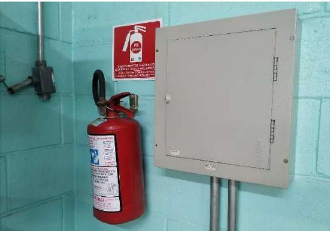
FOTO 21 Quadro de distribuição, instalado na sala de acolhimento.
