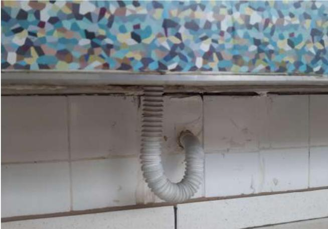
FOTO 61 Sifão sem vazamento
