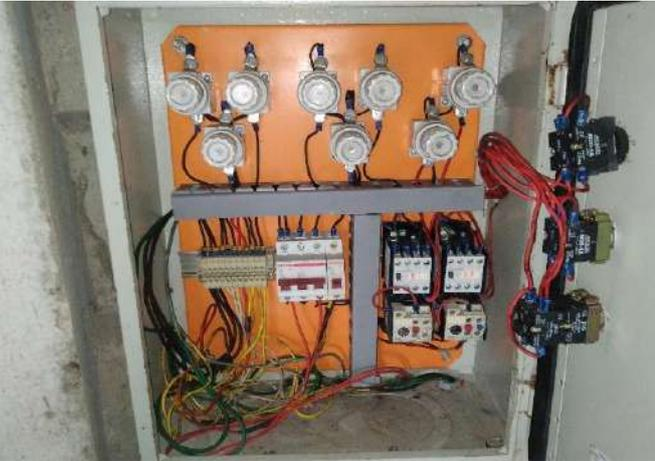
FOTO 79 Organizar os cabos elétricos e realizar limpeza no quadro.
