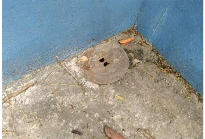
FOTO 8 Caixa de inspeção do aterramento.
