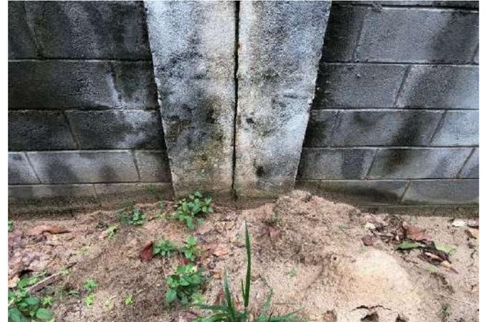
FOTO 110 MURO DE DIVISA, JUNTA DE DILATAÇÃO SEM TRATAMENTO.
