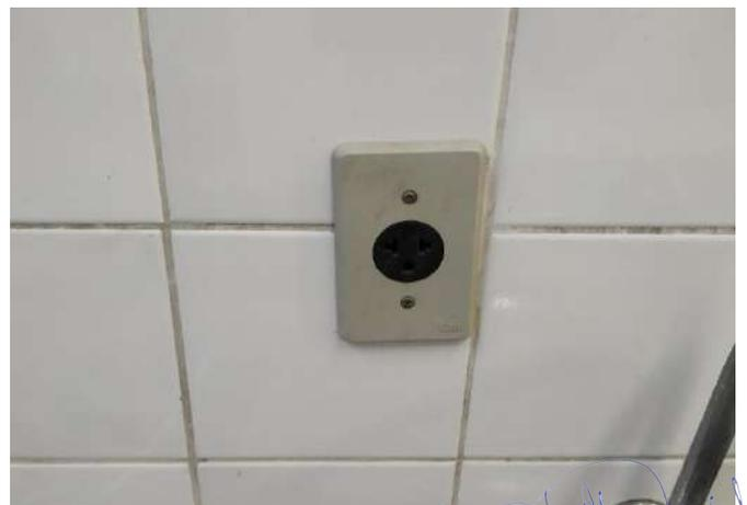
FOTO 60 Tomada padrão americano antigo, substituir por padrão brasileiro. Cozinha.
