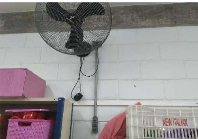
FOTO 71 Adaptação com extensão de tomadas, sala de aula 5. Instalar novos módulos de tomadas.
