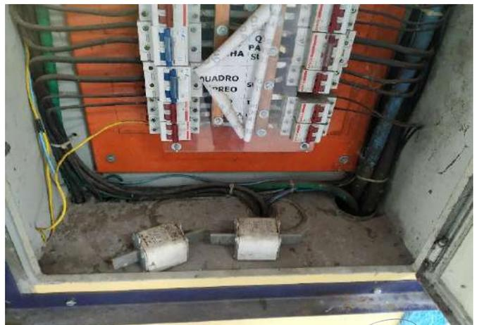
FOTO 12 Cabos elétricos fora do padrão de cores. Instalar conectores nos cabos de fase, junto aos disjuntores. Realizar limpeza no quadro.
