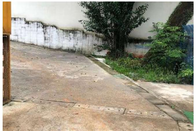
FOTO 88 ÁREA EXTERNA PISO CIMENTADO APRESENTA FALHAS E PONTOS OCOS.
