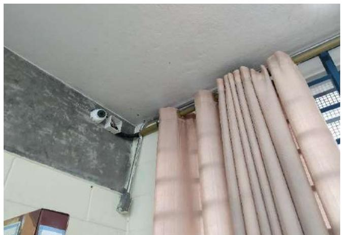
FOTO 82 Câmera de monitoramento, instalação do acabamento está sendo finalizada.
