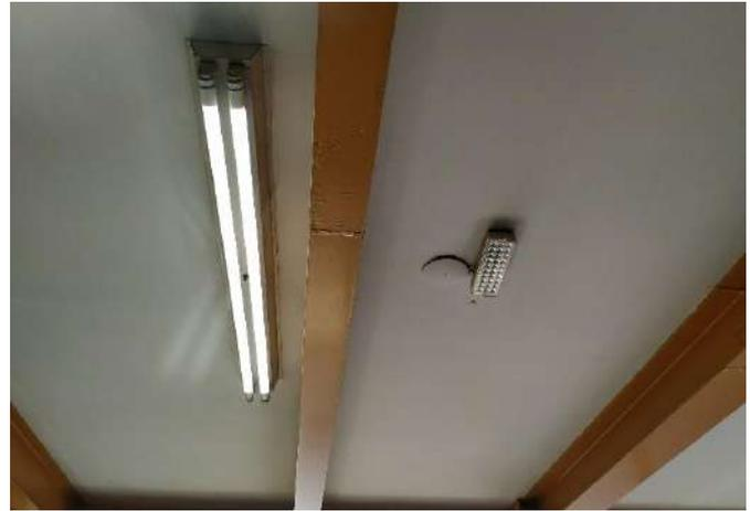
FOTO 32 Iluminação de emergência.
