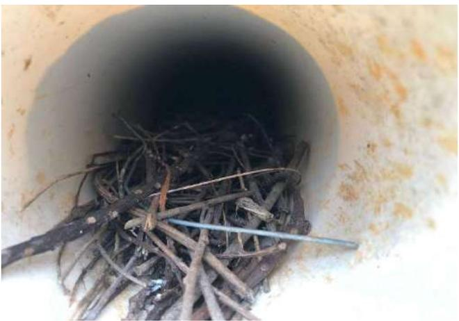
FOTO 113 DRENAGEM DO MURO COMPROMETIDA.
