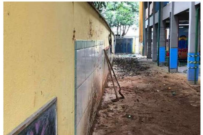
FOTO 82 PÁTIO DESCOBERTO, MURO EM DESAPRUMO.(EM MANUTENÇÃO)
