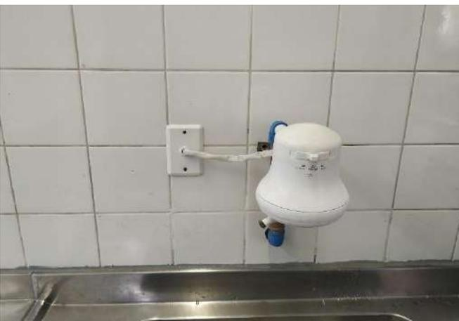
FOTO 23 Chuveiro elétrico, instalado na cozinha. Revisar os cabos de alimentação.
