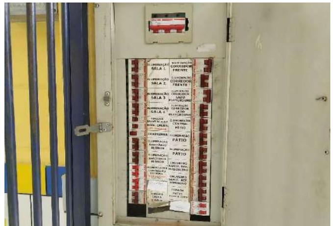
FOTO 16 Interior do quadro de distribuição. Refazer a identificação dos circuitos. Realizar revisão nos cabos de distribuição e conectores.
