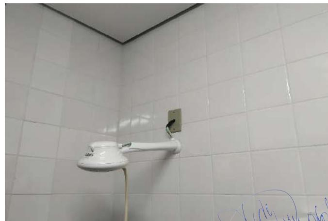
FOTO 24 Chuveiro, instalado no banheiro feminino, revisar os cabos de alimentação, instalar conector apropriado.
