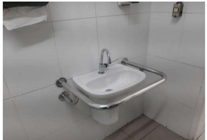
FOTO 28 Lavatório com barra de apoio
