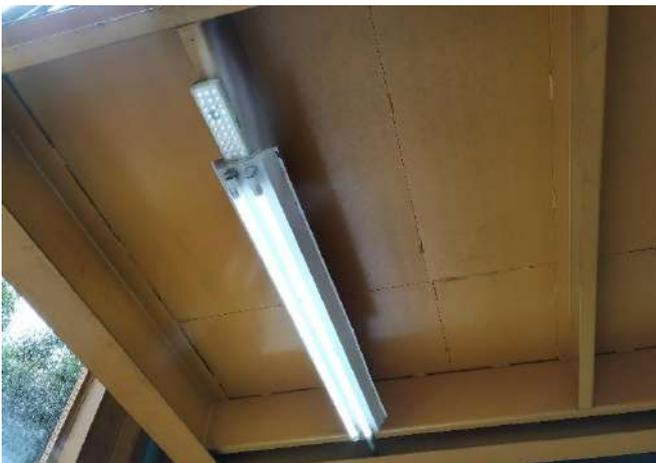
FOTO 33 Iluminação de emergência.
