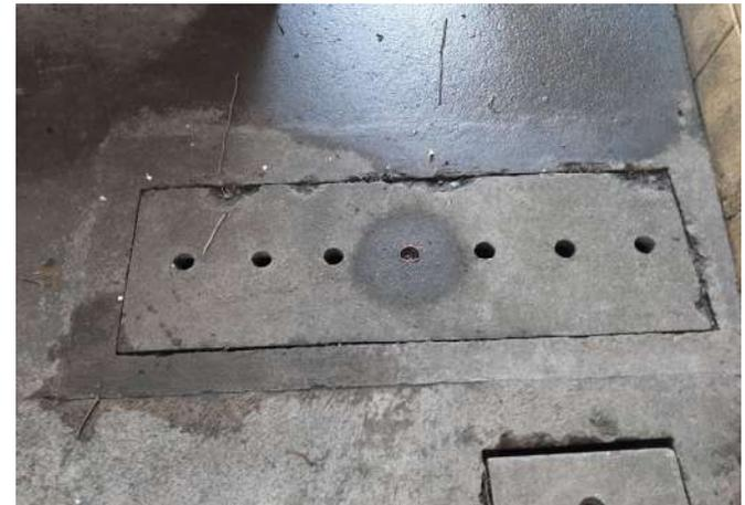
FOTO 46 Canaleta de tampa com furos de passagem
