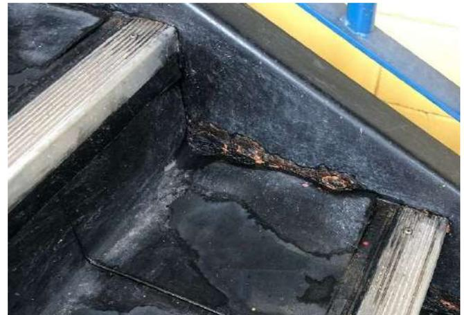
FOTO 34 ESCADA METÁLICA COM PONTO DE OXIDAÇÃO.
