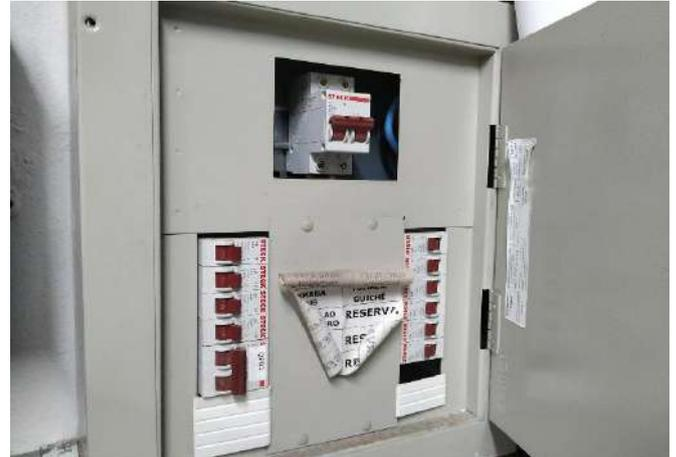
FOTO 20 Interior do quadro. Refazer a identificação dos circuitos. Realizar revisão nos cabos de distribuição e conectores.
