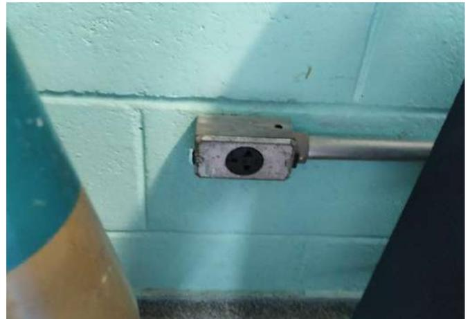
FOTO 64 Tomada padrão americano antigo, substituir por padrão brasileiro. Sala de acolhimento.
