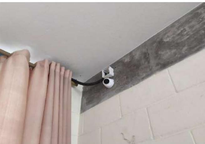
FOTO 83 Câmera de monitoramento, instalação do acabamento está sendo finalizada.
