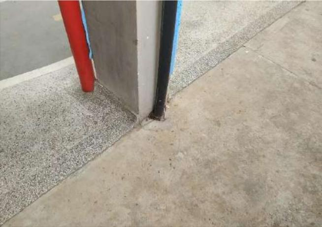
FOTO 7 Falta caixa de inspeção.
