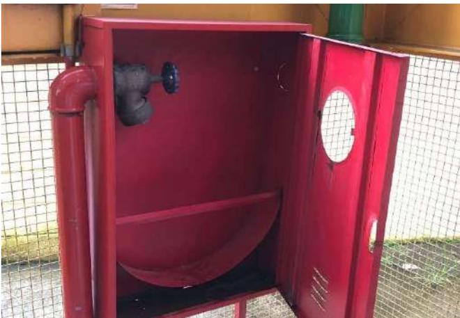
FOTO 39 HIDRANTE SEM SINALIZAÇÃO E COM AUSÊNCIA DE COMPONENTES.
