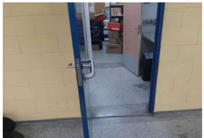
FOTO 30 Banheiro PNE com barra de apoio na porta
