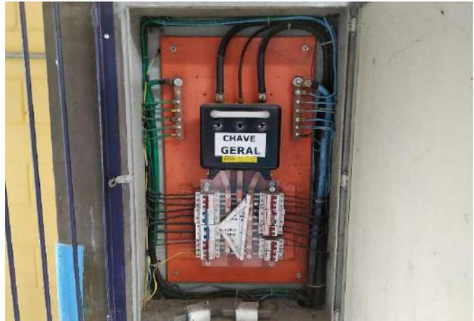
FOTO 10 Interior do QGBT. Realizar limpeza geral. Refazer a identificação dos circuitos.
