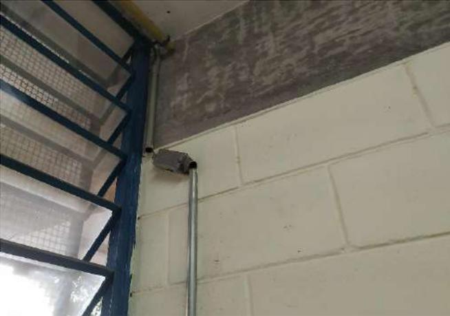
FOTO 67 Caixa do condutele solta da parede. Sala de aula 2.
