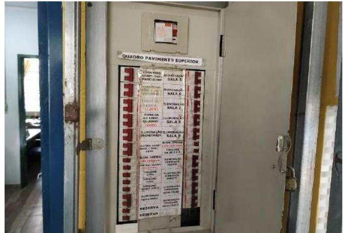
FOTO 14 Interior do quadro de distribuição. Refazer a identificação dos circuitos. Realizar revisão nos cabos de distribuição e conectores.
