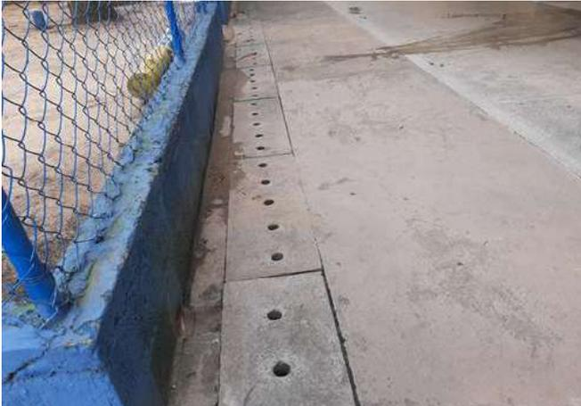
FOTO 43 Canaleta de tampa com furos de passagem
