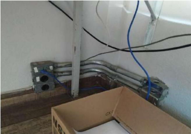
FOTO 55 Falta de tampa no condutele, sala da assistente.
