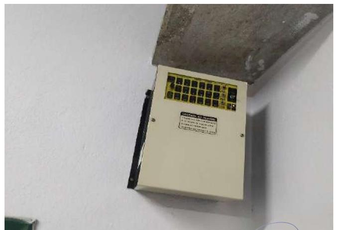
FOTO 36 Central de alarme de incêndio, revisar o sistema.
