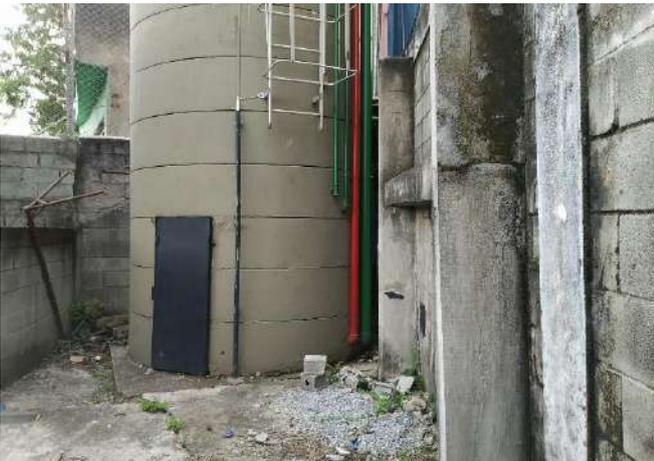
FOTO 9 Tubo de proteção no reservatório, não possui caixa de inspeção.
