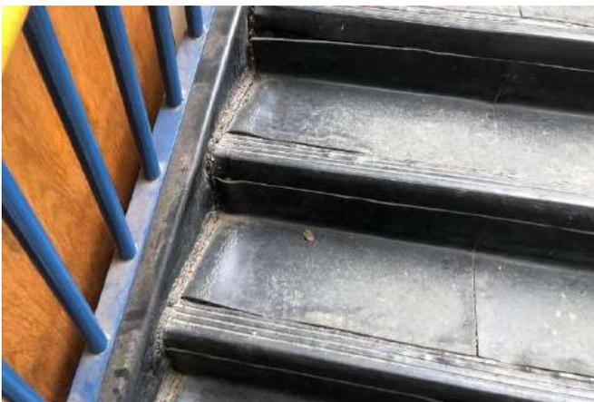
FOTO 129 ESCADA METÁLICA, PISO DANIFICADO.
