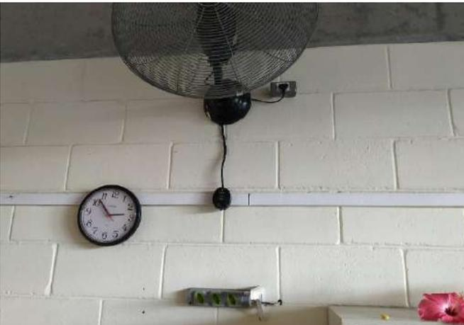
FOTO 69 Adaptação com extensão de tomadas, sala de aula 4. Instalar novos módulos de tomadas.
