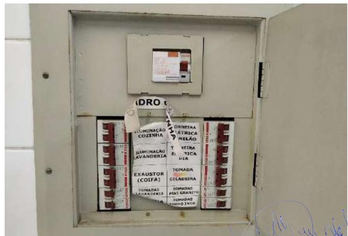
FOTO 18 Interior do quadro. Refazer a identificação dos circuitos. Realizar revisão no cabos de distribuição e conectores.
