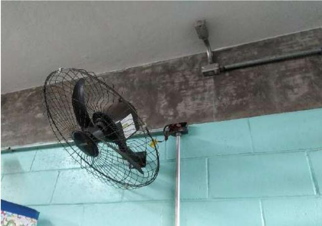
FOTO 91 Ventilador de parede, cabos elétricos expostos, sala de acolhimento.
