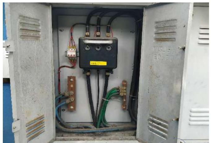
FOTO 6 Dispositivo de proteção. Conductor fase, neutro e terra.
