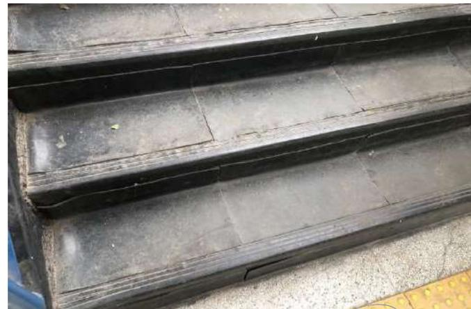
FOTO 126 ESCADA METÁLICA COM SINALIZAÇÃO TÁTIL DE ALERTA.
