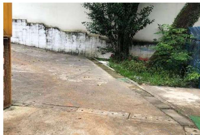
FOTO 84 ÁREA EXTERNA, PISO CIMENTADO APRESENTA FALHAS E PONTOS OCOS.
