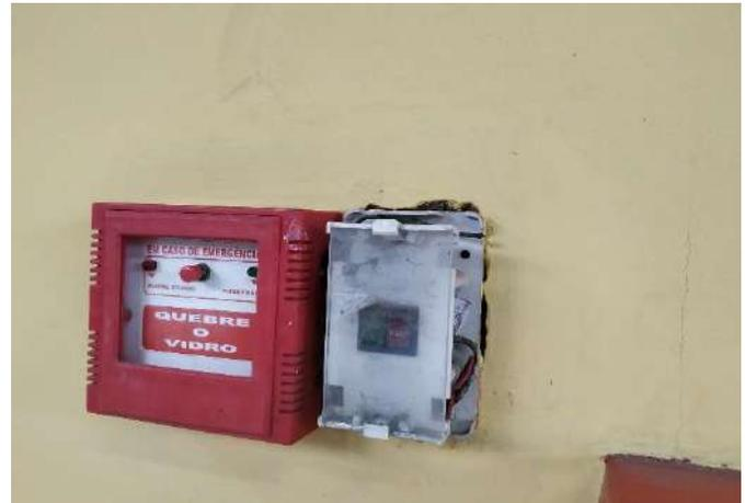
FOTO 20 Alarme e acionador manual, sem a caixa de proteção.
