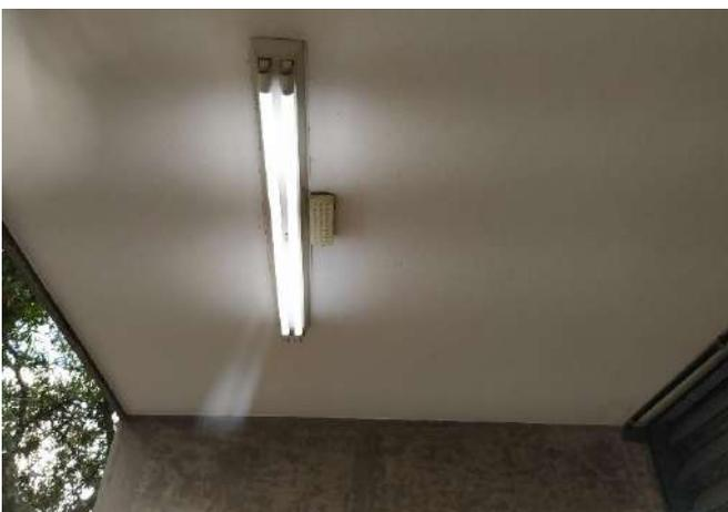
FOTO 35 Iluminação de emergência.
