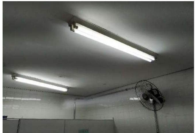
FOTO 28 Luminárias sobrepor com lâmpadas tubular de LED, refeitório dos professores.
