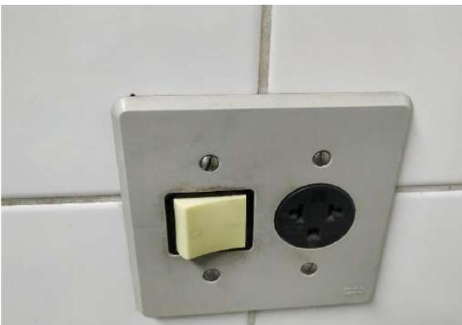
FOTO 59 Interruptor e tomada padrão americano antigo, substituir por padrão brasileiro. Cozinha.
