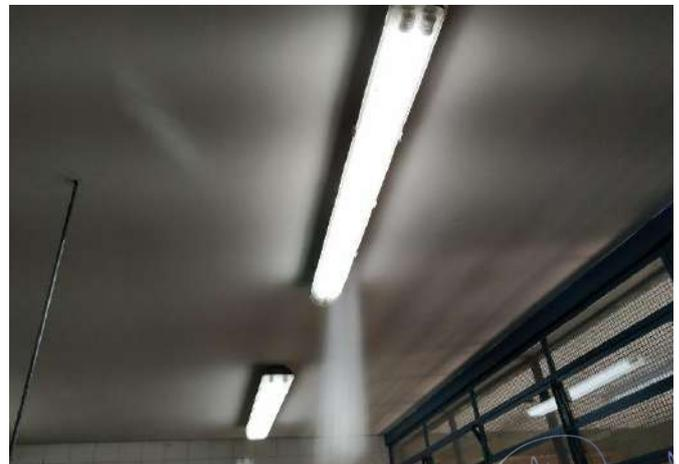
FOTO 30 Luminárias sobrepor com lâmpadas tubular de LED, com proteção, cozinha.
