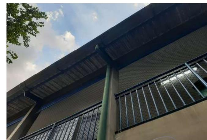
FOTO 42 Tubulação de descida da calha
