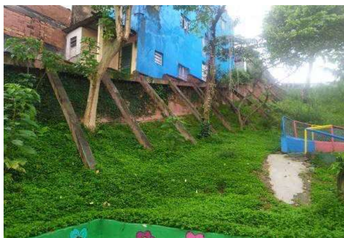
FOTO 48 Muro de divisa do lado esquerdo com contenção de vigas diagonais em concreto armado.
