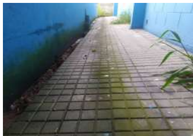
FOTO 82 Corredor externo das salas de aula.
