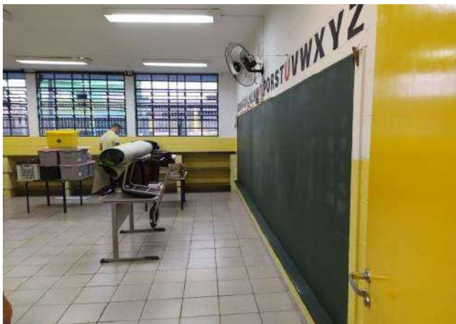
FOTO 19 Sala de aula 02.
