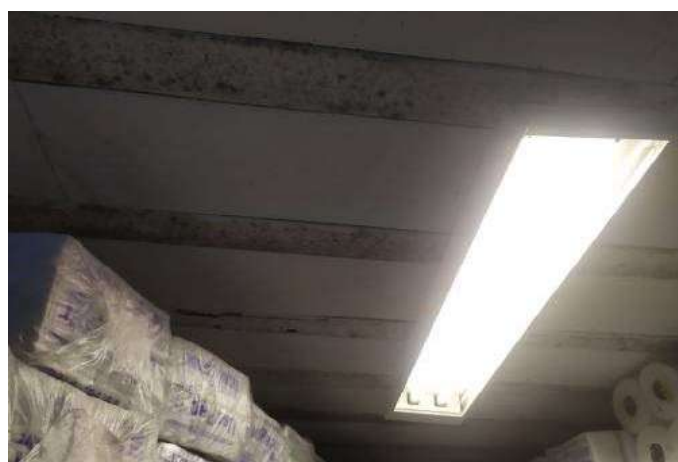
FOTO 52 Depósito de limpeza.
