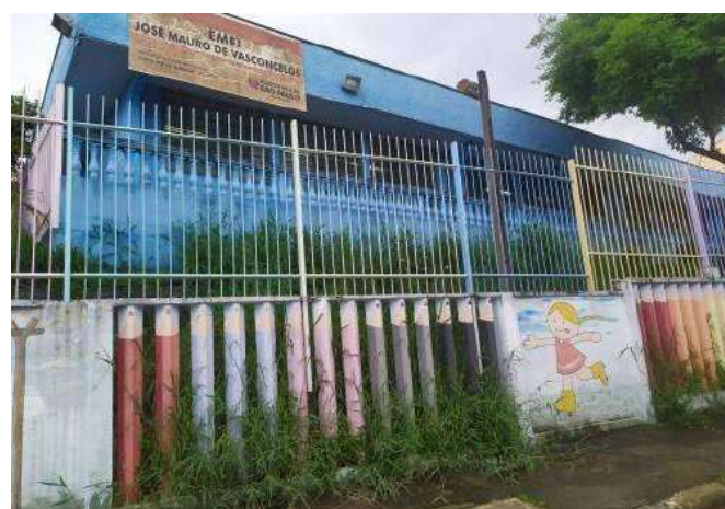
FOTO 84 Fachada da escola
