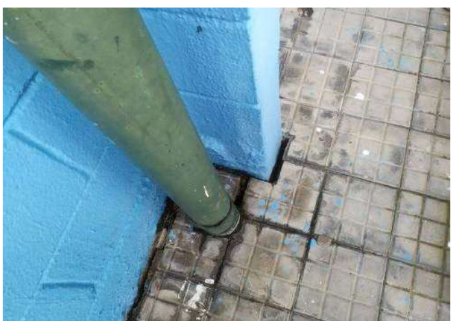
FOTO 81 Corredor externo das salas de aula.
