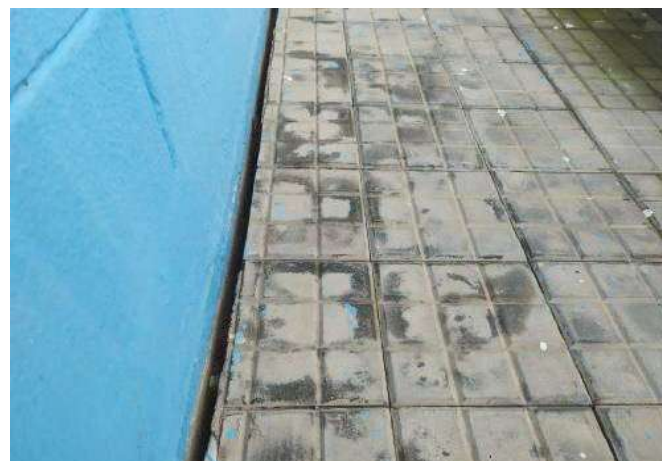
FOTO 80 Corredor externo das salas de aula.
