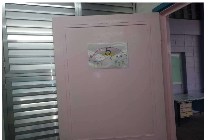
FOTO 35 Sala de Aula 05 - Identificação
