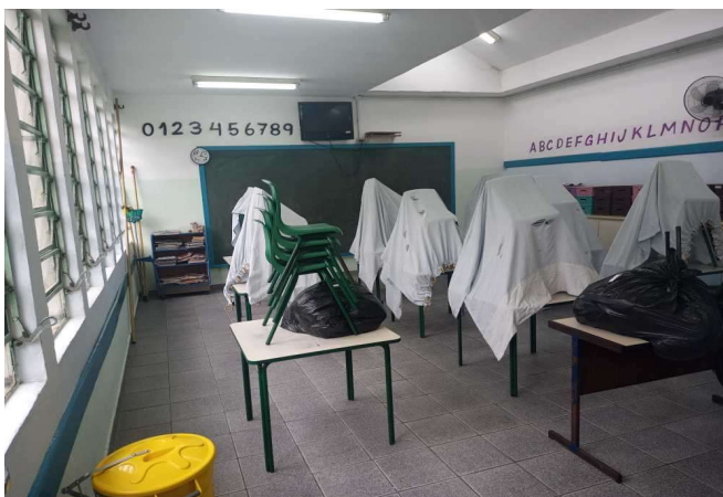
FOTO 41 Sala de Aula 08 - Visão geral
