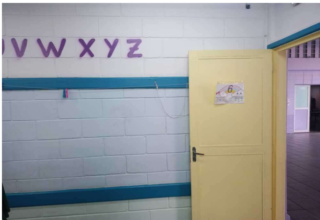
FOTO 37 Sala de aula 06 - Identificação
