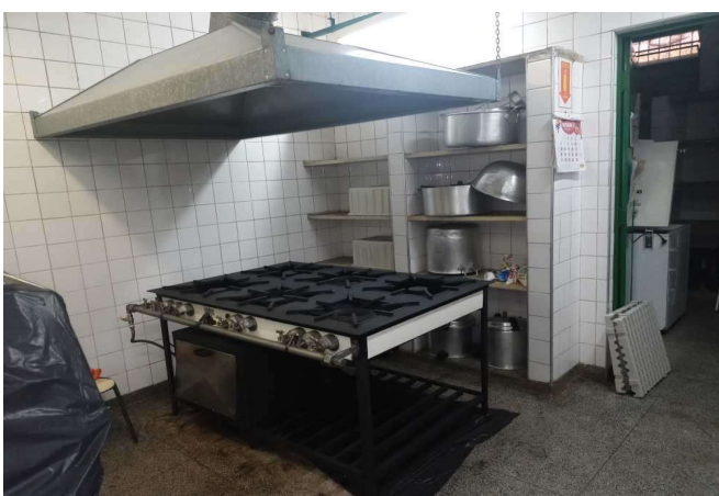
FOTO 10 Cozinha - Visão parcial
