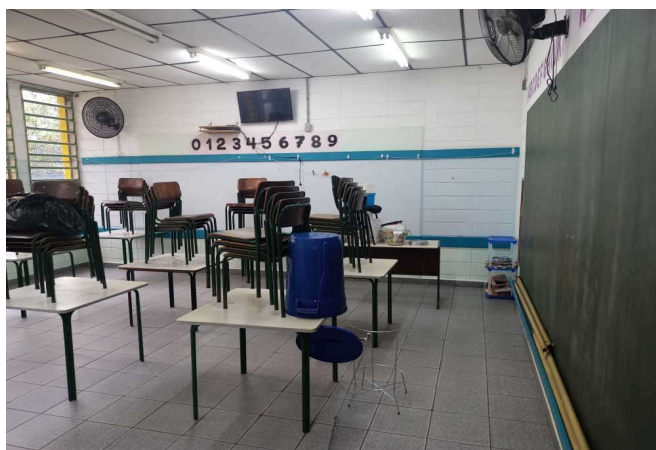
FOTO 33 Sala de Aula 03 - Visão geral
