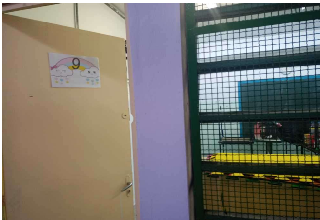
FOTO 43 Sala de Aula 09 - Identificação
