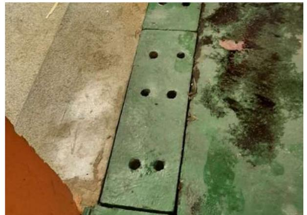
FOTO 102 CANALETA PRÓXIMA A ENTRADA COM INSULFICIÊNCIA NA VAZÃO
