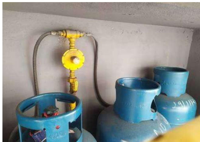
FOTO 128 abrigo de gas
