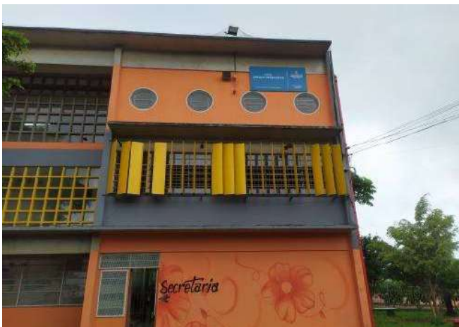
FOTO 1 Fachada da unidade
