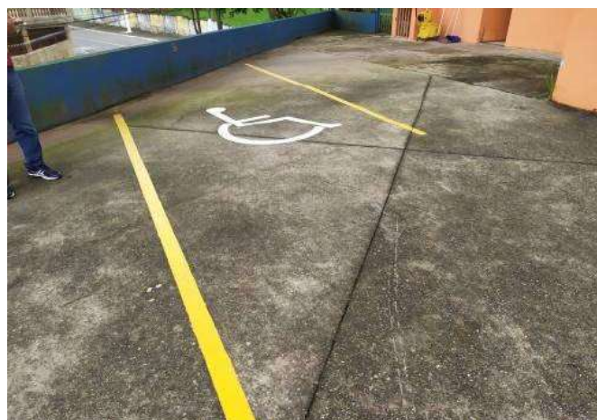
FOTO 126 Estacionamento em bom estado
