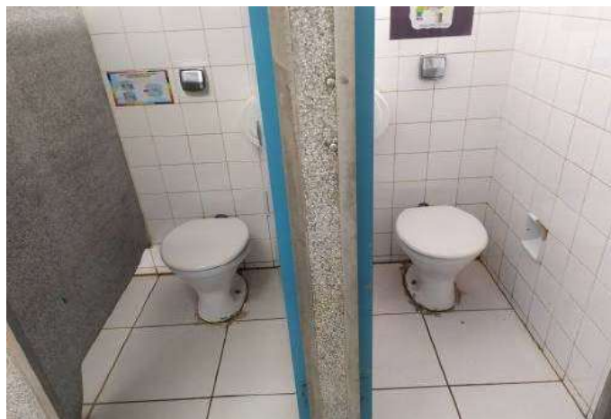
FOTO 56 wc banheiro masculino
