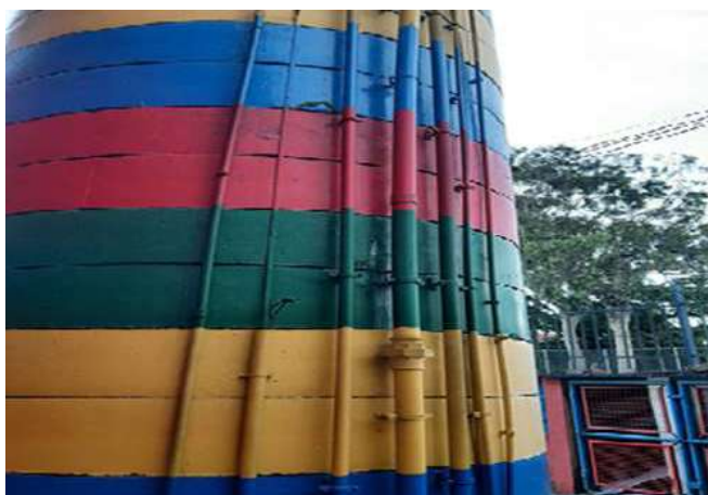
FOTO 57 RESERVATÓRIO, DE ACORDO
