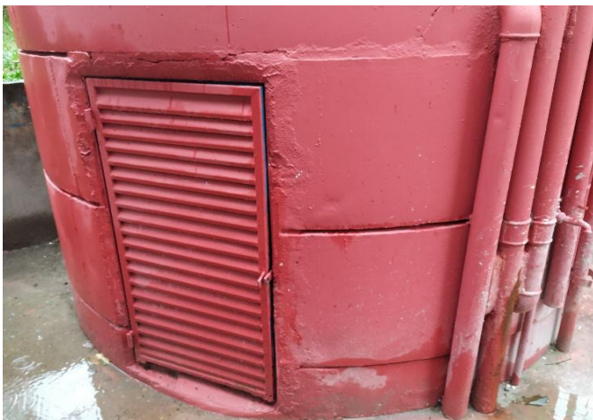
FOTO 7 Casa de bombas.
