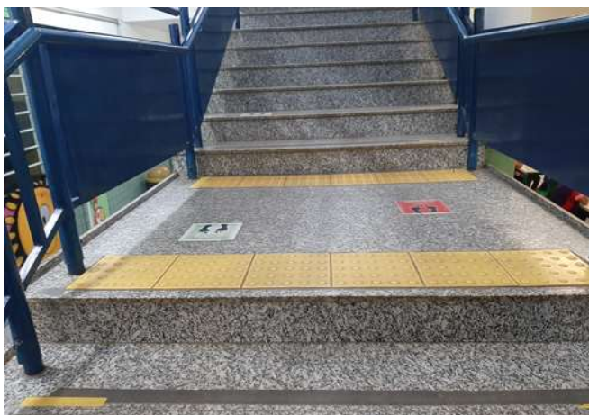
FOTO 17 Patamar da escada
