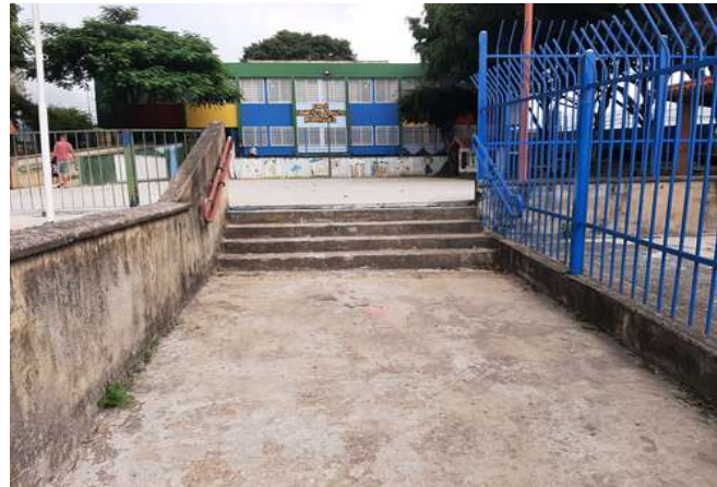
FOTO 32 Corredor externo acesso a unidade
