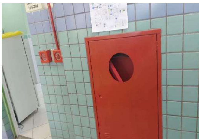
FOTO 6 REPARO NO SISTEMA DE HIDRANTE - INCÊNDIO
