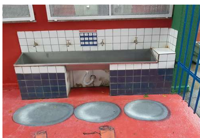
FOTO 58 Bebedouro, torneias de uso geral sem arejador
