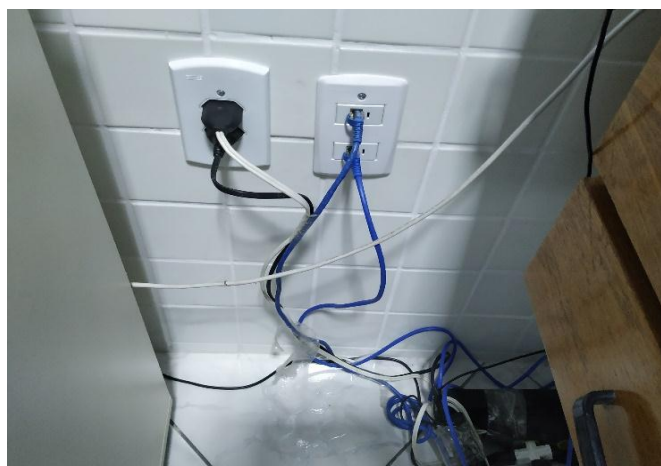
FOTO 70 Tomadas padrão brasileiro, sala da coordenação.
