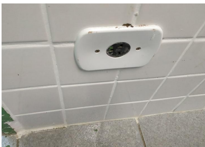
FOTO 64 Tomada padrão americano antiga, substituir por padrão brasileiro, sala de reunião.
