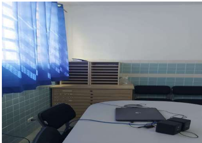
FOTO 36 INFILTRAÇÃO SALA DOS PROFESSORES
