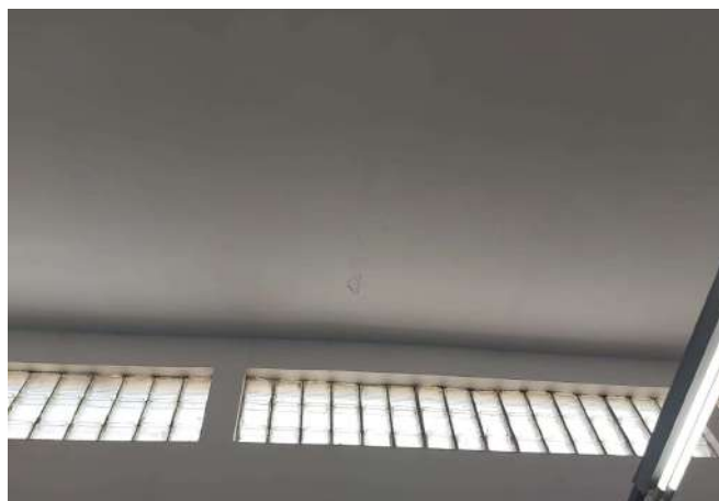
FOTO 32 TRINCAS NAS SALAS DE AULA
