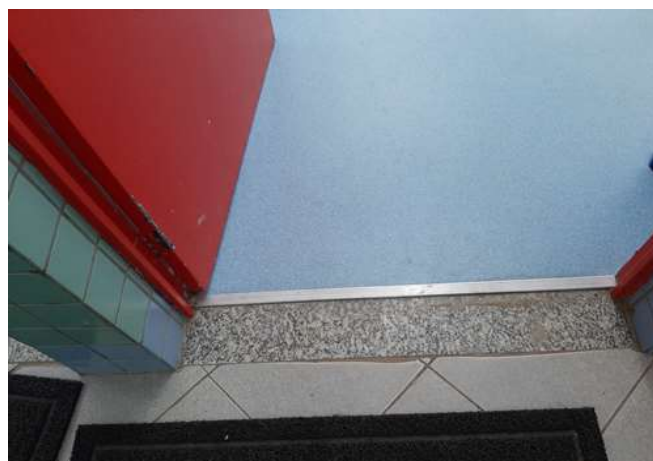
FOTO 21 Soleira sala de aula
