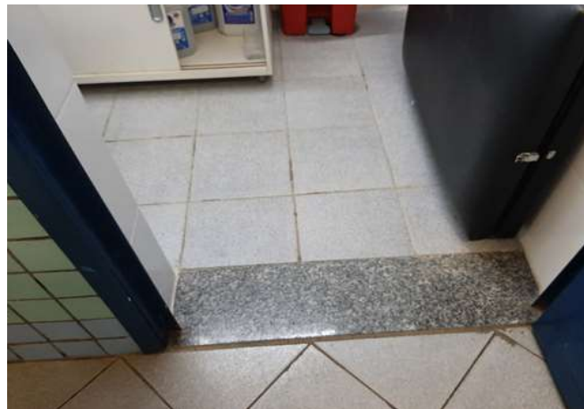
FOTO 26 Soleira banheiro PNE
