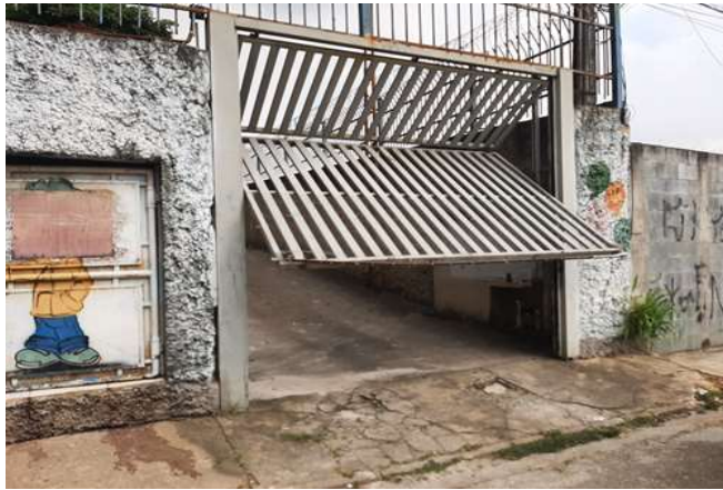
FOTO 4 Portão de acesso ao estacionamento
