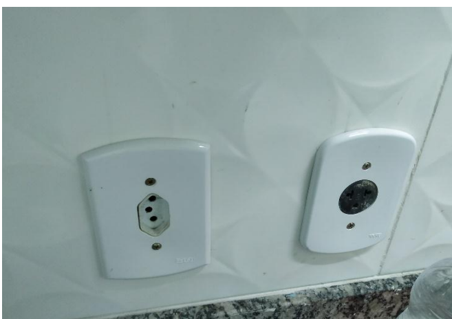
FOTO 59 Tomada padrão americano antiga, substituir por padrão brasileiro, refeitório dos professores.
