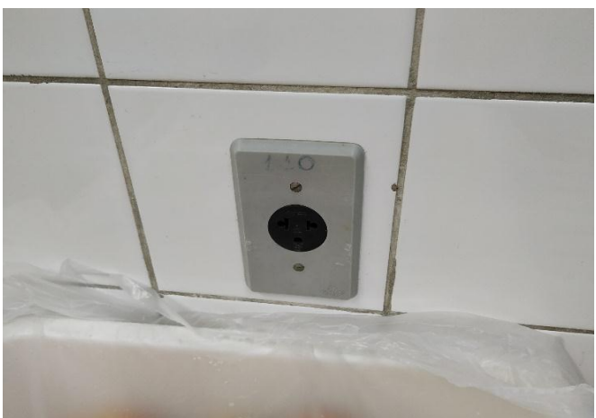
FOTO 71 Tomadas padrão americano antiga, substituir por padrão brasileiro, cozinha.
