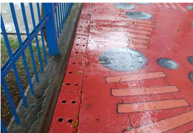
FOTO 57 Grelha de concreto, área externa
