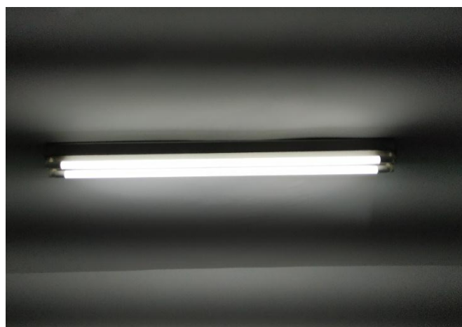
FOTO 30 Luminária sobrepor com lâmpadas tubular de LED.
