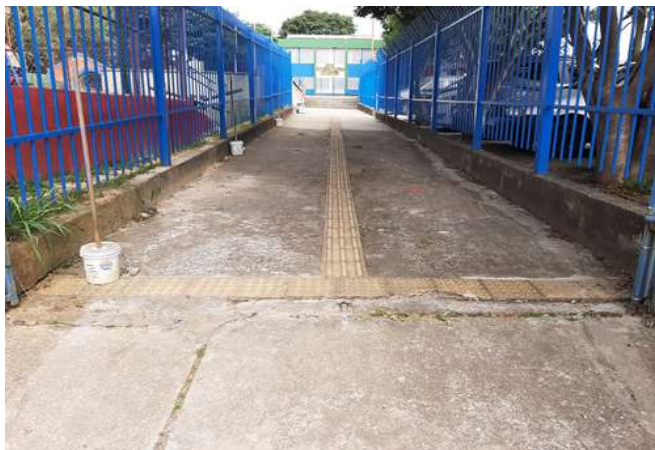
FOTO 7 Corredor externo, acesso a unidade
