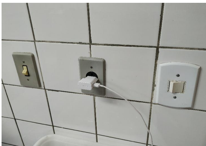
FOTO 47 Interruptores da cozinha.
