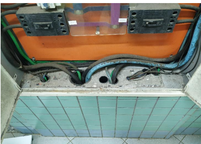
FOTO 11 Realizar limpeza geral no quadro.
