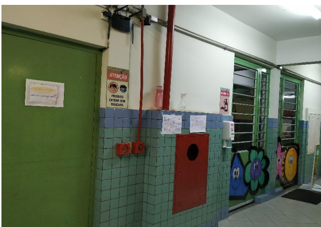
FOTO 11 Abrigo do hidrante, piso térreo, refeitório.
