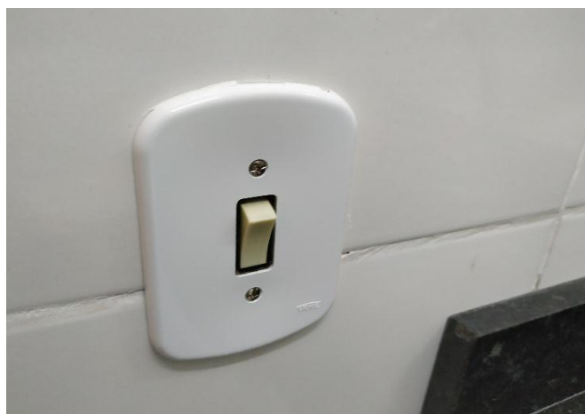
FOTO 48 Interruptor no banheiro infantil masculino.
