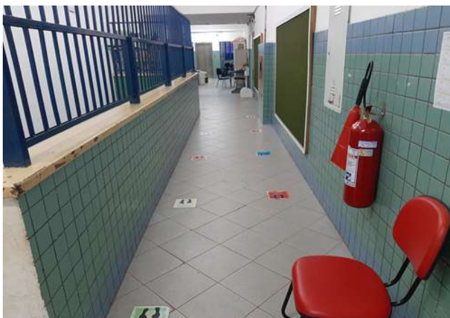
FOTO 19 Circulação horizontal, corredor das salas
