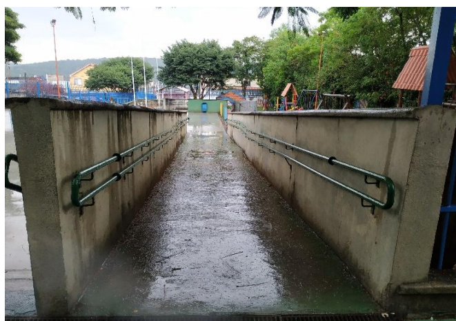
FOTO 30 Rampa com corrimão em ambos os lados.
