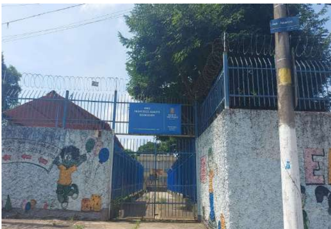
FOTO 1 FACHADA DA ESCOLA
