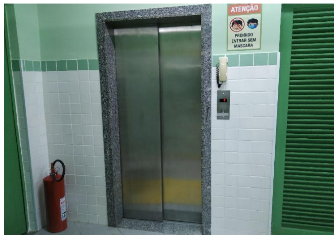
FOTO 86 Elevador, piso térreo.
