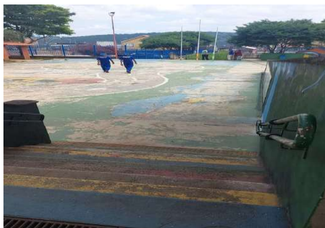
FOTO 47 PINTURA E TRATAMENTOS DE TRINCAS NA QUADRA
