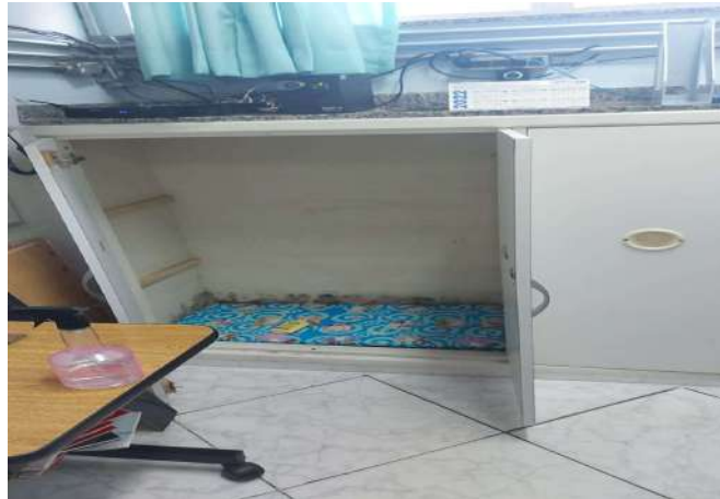
FOTO 2 INFILTRAÇÃO E MOFO NO ARMÁRIO DA SECRETARIA
