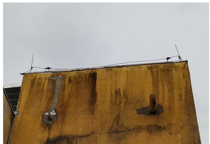
FOTO 4 Captores Franklin. Prédio da unidade.
