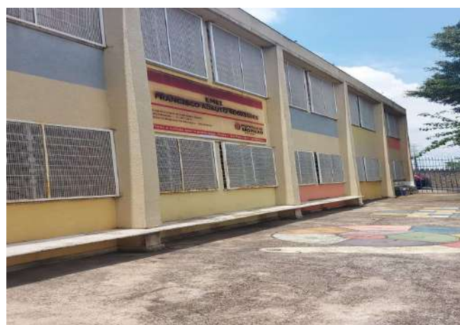
FOTO 48 TRATAMENTO DE GRADIL E BANCOS
