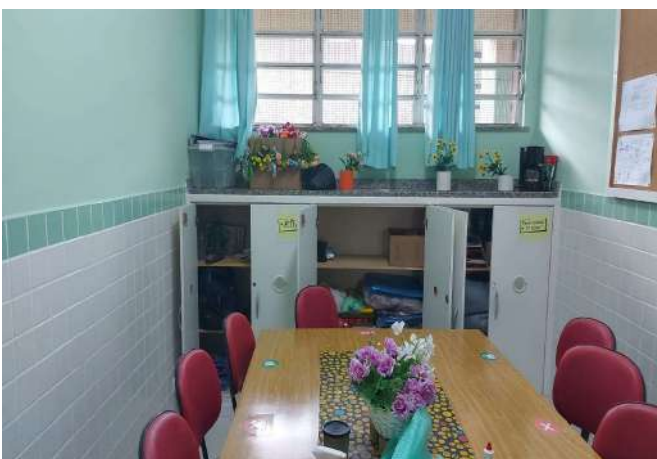
FOTO 5 INFILTRAÇÃO E MOFO ARMÁRIO DO REFEITÓRIO DOS FUNCIONÁRIOS
