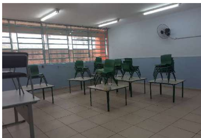
FOTO 120 Sala 2 - Visão geral
