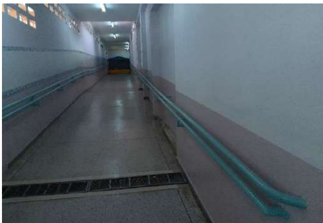
FOTO 167 Acessibilidade - Rampa interna
