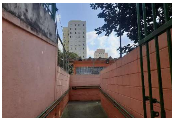
FOTO 168 Acessibilidade - Rampa secretaria
