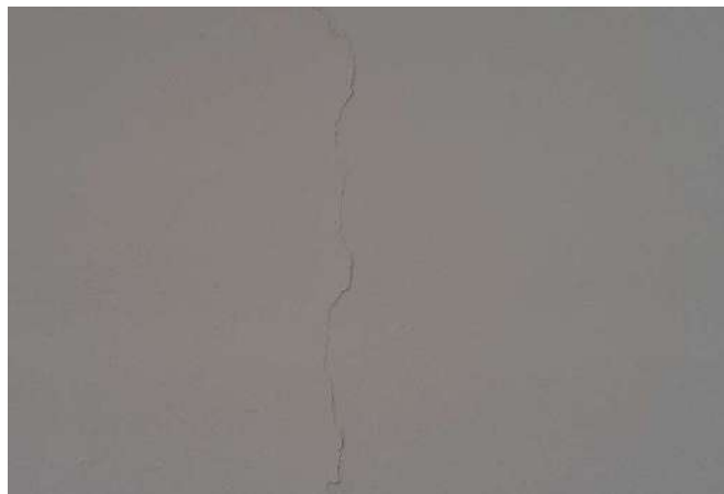
FOTO 110 Sala da Coordenação e Professores - Trinca
