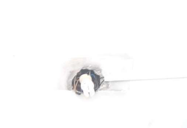
FOTO 27 Depósito - Improviso elétrico
