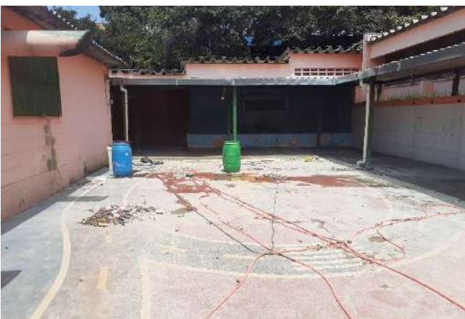
FOTO 71 Pátio descoberto - Visão geral (Em reforma)
