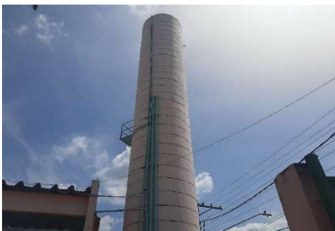
FOTO 165 Caixa da Água - Visão geral
