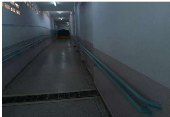
FOTO 44 Rampa (Acesso as salas) - Visão geral
