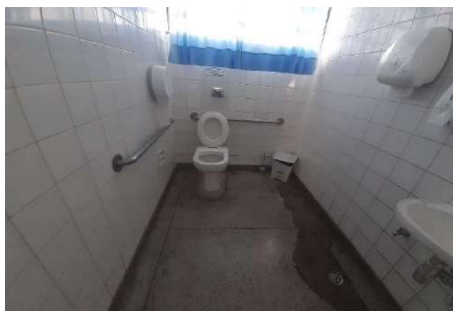
FOTO 156 Sanit Deficiente Unissex - Visão geral
