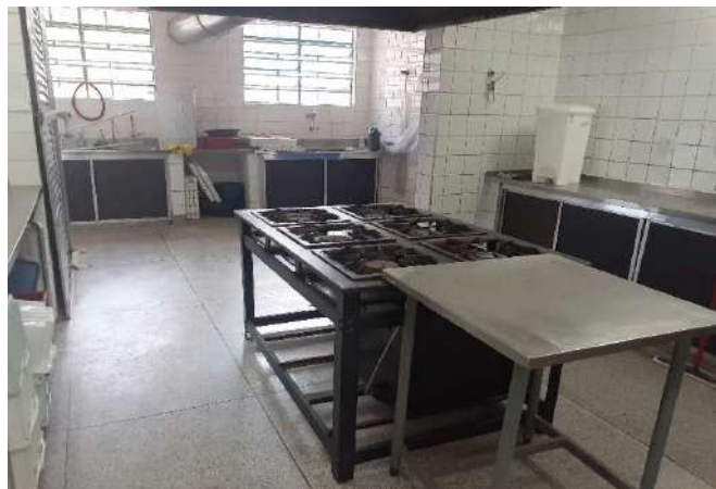
FOTO 14 Cozinha - Visão geral
