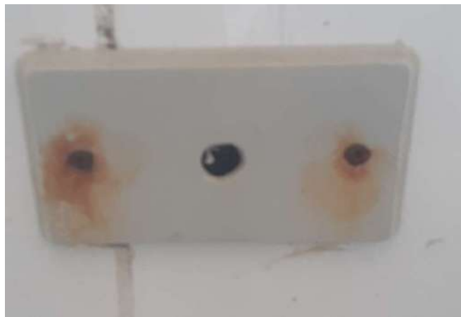
FOTO 20 Cozinha - Espelho da tomada oxidado
