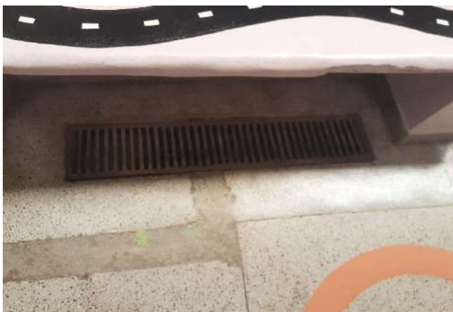
FOTO 65 Pátio Coberto - Grelha desencaixada
