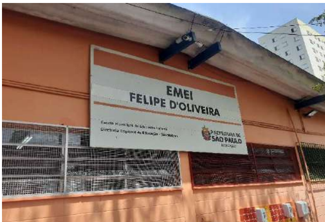
FOTO 1 Fachada/ Entrada - Visão geral
