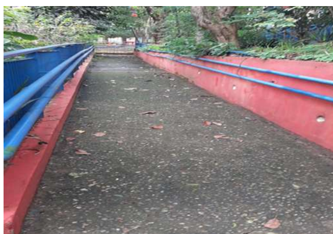
FOTO 64 RAMPA DE ACESSO A UNIDADE
