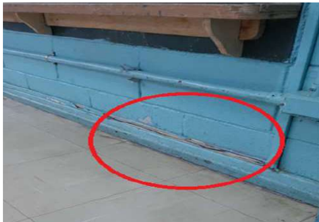
FOTO 18 FIAÇÃO ELÉTRICA SEM PROTEÇÃO, SALA AZUL
