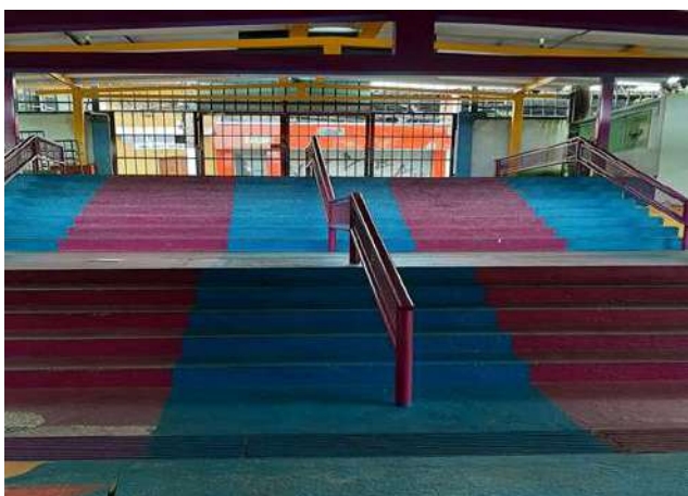
FOTO 65 ESCADA DE ACESSO A UNIDADE
