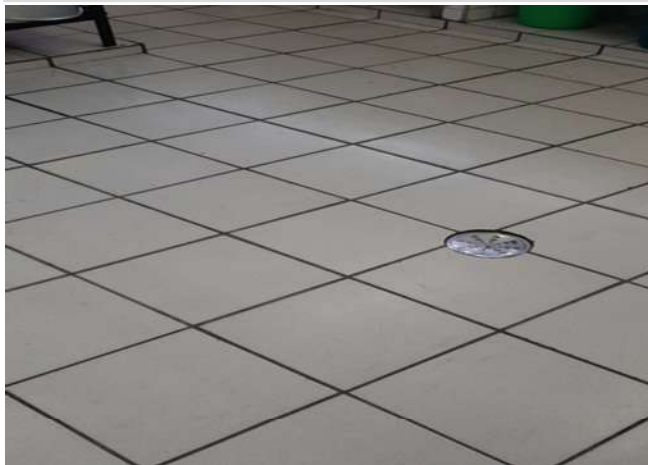
FOTO 37 PISO COZINHA, EM BOM ESTADO
