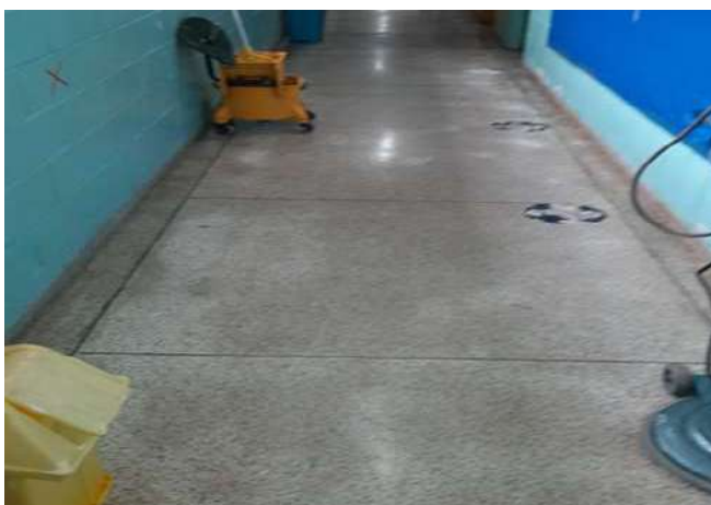
FOTO 21 CORREDOR DAS SALAS
