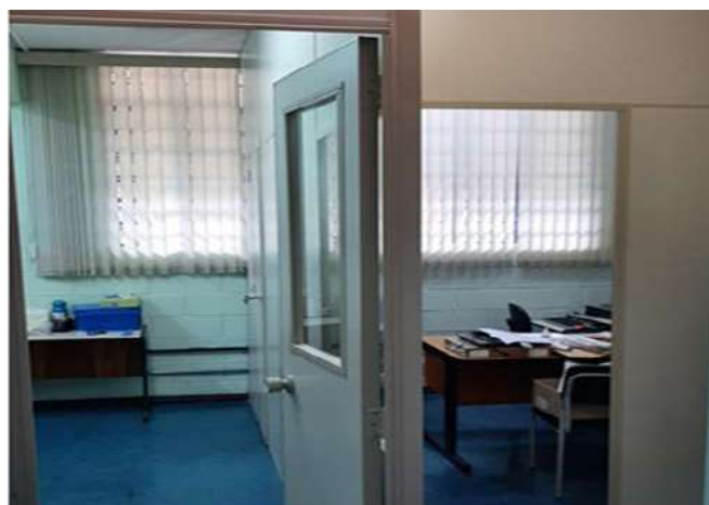
FOTO 34 SALAS DA GESTÃO EM BOM ESTADO
