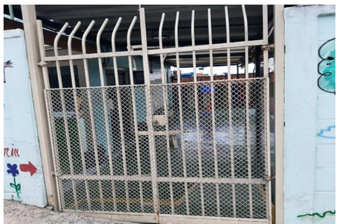
FOTO 4 Portão de acesso à unidade, visão externa
