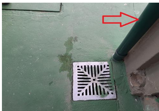
FOTO 40 Tubulação PVC descida do telhado
