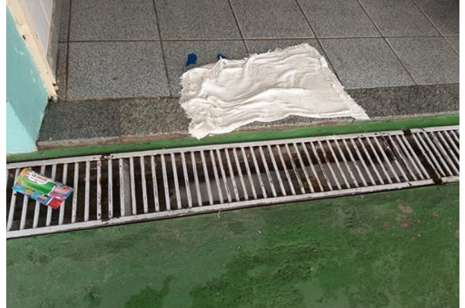
FOTO 8 Grelha e tropeço, entrada do refeitório
