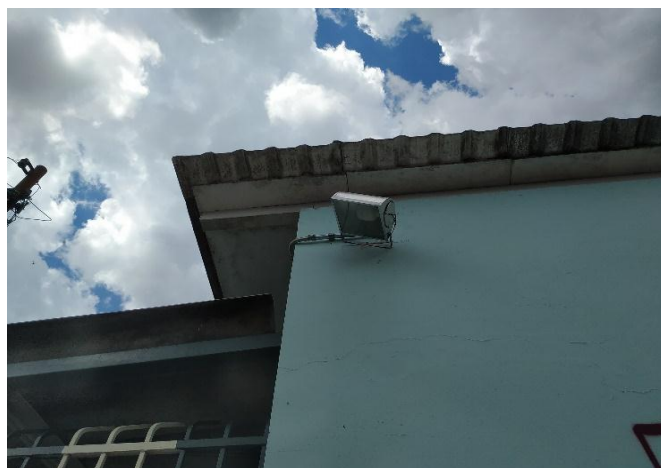
FOTO 46 Refletor com lâmpada de LED, frente da escola.
