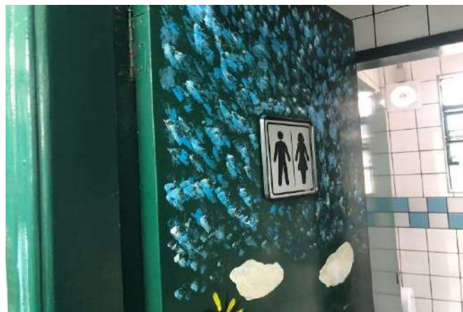
FOTO 56 BANHEIRO UNISSEX ADMINISTRATIVO.
