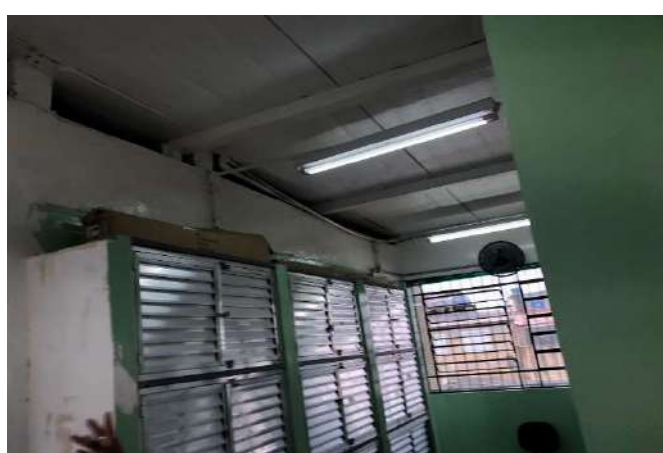
FOTO 84 CORREDOR INTERNO - DEPÓSITO E ALMOXARIFADO ADAPTADOS.
