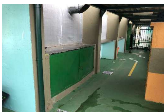
FOTO 12 ÁREA EXTERNA, CORREDOR COBERTO.
