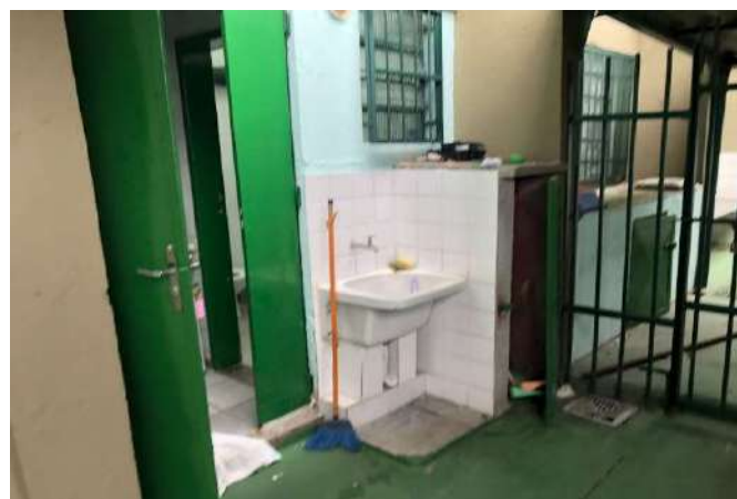
FOTO 14 BANHEIRO FEMININO FUNCIONÁRIOS.
