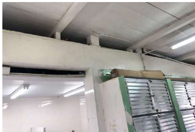
FOTO 86 CORREDOR INTERNO - ARMÁRIO (ALMOXARIFADO).
