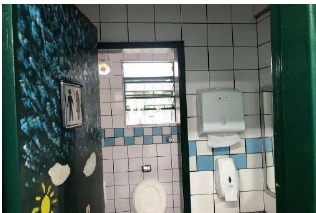
FOTO 51 BANHEIRO UNISSEX ADMINISTRATIVO.
