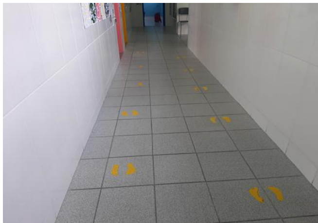
FOTO 13 Circulação horizontal, corredor das salas
