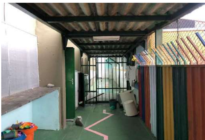
FOTO 11 ÁREA EXTERNA, CORREDOR COBERTO.
