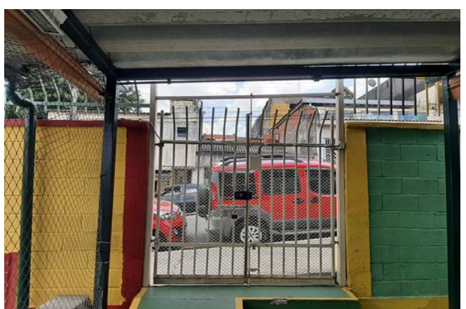
FOTO 6 Vista interna do portão de acesso à unidade
