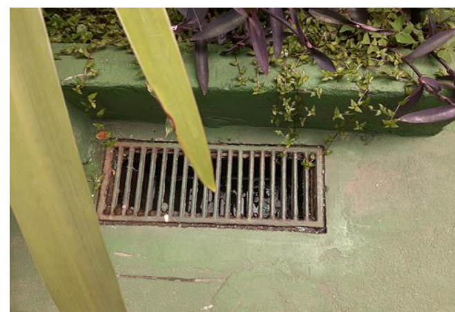
FOTO 41 Grelha da caixa de passagem, jardim
