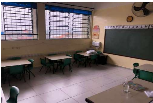
FOTO 81 SALA DE AULA 02.
