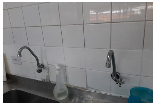
FOTO 48 Torneiras de parede, arejador parcial
