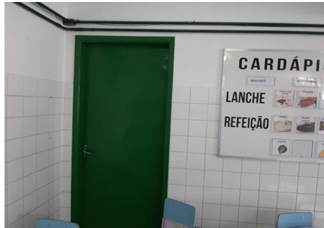
FOTO 30 Porta de acesso à cozinha
