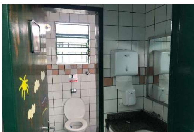
FOTO 54 BANHEIRO FEMININO ADMINISTRATIVO.
