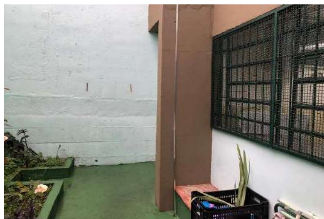
FOTO 44 SPDA - GRADIL - FACHADA.
