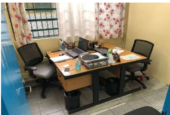
FOTO 63 SALA DA COORDENAÇÃO, PISO CERÂMICO E AUSÊNCIA DE RODAPÉ.
