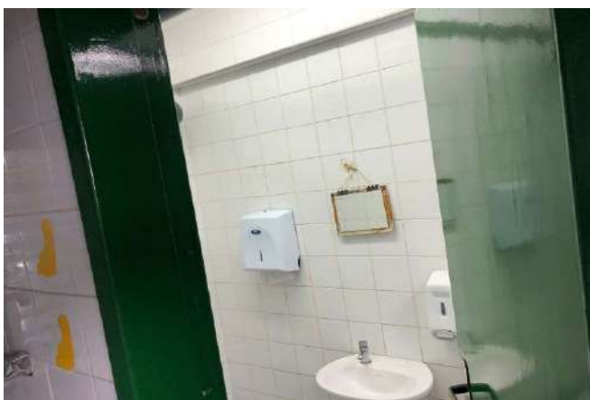
FOTO 15 BANHEIRO FEMININO FUNCIONÁRIOS.
