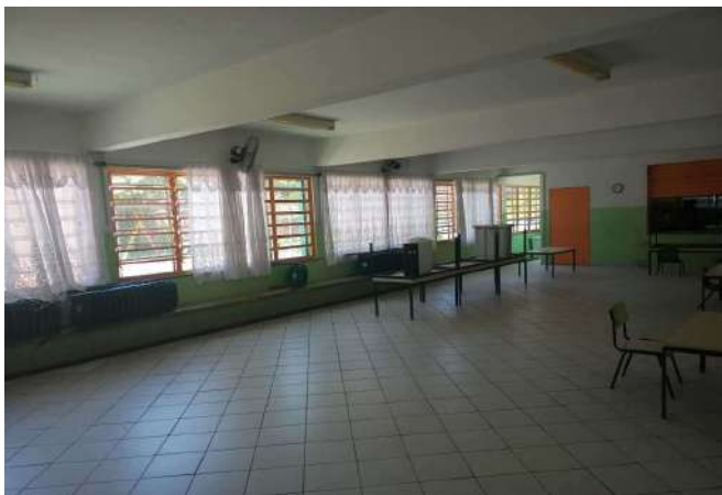
FOTO 13 Refeitório - Visão geral
