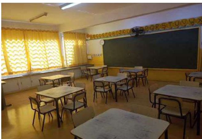
FOTO 33 Sala de Aula 03 - Visão geral
