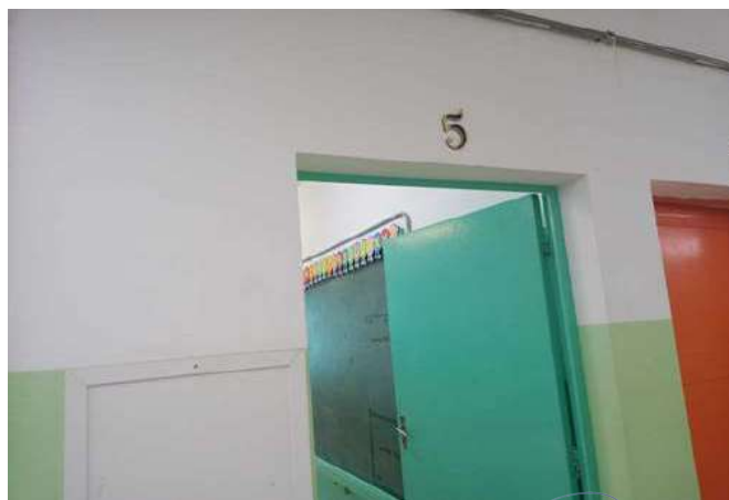
FOTO 36 Sala de Aula 05 - Identificação
