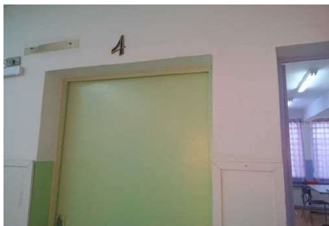
FOTO 34 Sala de Aula 04 - Identificação
