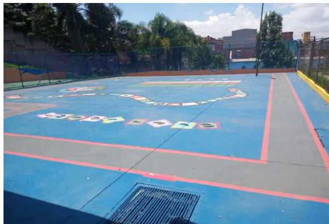
FOTO 8 Pátio Descoberto - Visão geral
