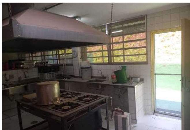
FOTO 10 Cozinha - Visão geral
